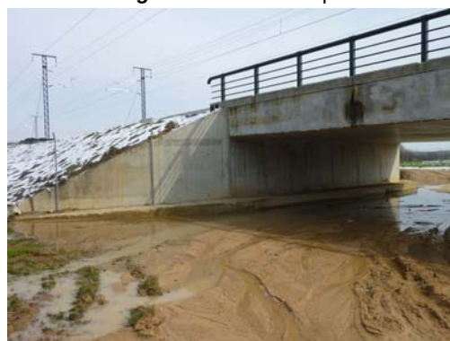
Fotografía nº 6. Estribo de salida
