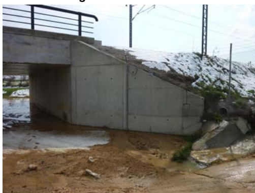
Fotografía nº 5. Estribo de entrada
