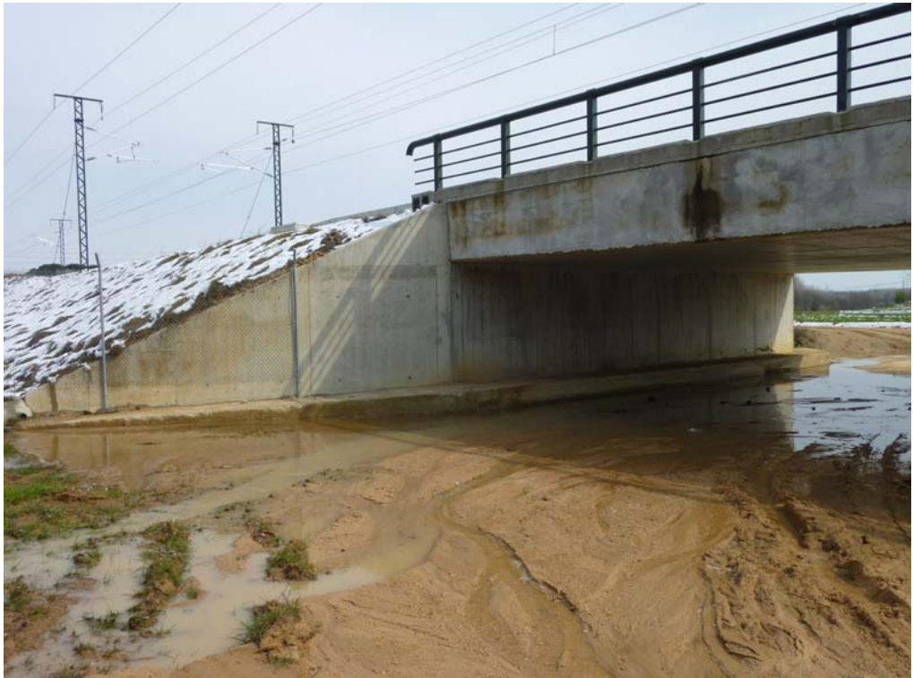
Fotografía 408: estribo de salida
