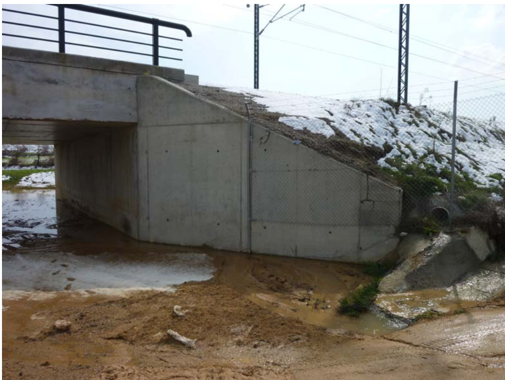
Fotografía 407: Estribo de entrada
