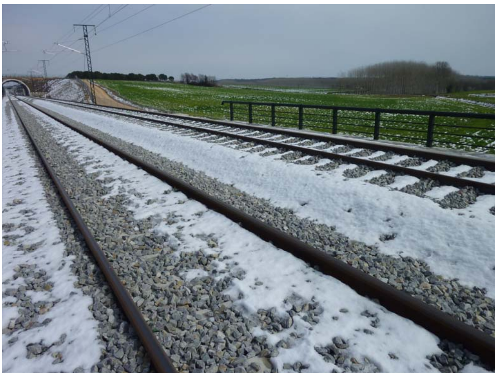
Fotografía 414: Material de vía
