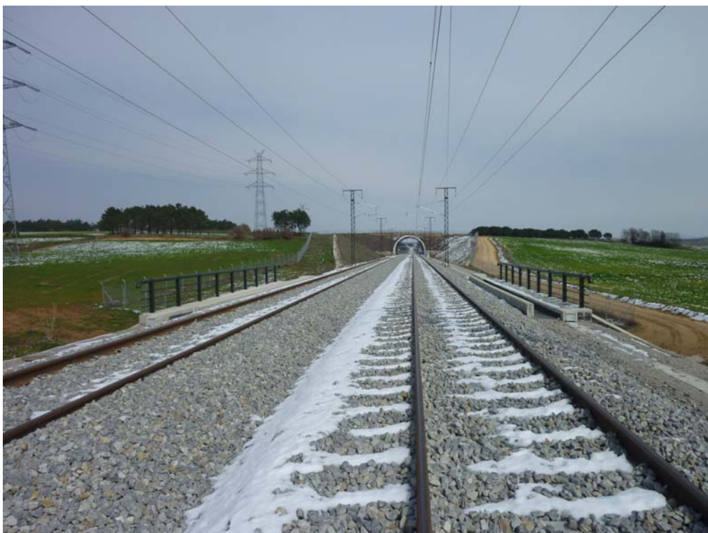
Fotografía 411: vista desde E1 hacia E2
