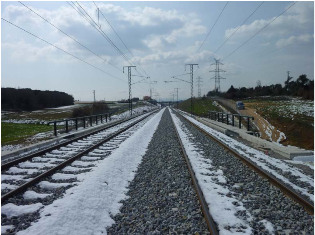
Fotografía 416: Vista desde E2 hacia E1
