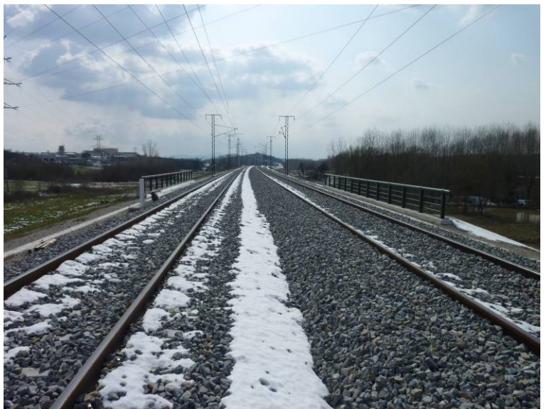
Fotografía N°6: Vista desde el estribo 2.
