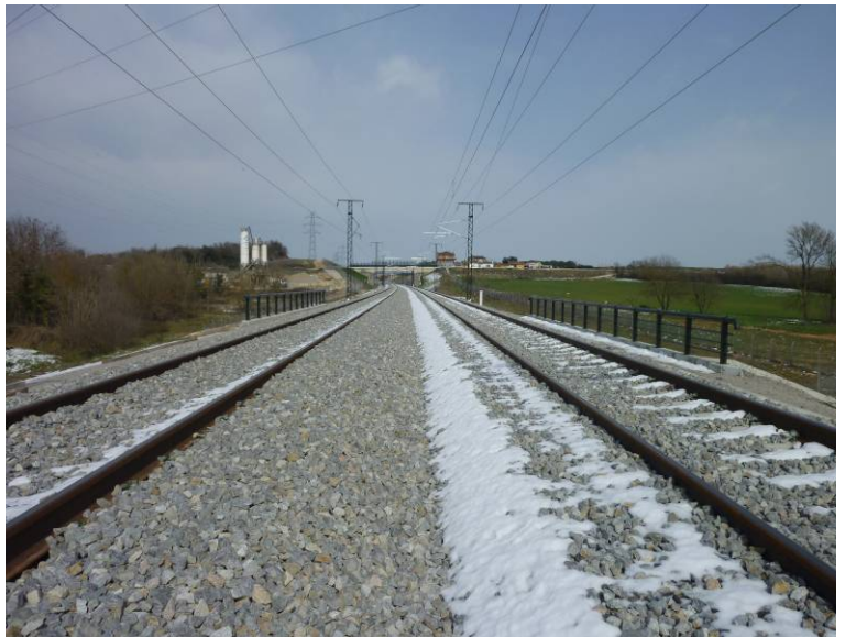
Fotografía N°5: Vista desde el estribo 1.
