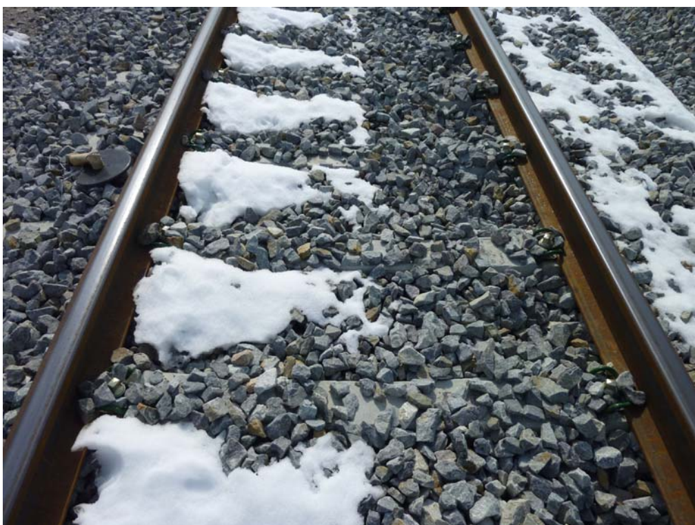
Material de vía
