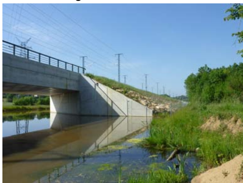
Fotografía nº 5. Estribo de entrada
