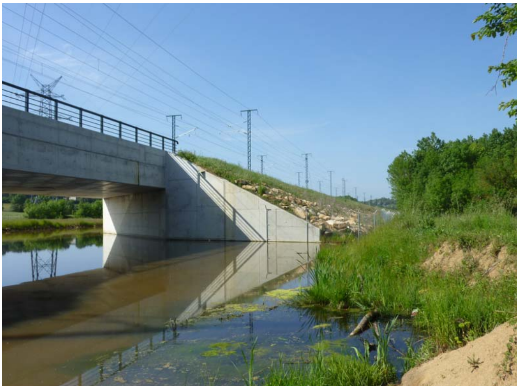
Estribo de entrada
