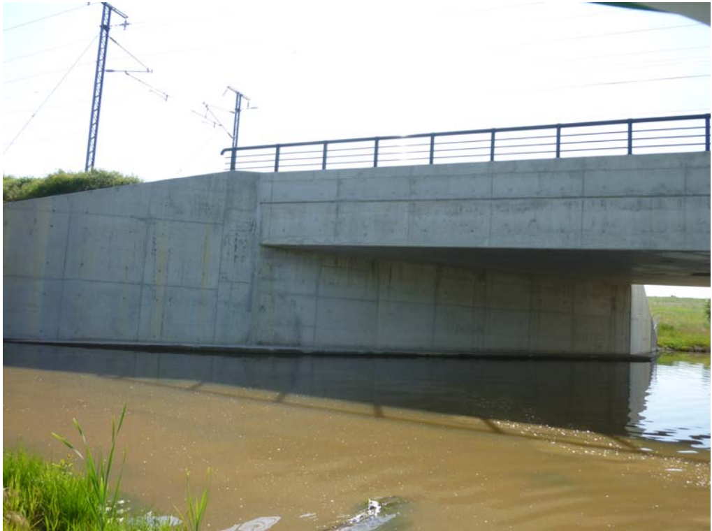
Estribo de salida
