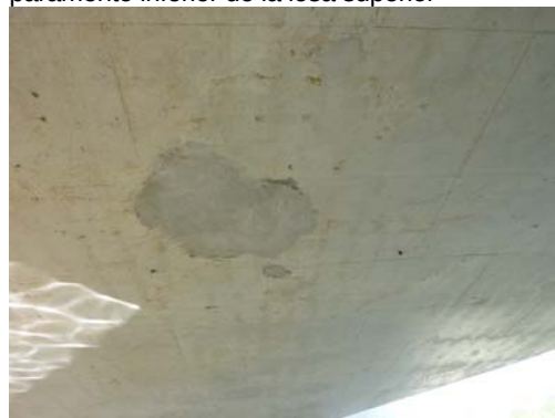
Fotografía nº 12. Reparaciones en el paramento inferior de la losa
