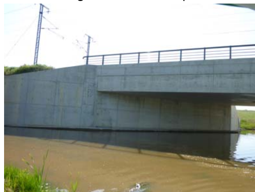
Fotografía nº 6. Estribo de salida
