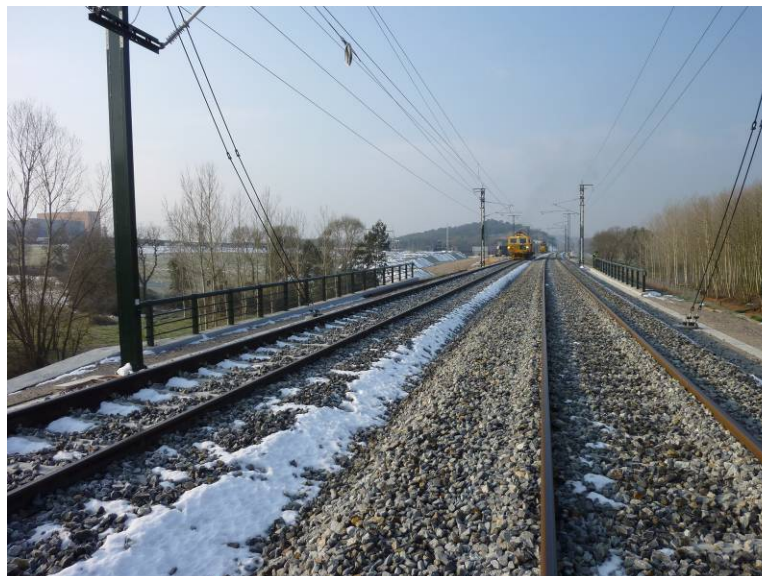
Fotografía N°6: Vista desde el estribo 2.
