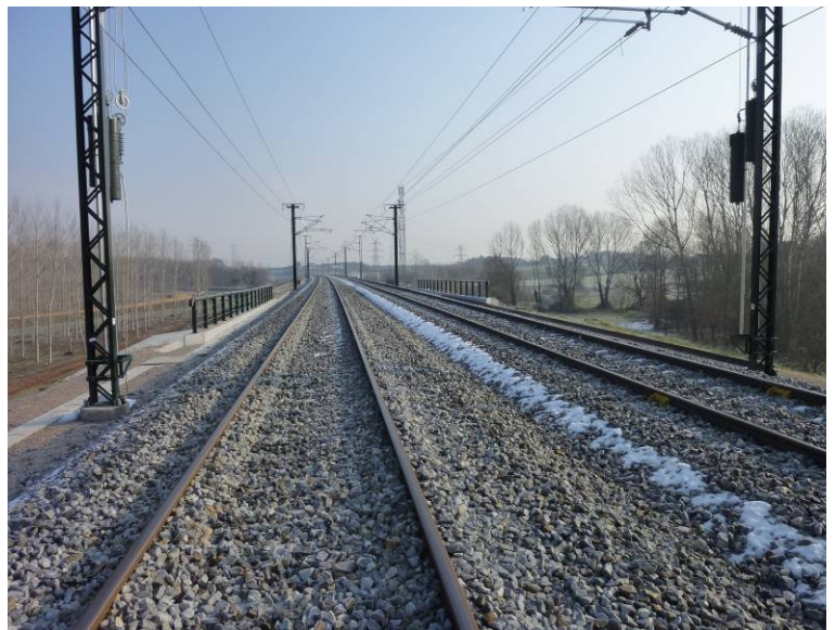
Fotografía N°5: Vista desde el estribo 1.
