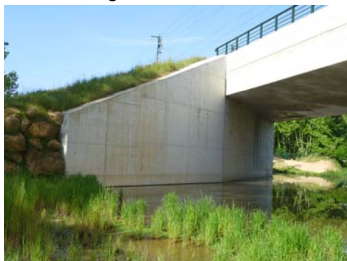
Fotografía nº 5. Estribo de entrada
