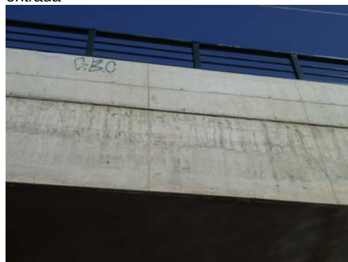
Fotografía nº 10. Nido de grava en la embocadura derecha.
