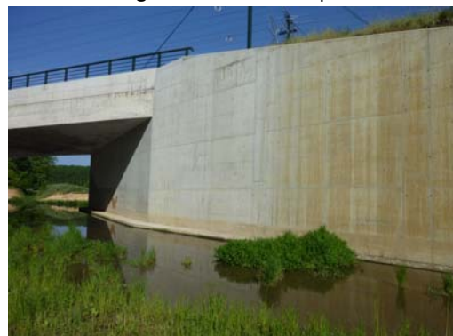
Fotografía nº 6. Estribo de salida
