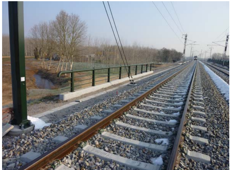
Fotografía N°10: Vista lateral izquierda de la plataforma.
