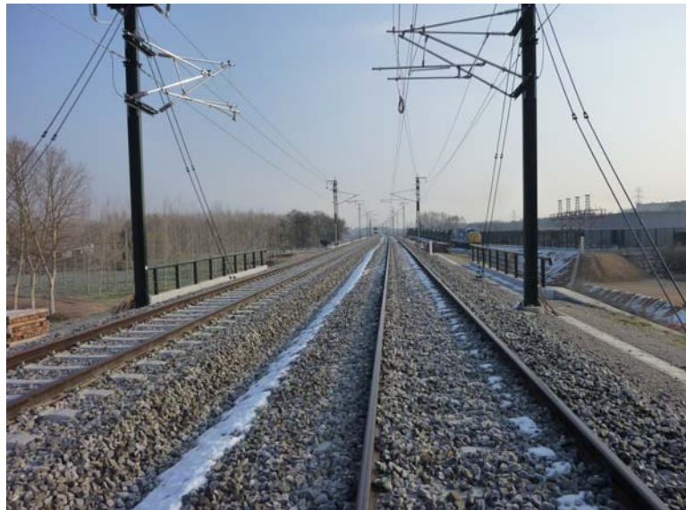
Fotografía N°7: Vista superior del Estribo de entrada.
