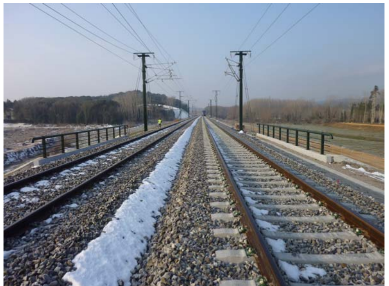
Fotografía N°8: Vista desde el Estribo 2 hacia el Estribo 1.
