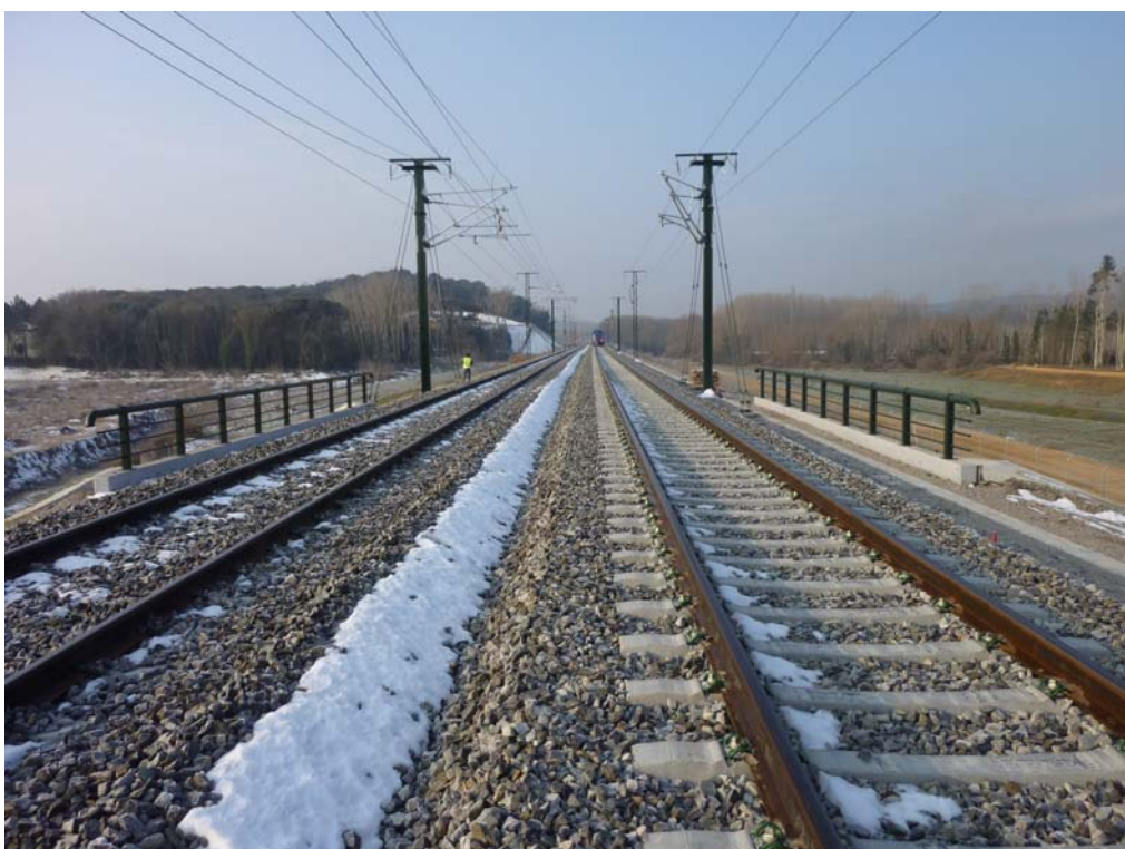
Fotografía 482: Vista desde el estribo E-2 hacia el estribo E-1
