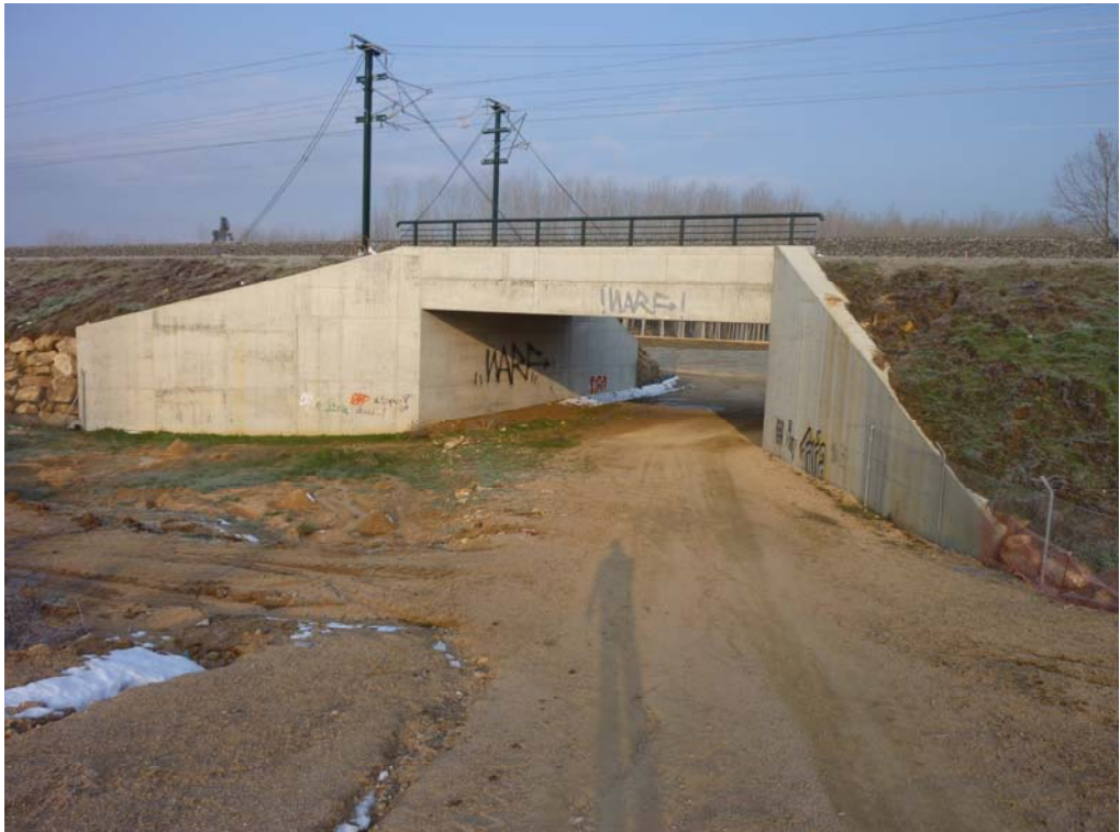
Fotografía 461: Vista del alzado derecho
