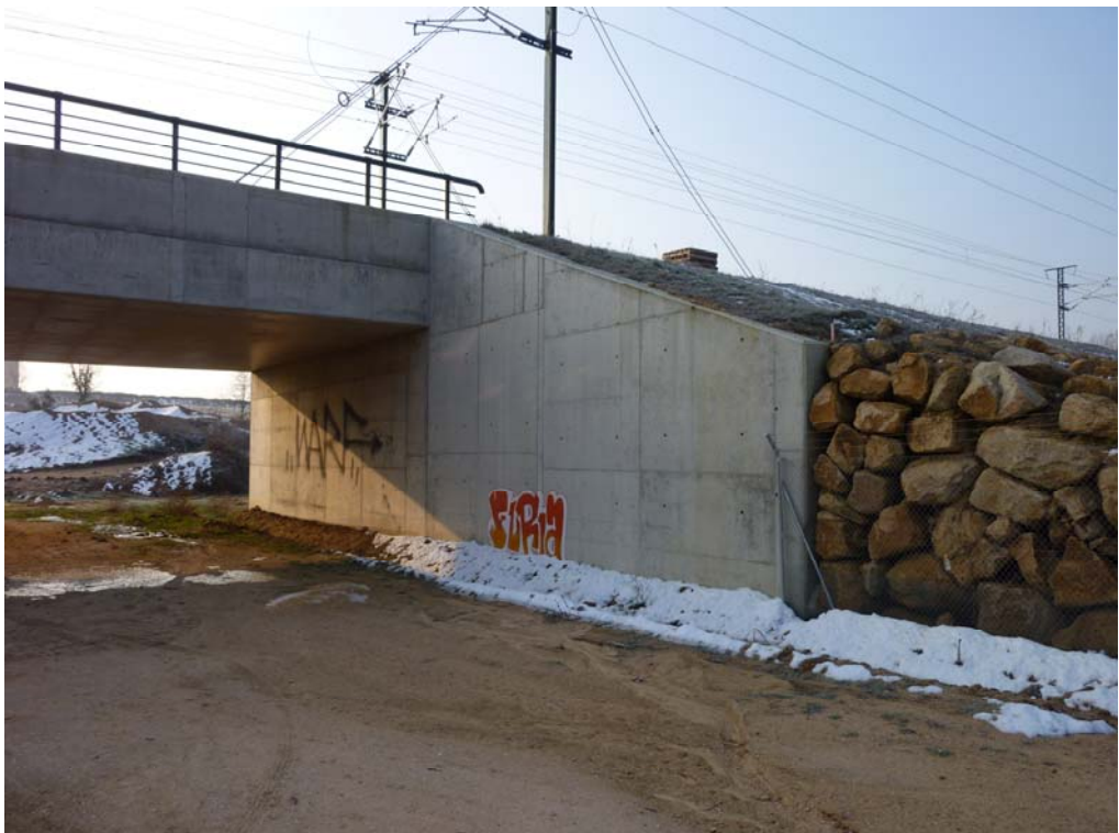
Fotografía 458: Vista del estribo de entrada
