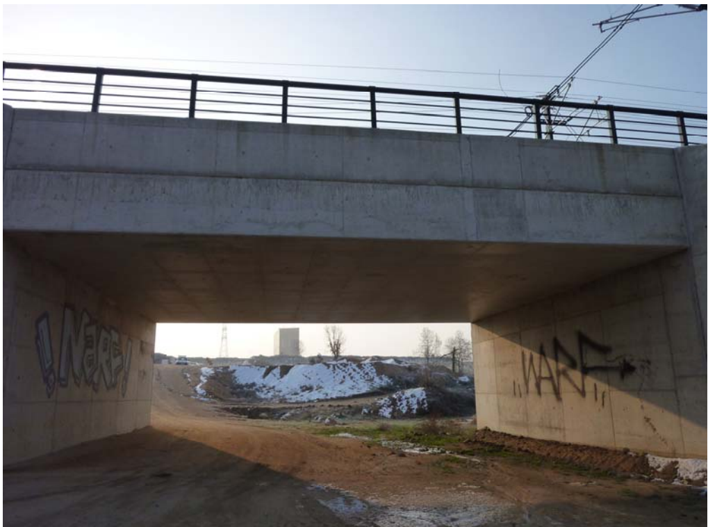
Fotografía 460: Vista inferior de la losa superior
