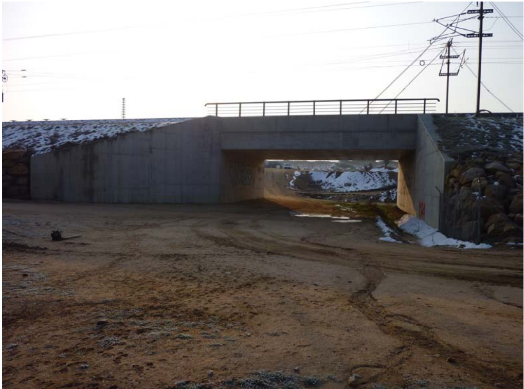
Fotografía 457: Vista del alzado derecho
