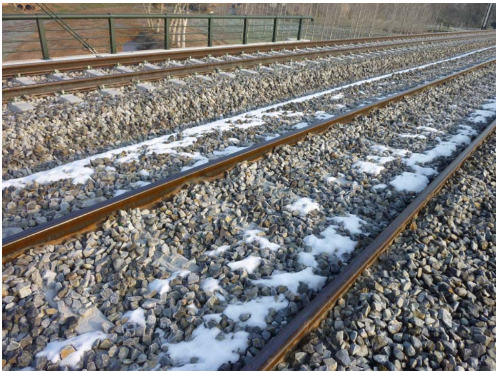
Fotografía 480: material de vía
