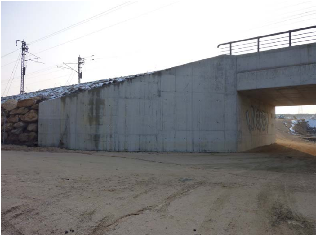
Fotografía 459: Vista del estribo de salida
