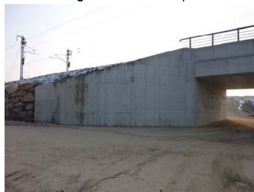
Fotografía nº 6. Estribo de salida
