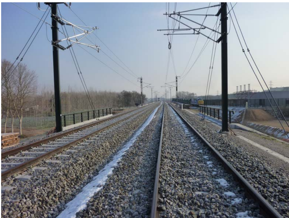
Fotografía 477: Vista superior del estribo de entrada
