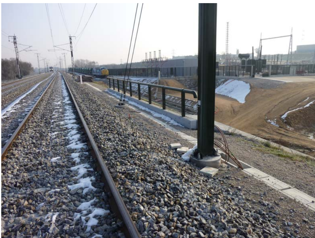
Fotografía 478: Vista lateral derecha de la plataforma
