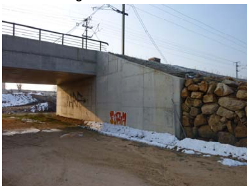
Fotografía nº 5. Estribo de entrada
