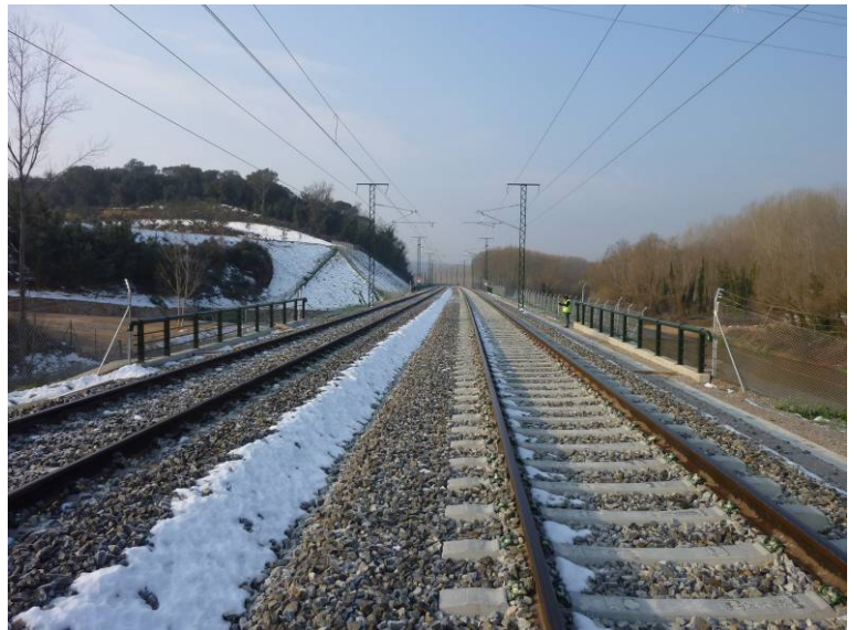
Fotografía N°7: Vista desde el Estribo 2.
