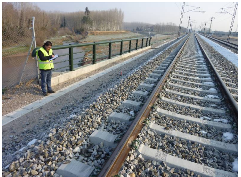
Fotografía N°9: Vista lado izquierdo.
