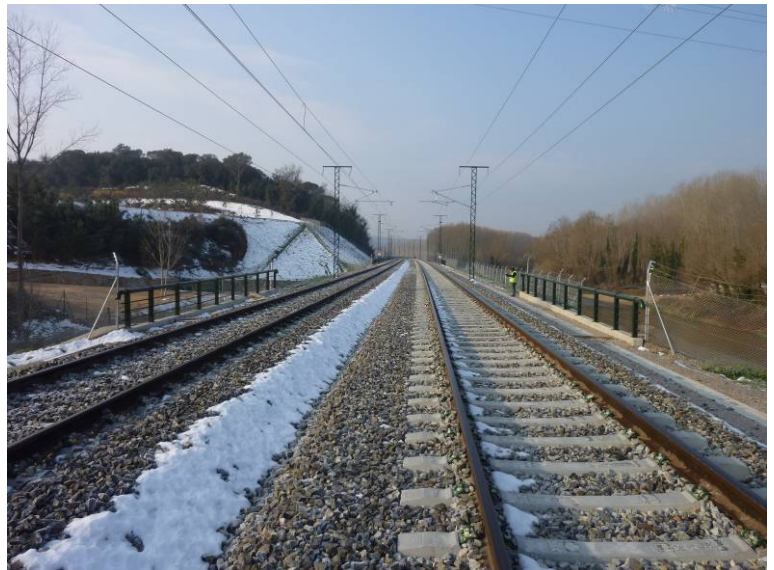
Fotografía N°7: Vista desde el Estribo 2.
