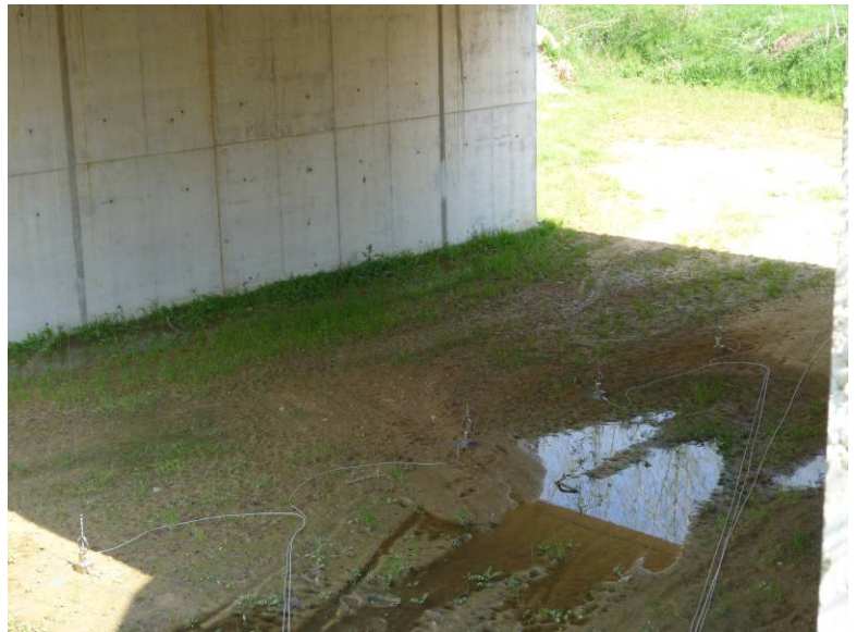
Fotografía N°1: Anillos en centro de vano.
