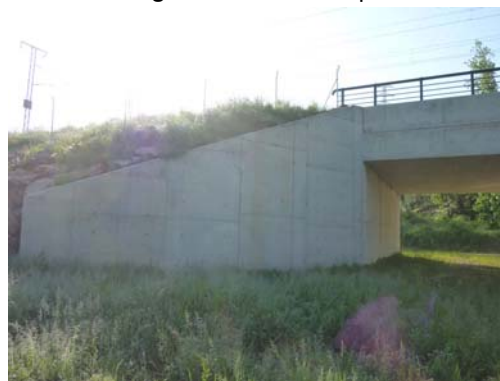
Fotografía nº 6. Estribo de salida
