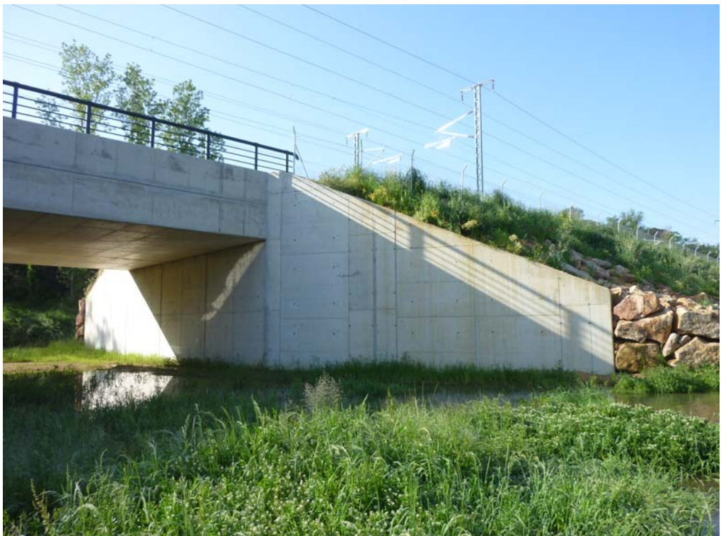
Estribo de entrada
