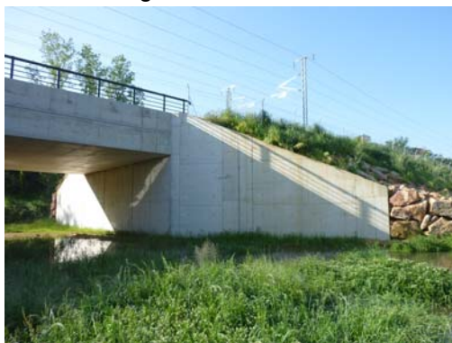
Fotografía nº 5. Estribo de entrada
