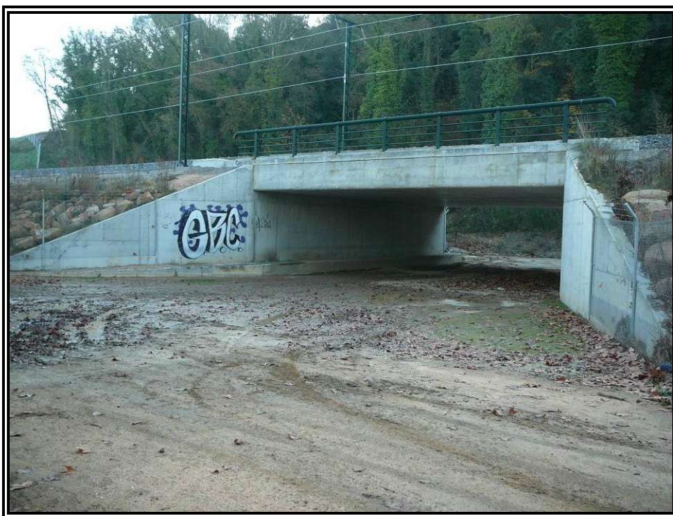
Nº 2.- Alzado izquierdo de la estructura.
