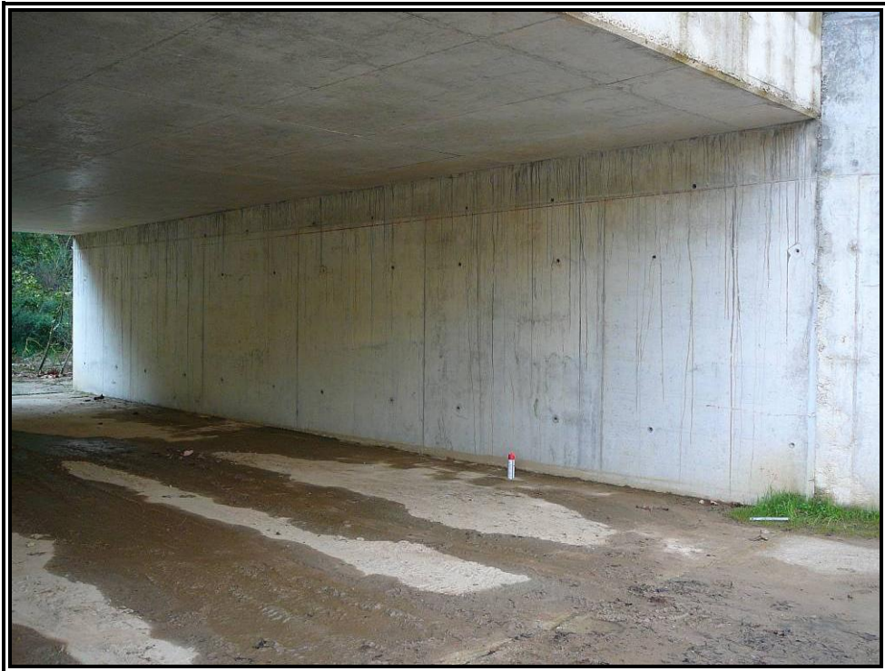
Nº 5.-Hastial derecho y vista inferior de la estructura.
