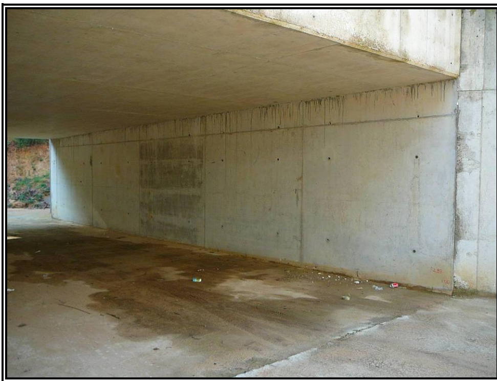
Nº 5.-Hastial derecho y vista inferior de la estructura.
