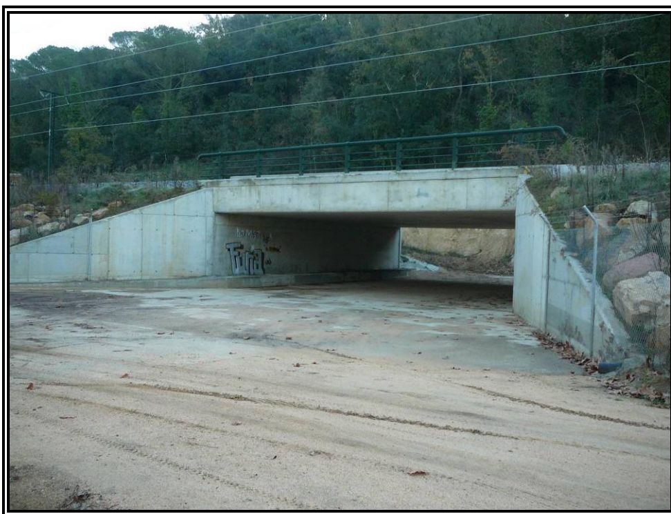
Nº 2.- Alzado izquierdo de la estructura.
