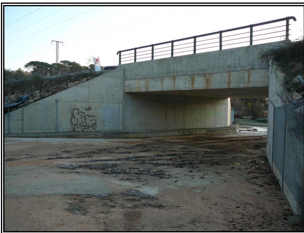
Nº 2.- Alzado izquierdo de la estructura.
