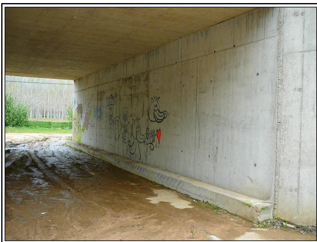
Estribo de entrada
