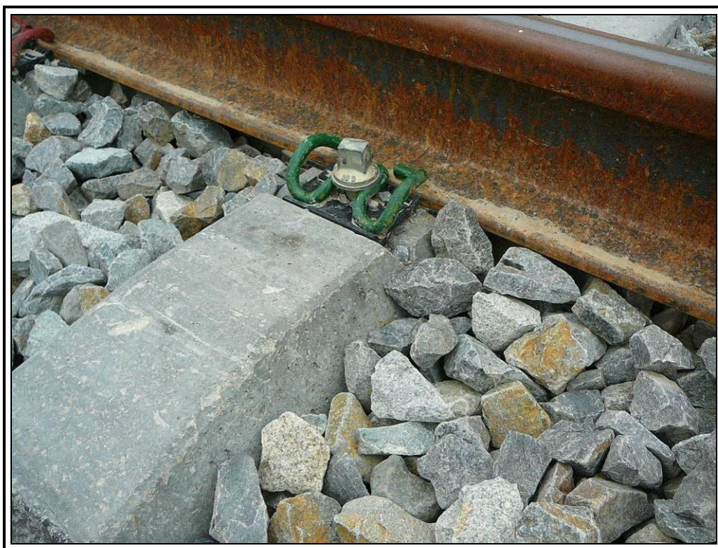
Material de vía
