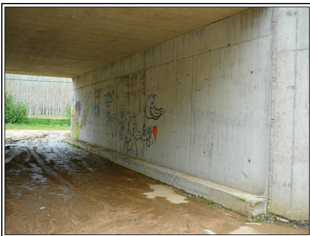
Estribo de entrada
