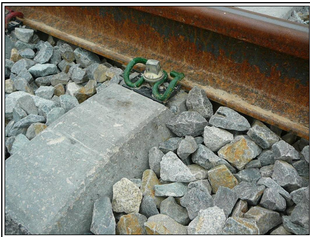
Material de vía
