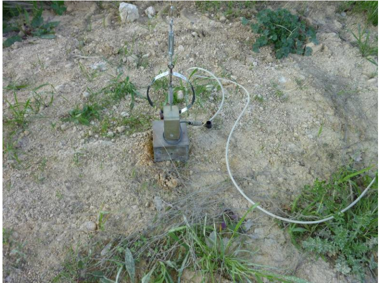
Fotografía N°4: Detalle de uno de los anillos dispuestos.
