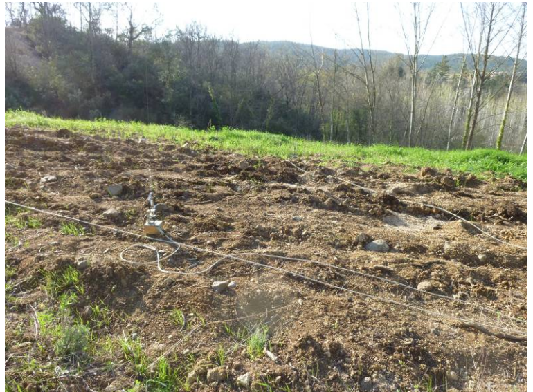
Fotografía N°10: Anillos dispuestos en centro de vano 2.
