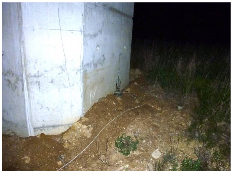
Fotografía N°27: Anillo dispuesto en pila 6.
