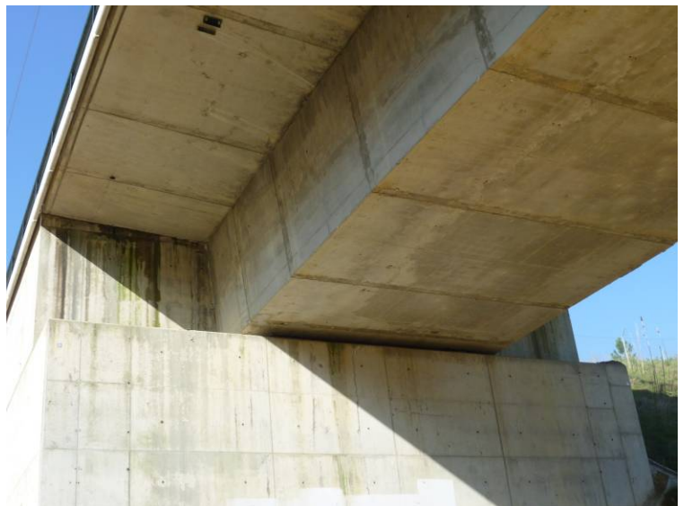
Fotografía N°12: Detalle del aparato de apoyo en estribo de entrada.
