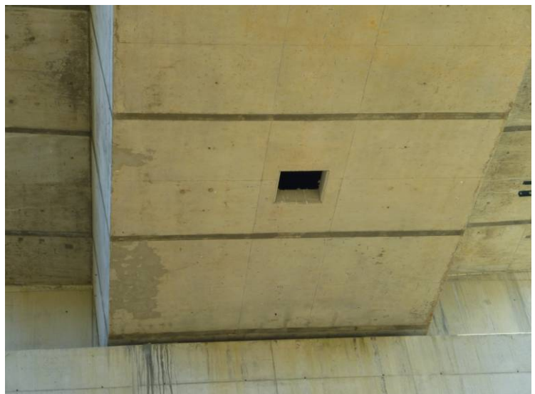
Fotografía N°33: Boca de hombre en vano 7 junto estribo 2.
