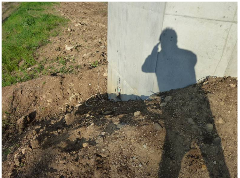
Fotografía N°5: Anillo dispuesto en pila 1.
