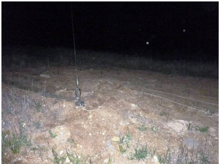
Fotografía N°29: Anillos dispuestos en centro de vano 6.
