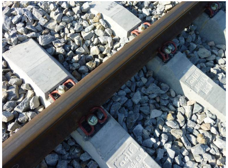
Fotografía N°7: Detalle de sujeción del carril.
