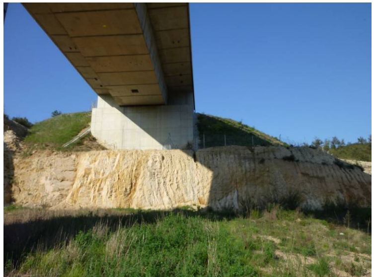
Fotografía N°11: Vista del estribo de salida.
