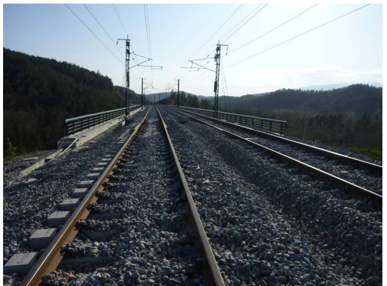
Fotografía N°2: Vista superior del tablero dirección Barcelona.
