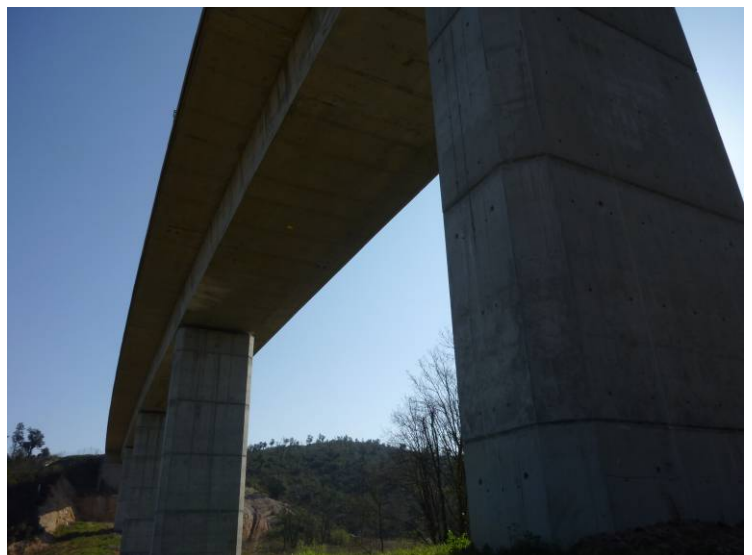
Fotografía N°3: Vista inferior del tablero.
