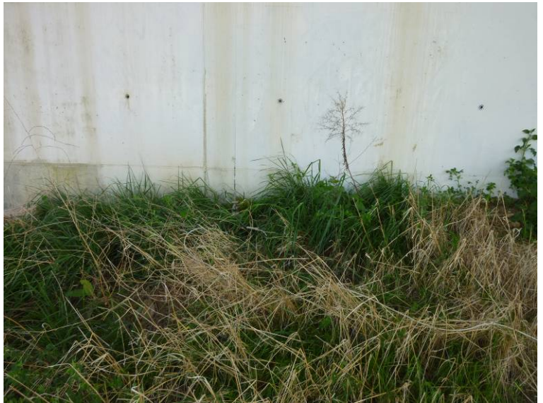
Fotografía N°13: Anillo dispuesto en estribo 1.
