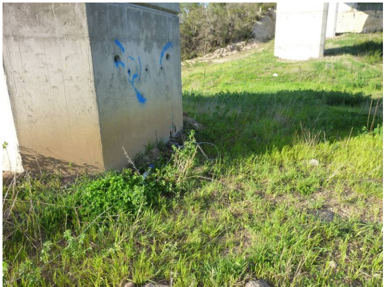
Fotografía N°8: Anillo dispuesto en pila 4.
