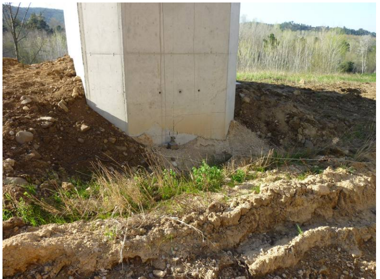
Fotografía N°6: Anillo dispuesto en pila 2.
