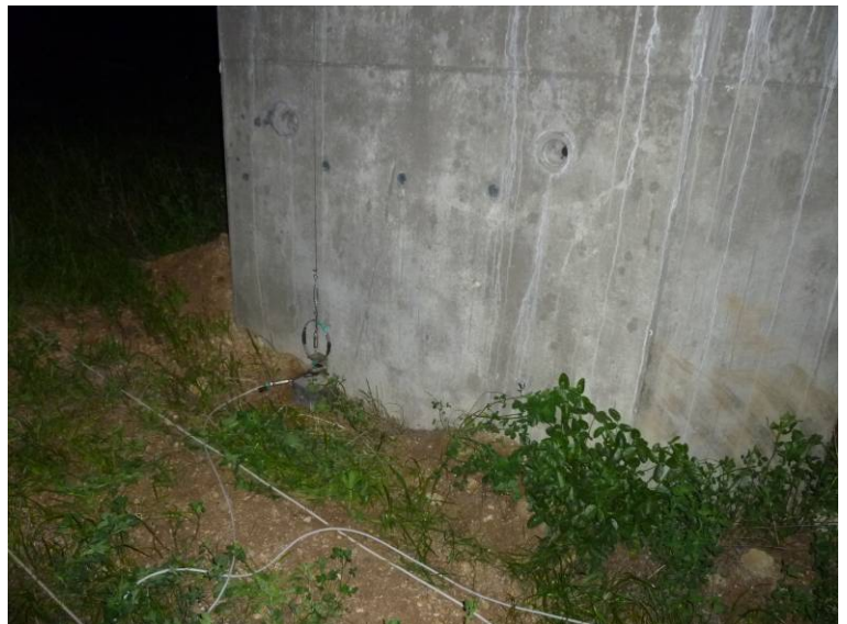
Fotografía N°26: Anillo dispuesto en pila 5.
