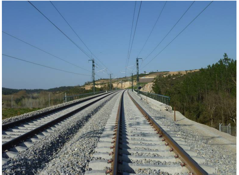
Fotografía N°1: Vista superior del tablero dirección Riudellots.
