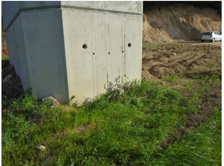
Fotografía N°7: Anillo dispuesto en pila 3.
