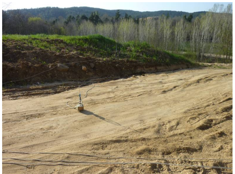
Fotografía N°11: Anillos dispuestos en centro de vano 3.
