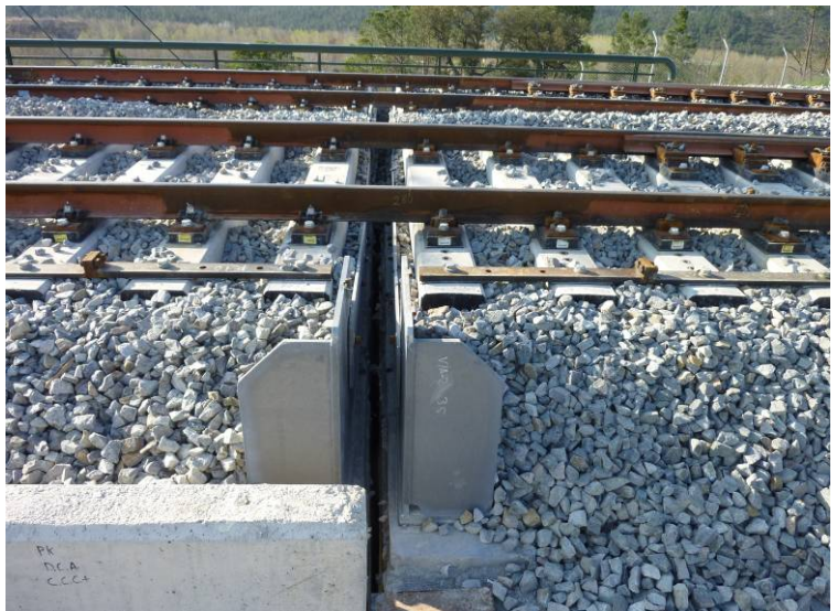
Fotografía N°14: Detalle de la junta existente en el estribo de salida.
