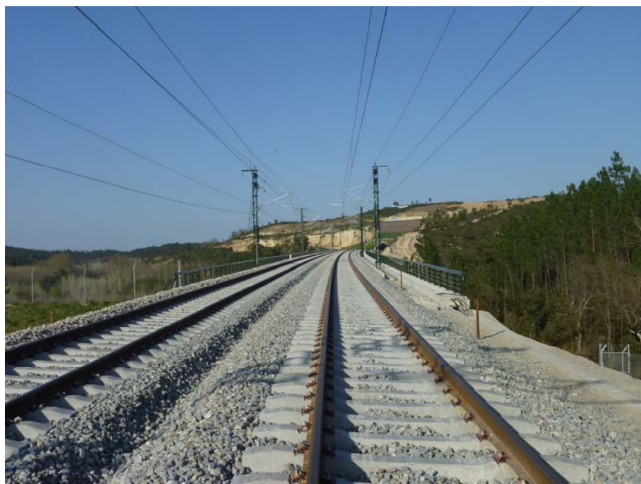
FOTOGRAFIA N° 1: Vista Superior del tablero dirección Riudellots
