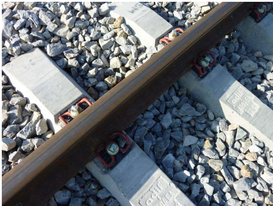
FOTOGRAFIA N° 7: Detalle de sujeción del carril
