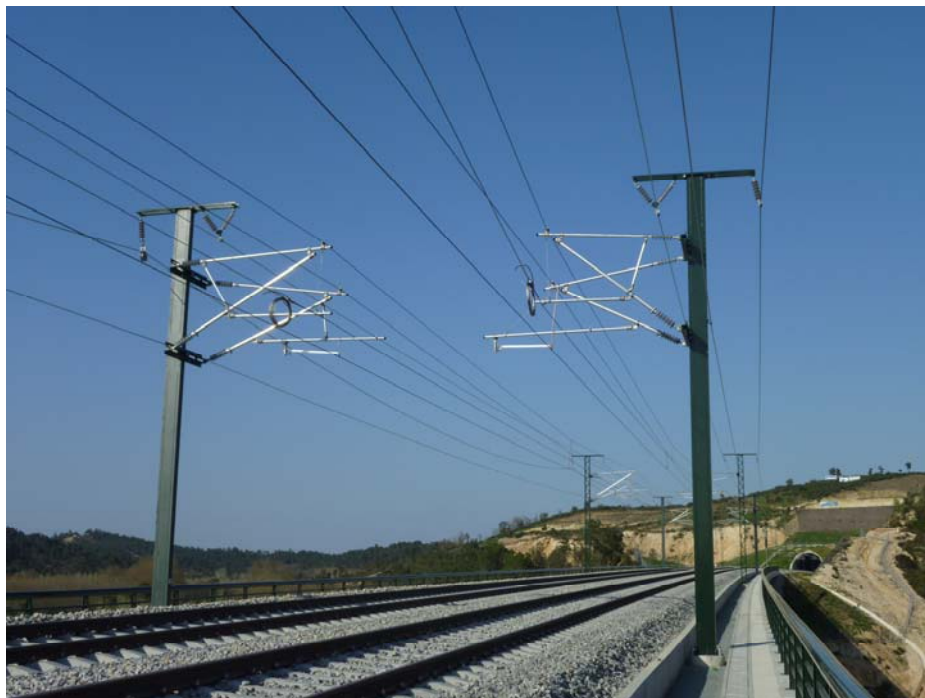
FOTOGRAFIA N° 15: Postes de catenária
