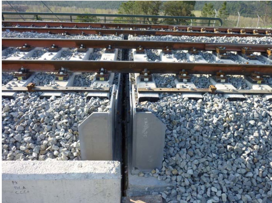
FOTOGRAFIA N° 14: Detalle de la junta existente en el estribo de salida
