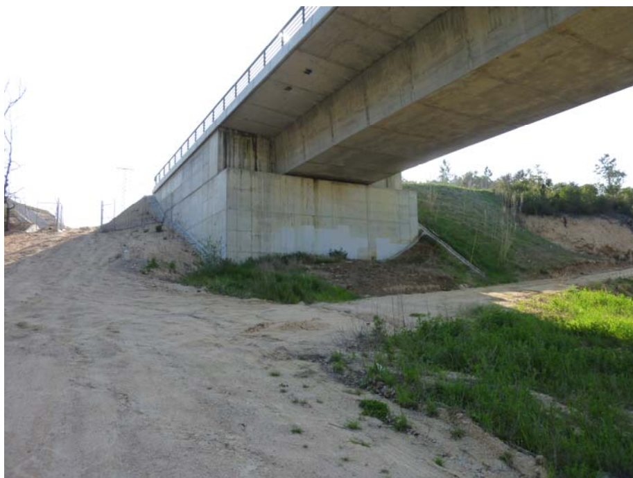
FOTOGRAFIA N° 10: Vista del estribo de entrada
