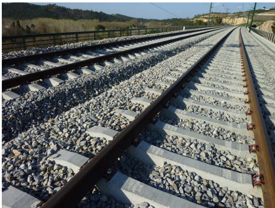
FOTOGRAFIA N° 6: Vista del material de vía
