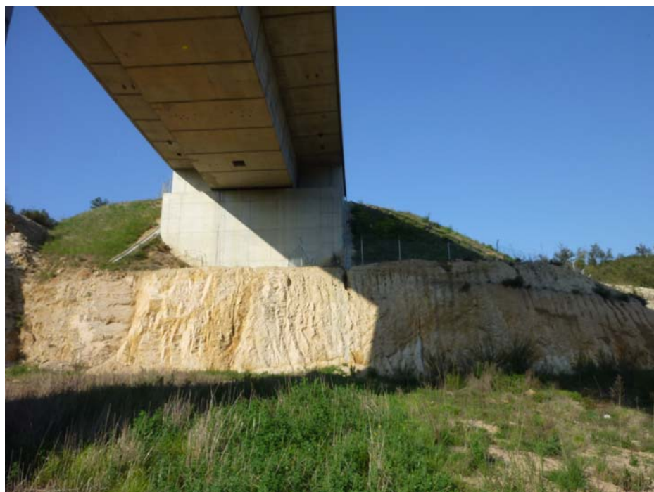
FOTOGRAFIA N° 11: Vista del estribo de salida
