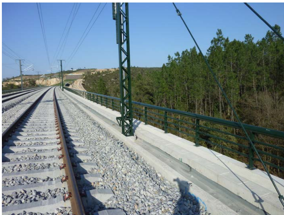
FOTOGRAFIA N° 8: Vista del lado derecho de la plataforma
