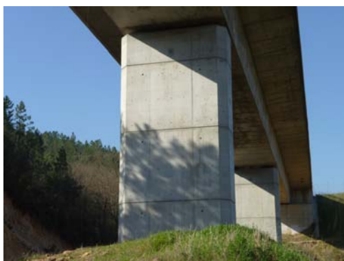
Fotografía nº 1. Detalle de una pila
