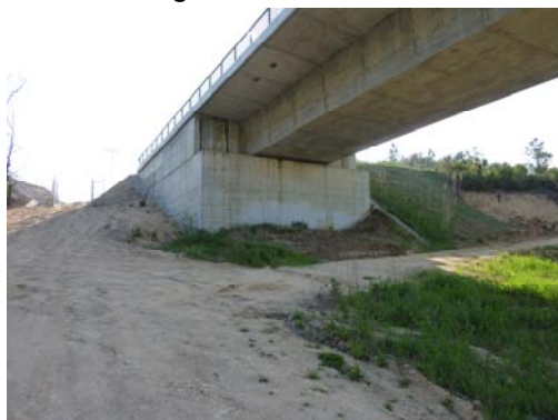
Fotografía nº 5. Estribo de entrada
