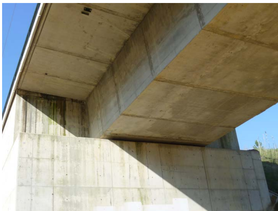
FOTOGRAFIA N° 12: Detalle de aparato de apoyo en estribo de entrada
