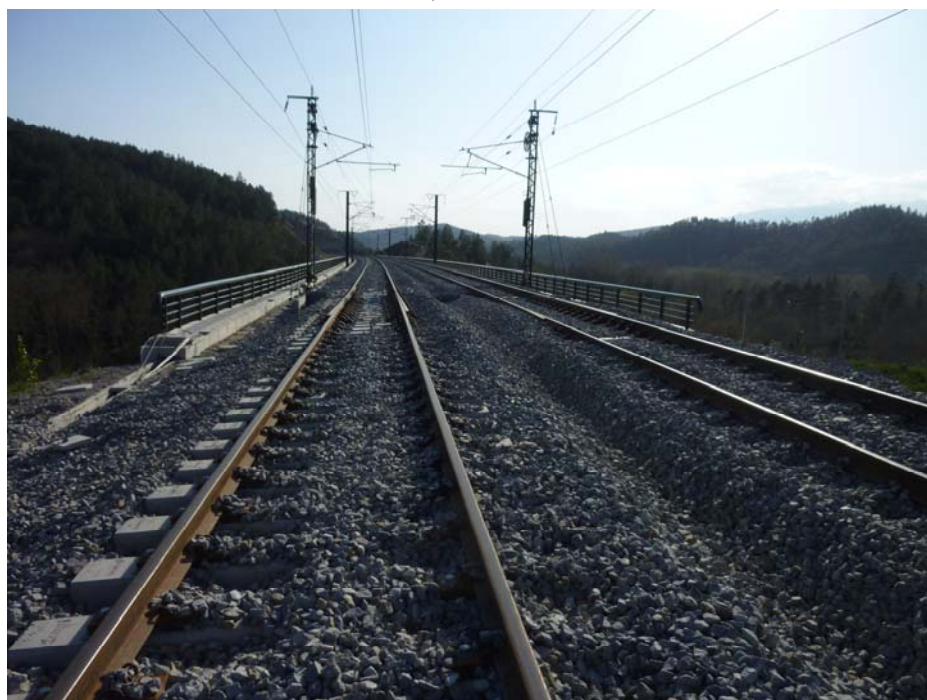
FOTOGRAFIA N° 2: Vista superior del tablero dirección Barcelona
