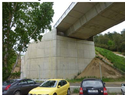
Fotografía nº 6. Estribo de salida
