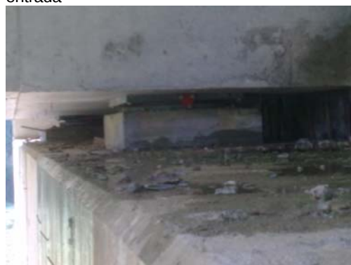
Fotografía nº 12. Detalle de una chapa por retirar en un apoyo.
