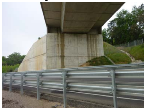
Fotografía nº 5. Estribo de entrada
