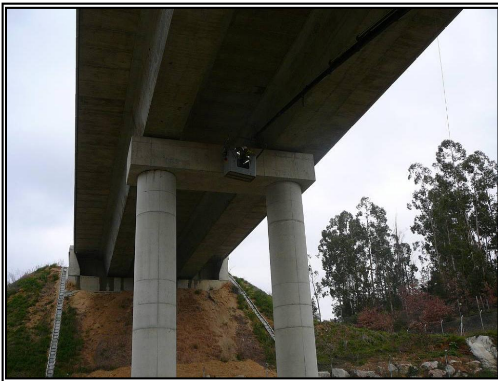
Nº 7.- Colocación de instrumentación en apoyo.
