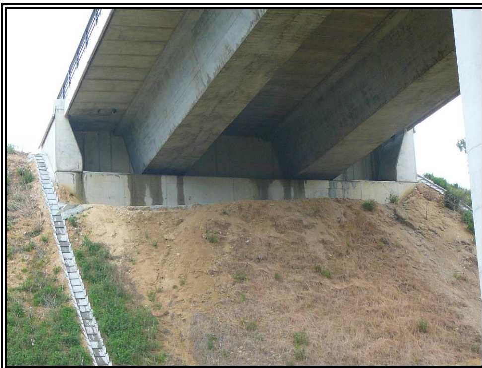
Nº 5.- Detalle de estribo.
