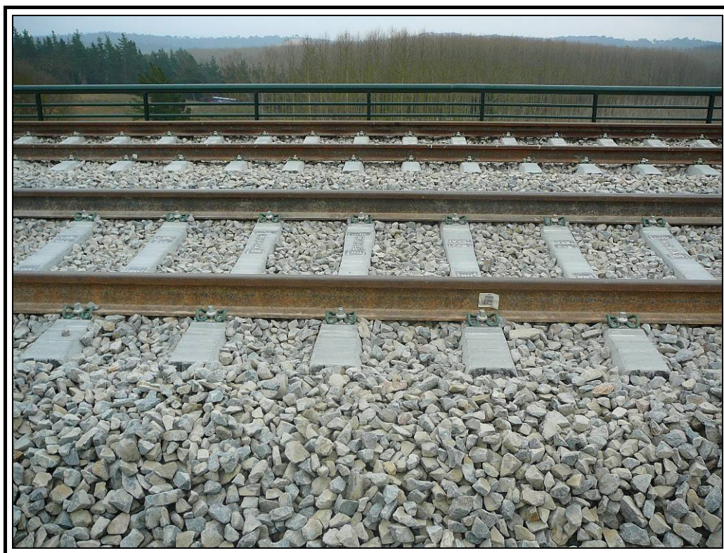
Material de vía
