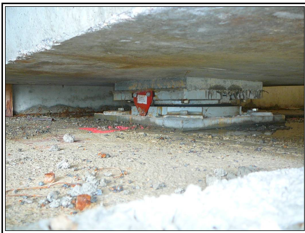
Apoyo derecho de estribo uno
