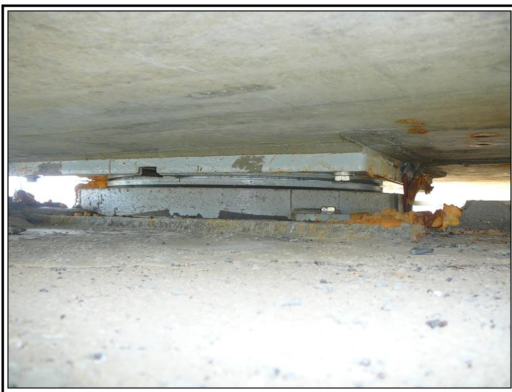
Apoyo derecho pila uno
