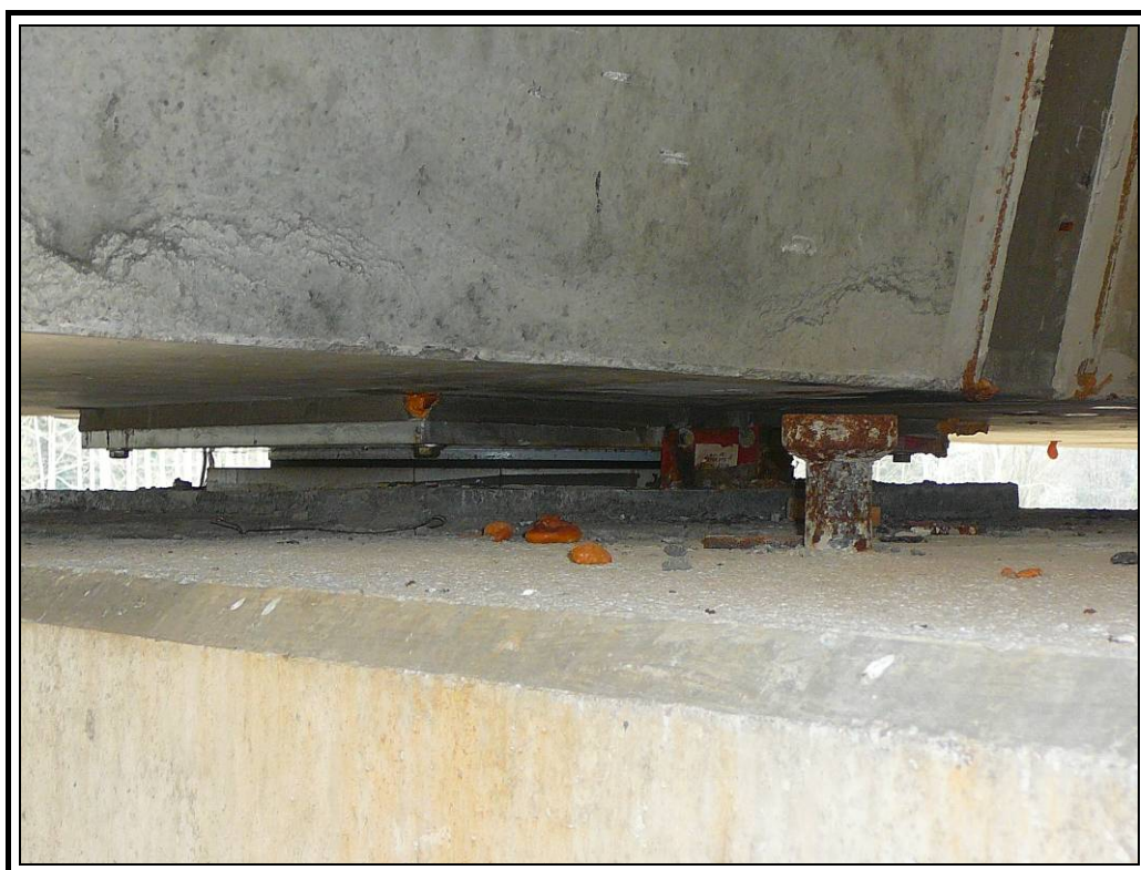
Apoyo derecho pila dos
