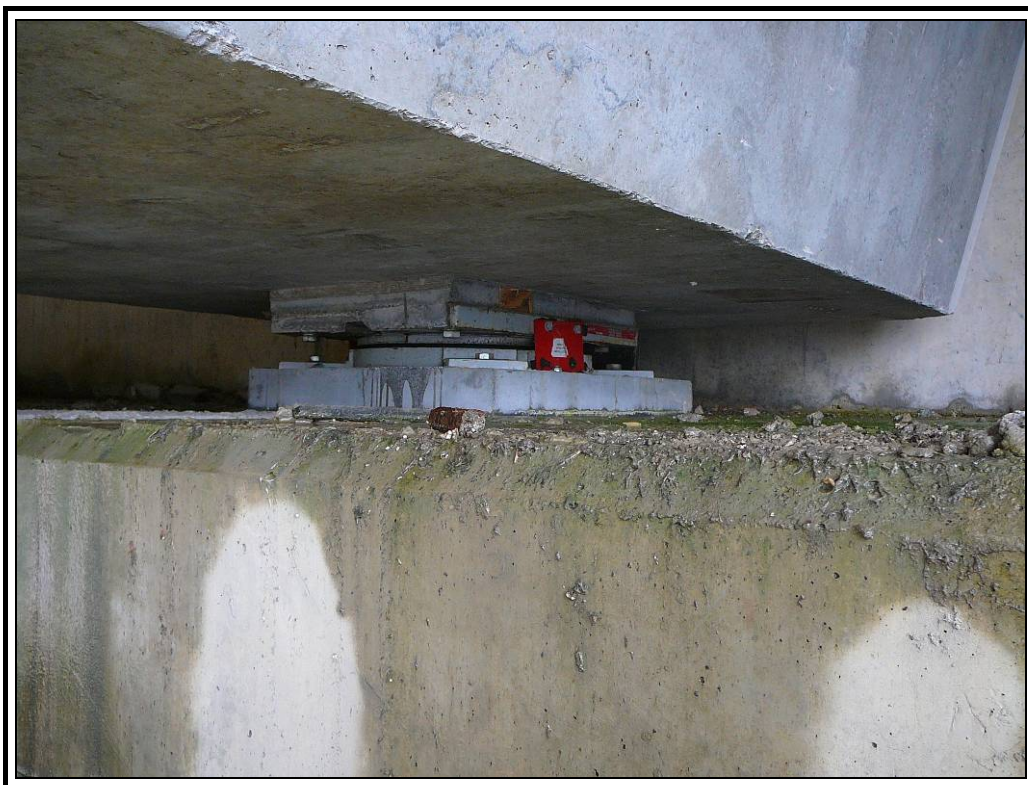
Apoyo derecho estribo dos
