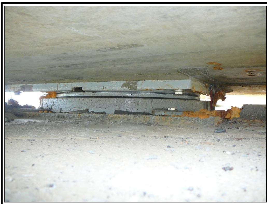
Apoyo derecho pila uno
