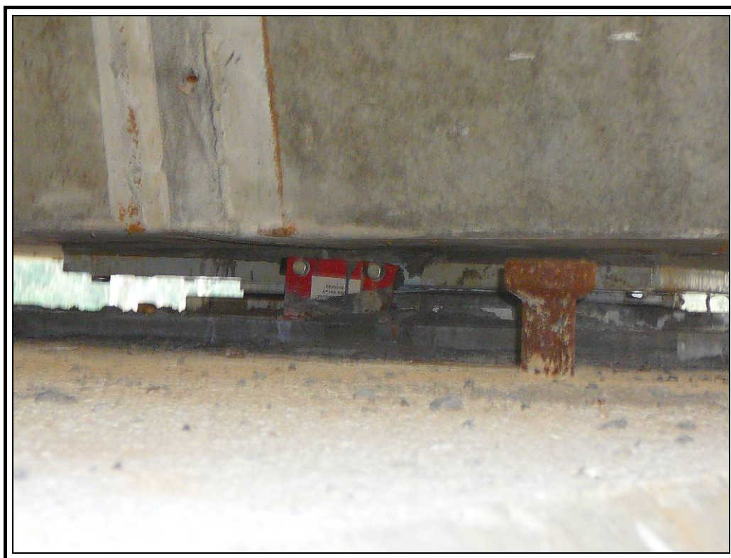
Apoyo izquierdo pila dos
