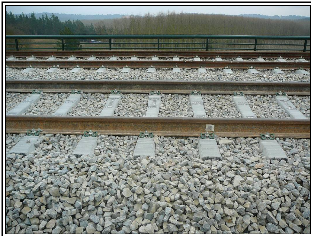
Material de vía
