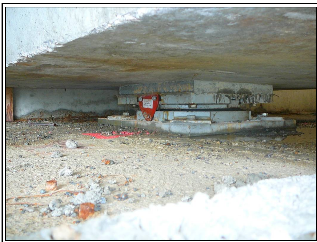
Apoyo derecho de estribo uno
