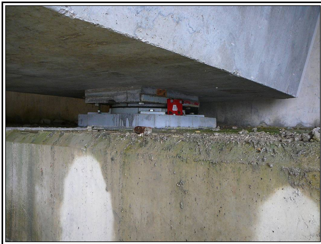
Apoyo derecho estribo dos
