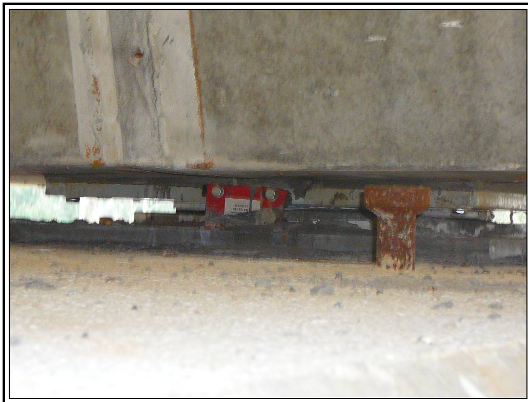
Apoyo izquierdo pila dos
