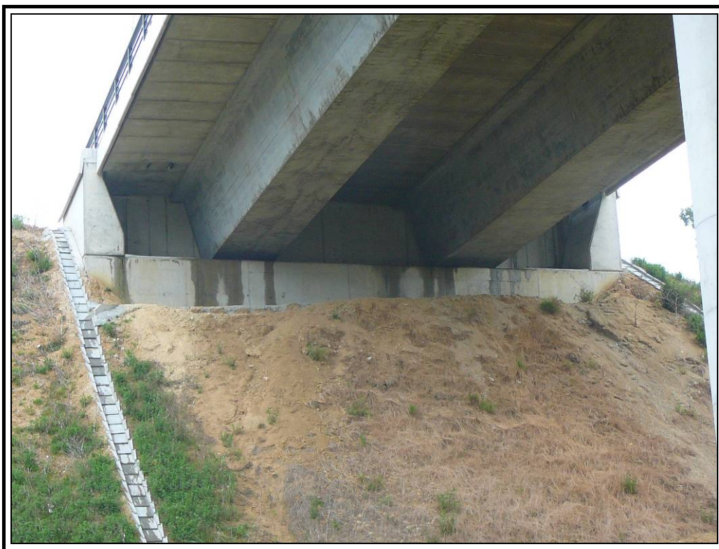
Estribo de salida
