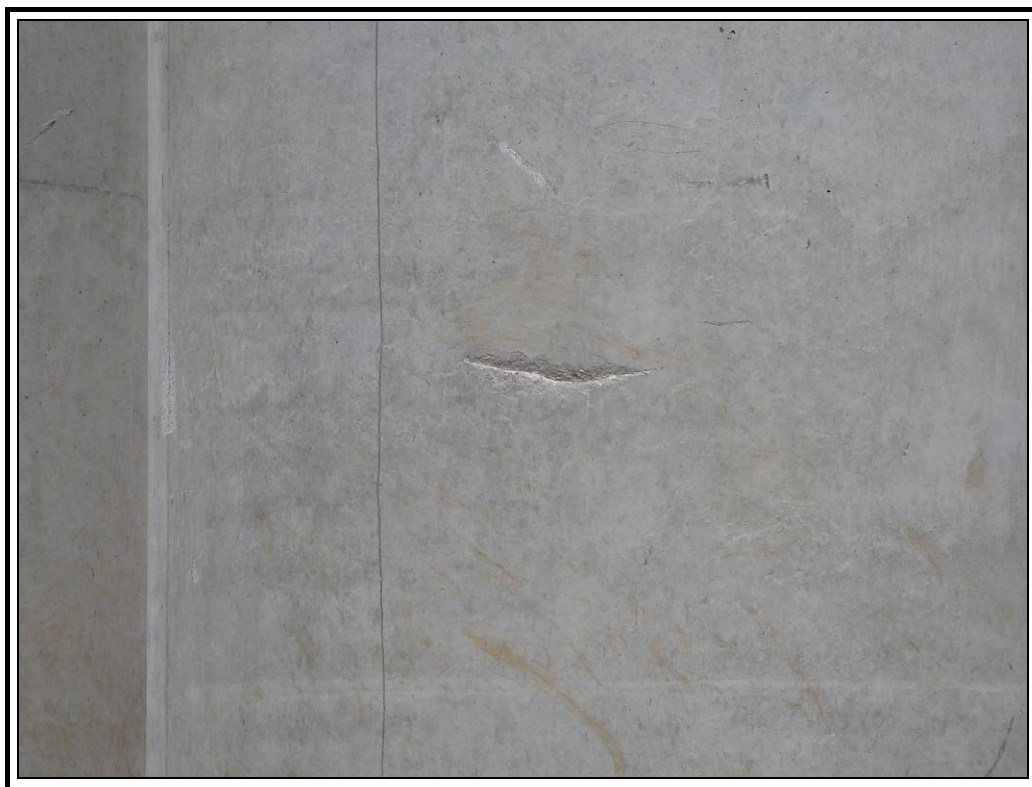
Desconchón por golpe en fuste izquierdo de pila uno
