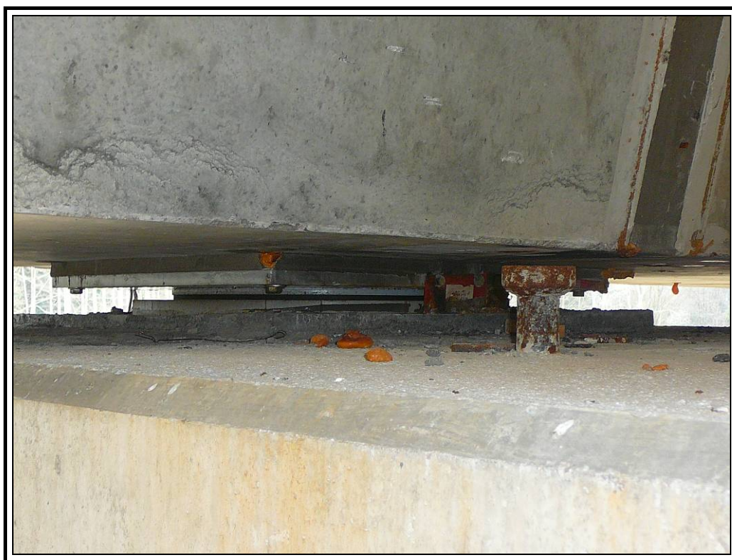
Apoyo derecho pila dos
