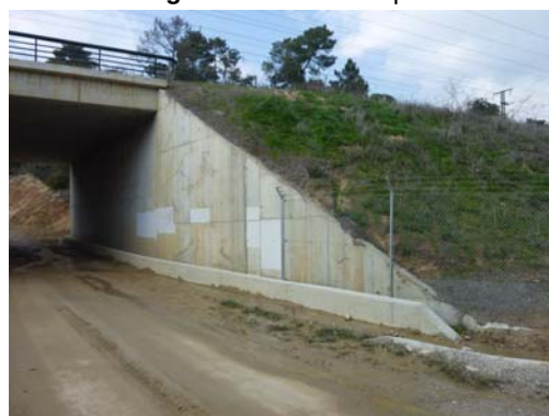
Fotografía nº 6. Estribo de salida
