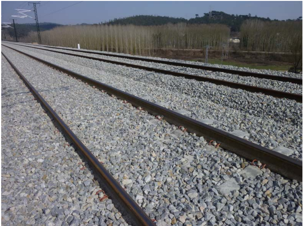
Fotografía 507: Material de vía
