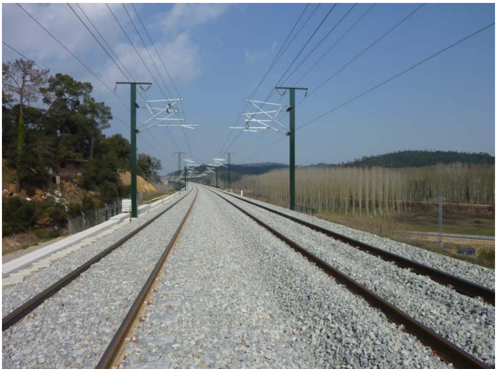
Fotografía 504: vista superior desde el estribo de entrada
