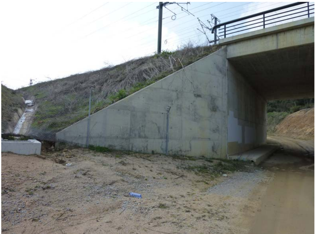
Fotografía 500: Estribo de entrada
