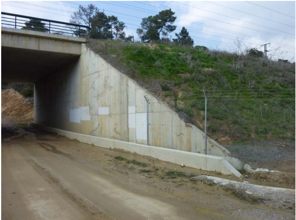
Fotografía 501: Estribo de salida
