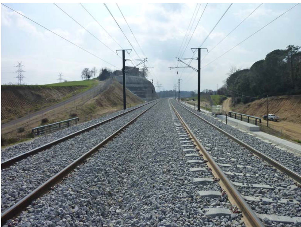
Fotografía 509: vista superior desde el estribo de salida hacia el estribo de entrada
