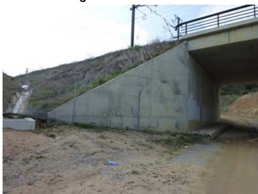
Fotografía nº 5. Estribo de entrada
