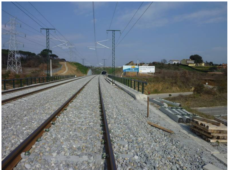
Fotografía N°18: Vista del lado derecho de la plataforma.
