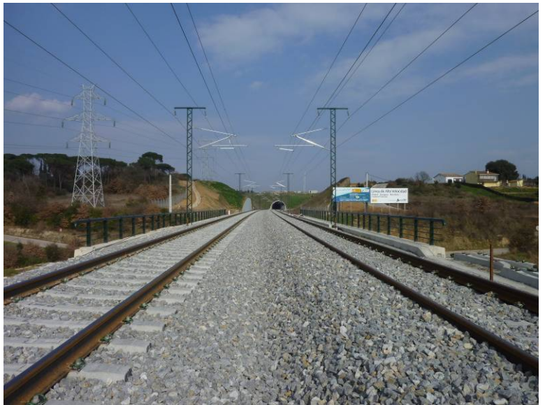
Fotografía N°17: Vista desde el estribo de entrada.
