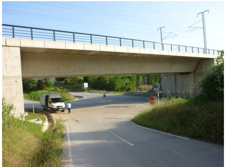
Fotografía N°1: Vista general de la estructura.
