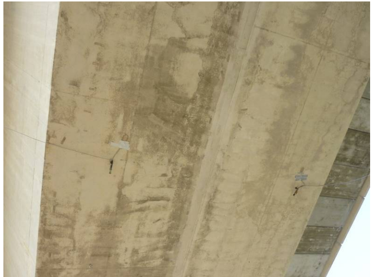
Fotografía N°10: Bandas dispuestas en centro de vano.
