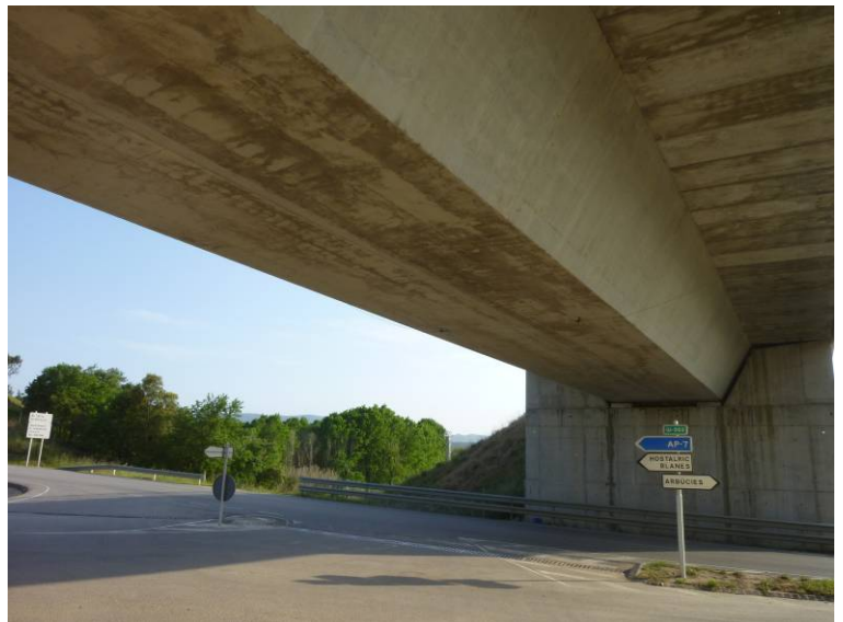
Fotografía N°14: Vista inferior de la estructura.
