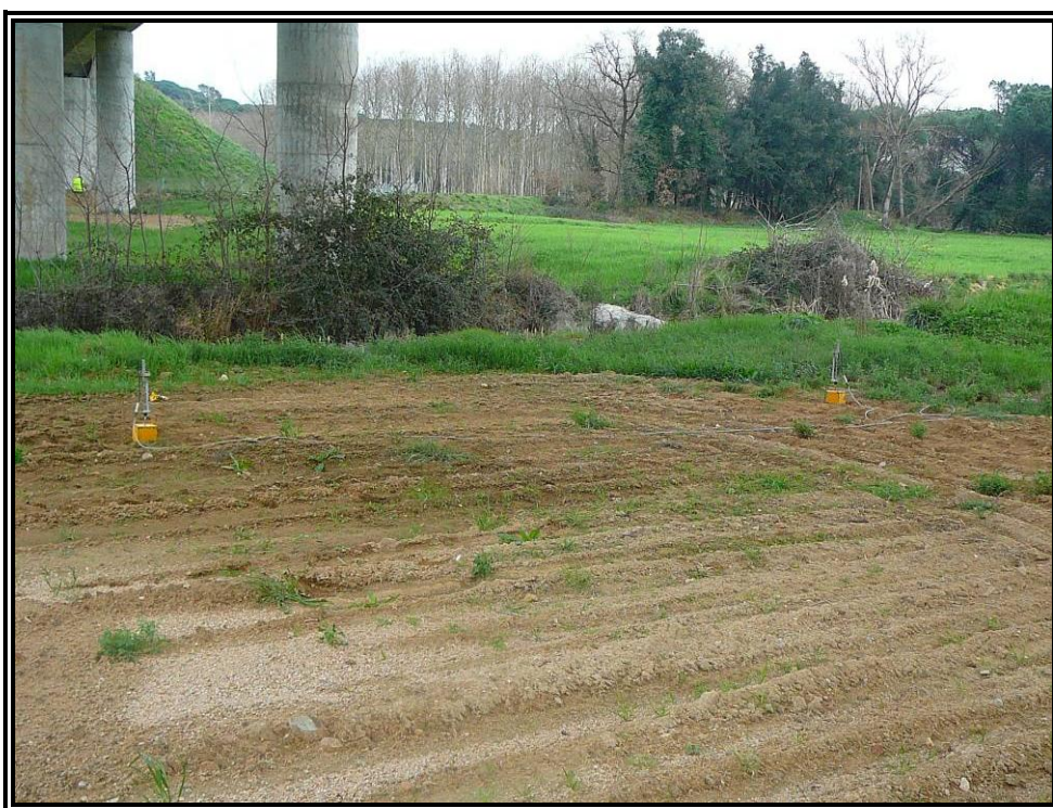
Nº 6.- LVDT's colocados en centro de vano.
