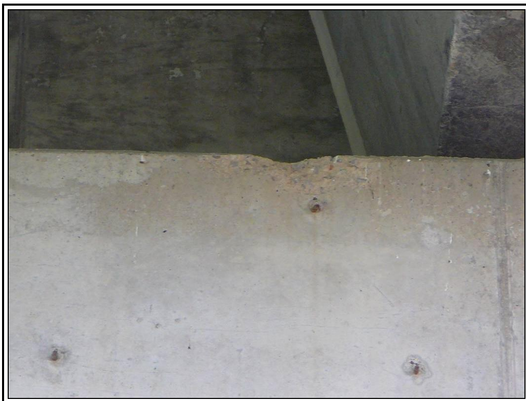
Desconchón en arista superior de muro frontal estribo uno
