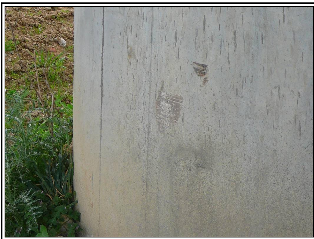
Desconchón por roce en fuste izquierdo de pila uno
