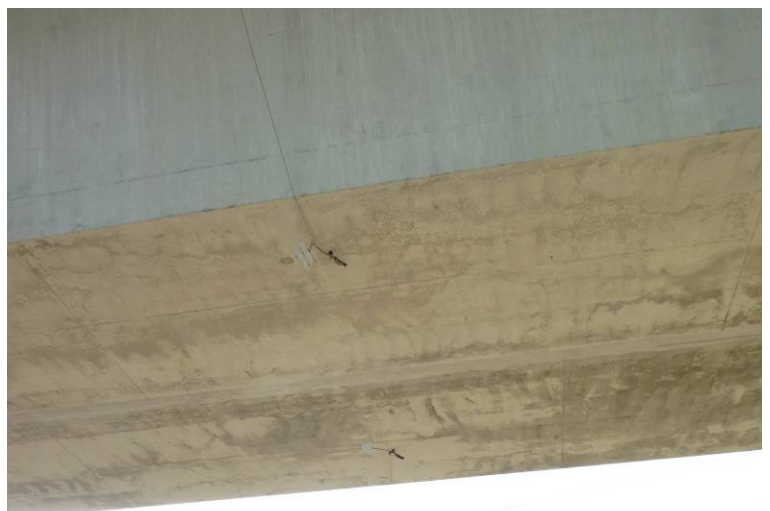
Fotografía N°9: Bandas dispuestas en centro de vano.
