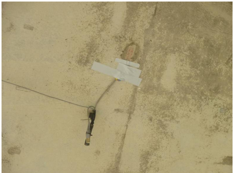
Fotografía N°12: Detalle de una de las bandas dispuestas en centro de vano.
