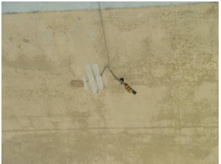
Fotografía N°11: Detalle de una de las bandas dispuestas en centro de vano.
