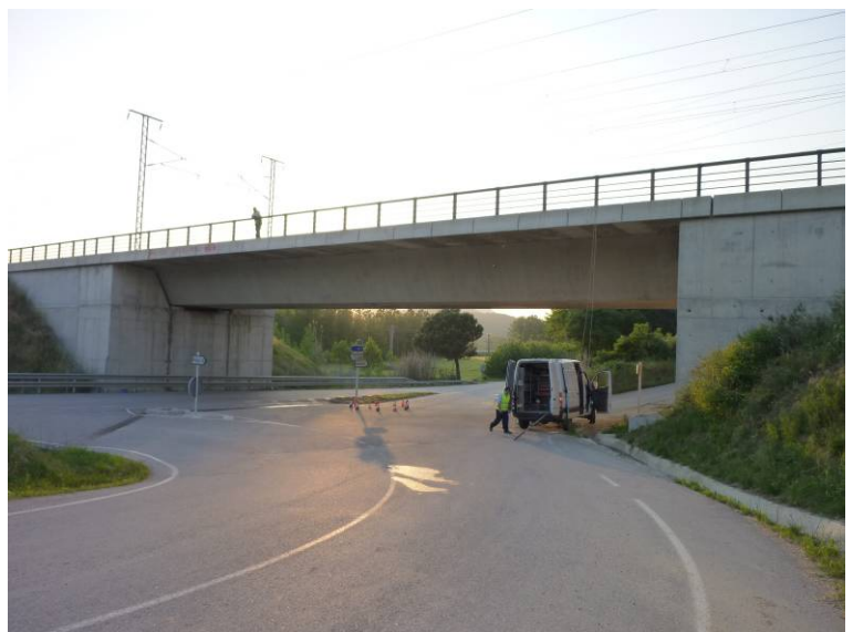
Fotografía N°2: Vista general de la estructura.
