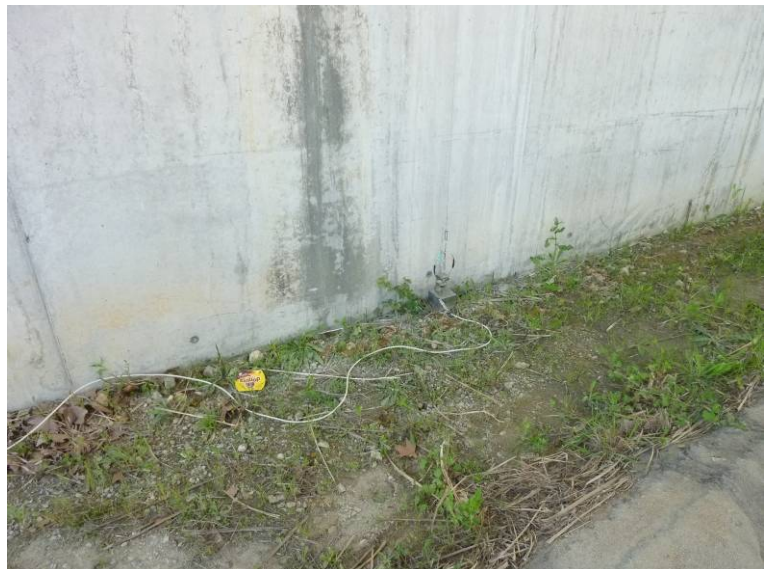
Fotografía N°5: Anillo dispuesto en el estribo 1.
