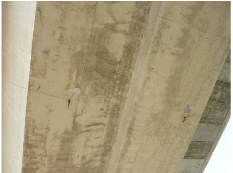
Fotografía N°10: Bandas dispuestas en centro de vano.
