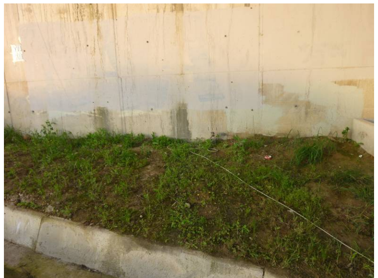
Fotografía N°6: Anillo dispuesto en el estribo 2.
