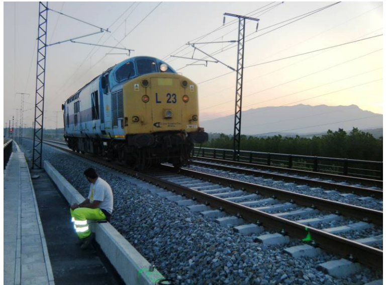
Fotografía N°19: Detalle de la locomotora durante el ensayo dinámico rápido.
