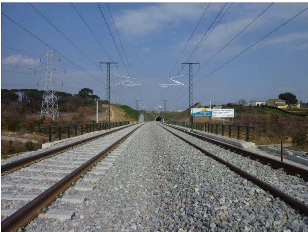
Vista desde el estribo de entrada
