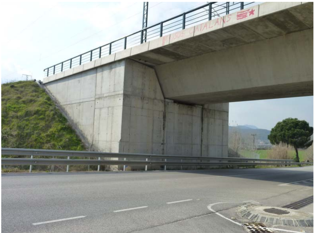
Vista del estribo de entrada
