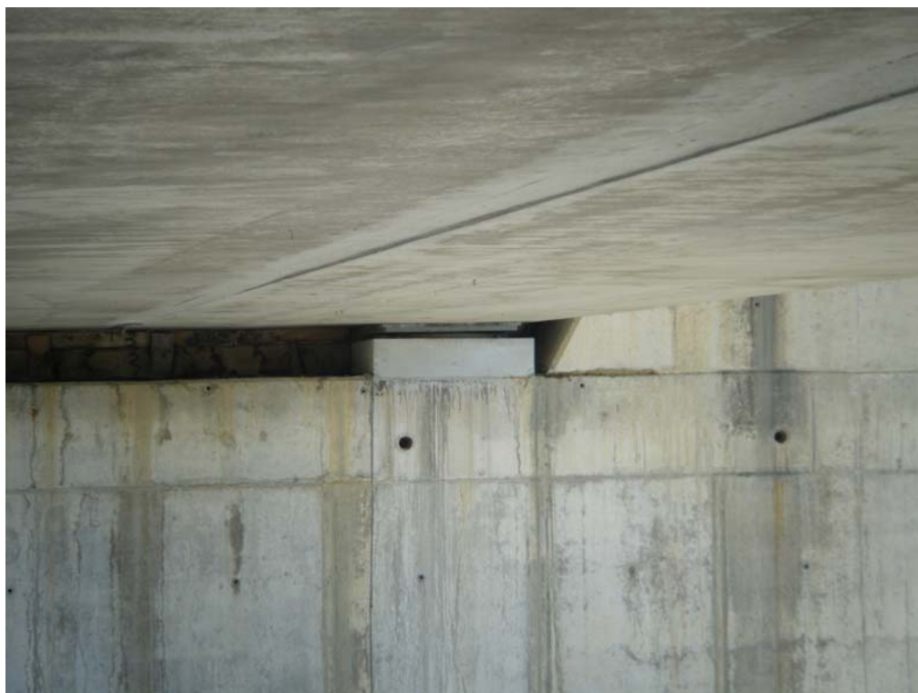
Apoyo tipo POT (V)
