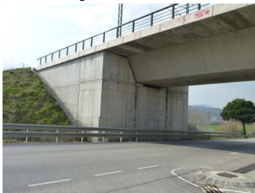
Fotografía nº 5. Estribo de entrada
