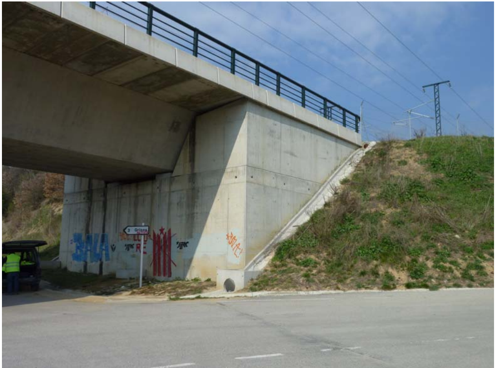
Vista del estribo de salida
