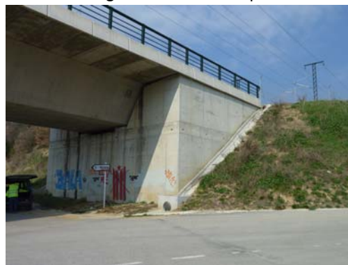
Fotografía nº 6. Estribo de salida
