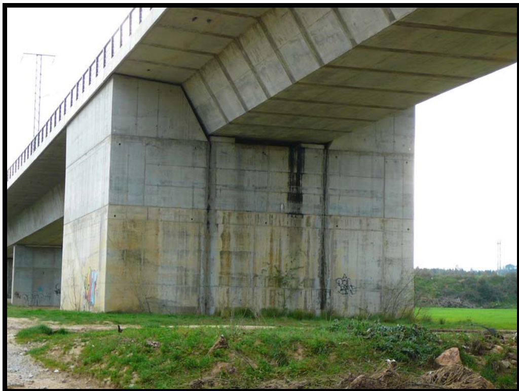
4. Estribo de entrada.
