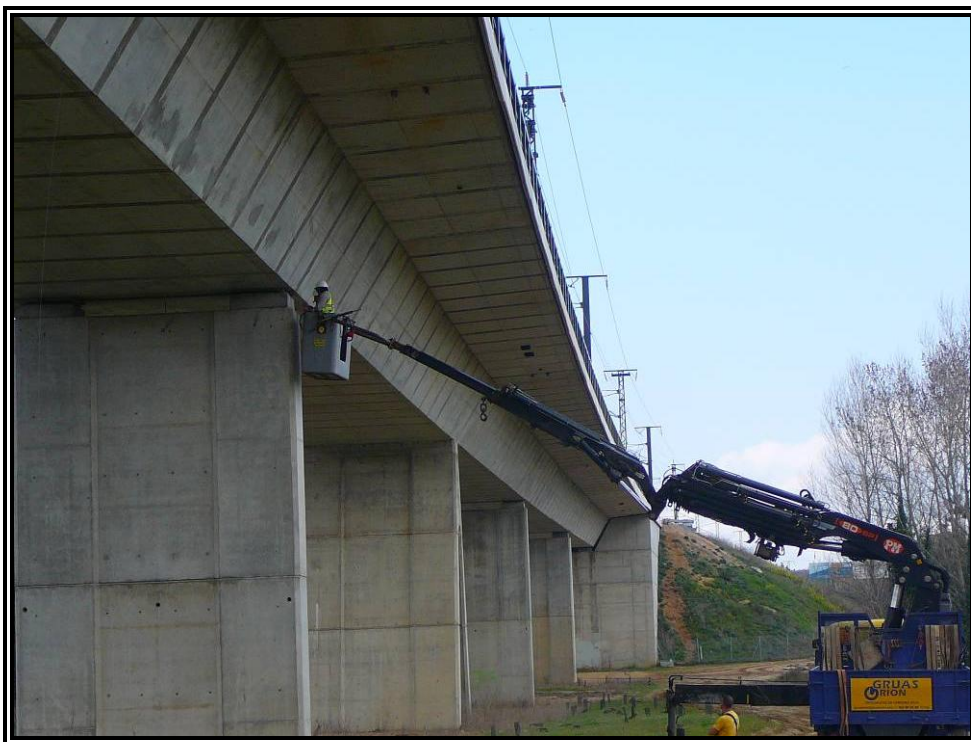
Nº 8.- Colocación de instrumentación en pila.
