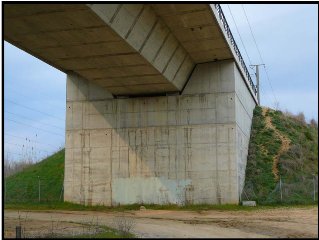
5. Estribo de salida.
