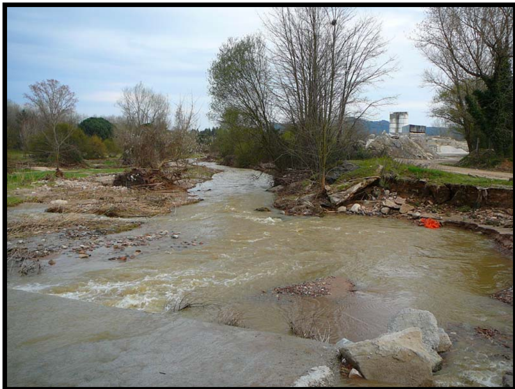
12. Cauce aguas abajo.
