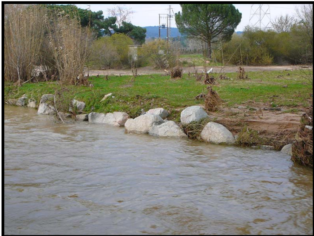
14. Escollera de protección en la margen izquierda, bajo la estructura.
