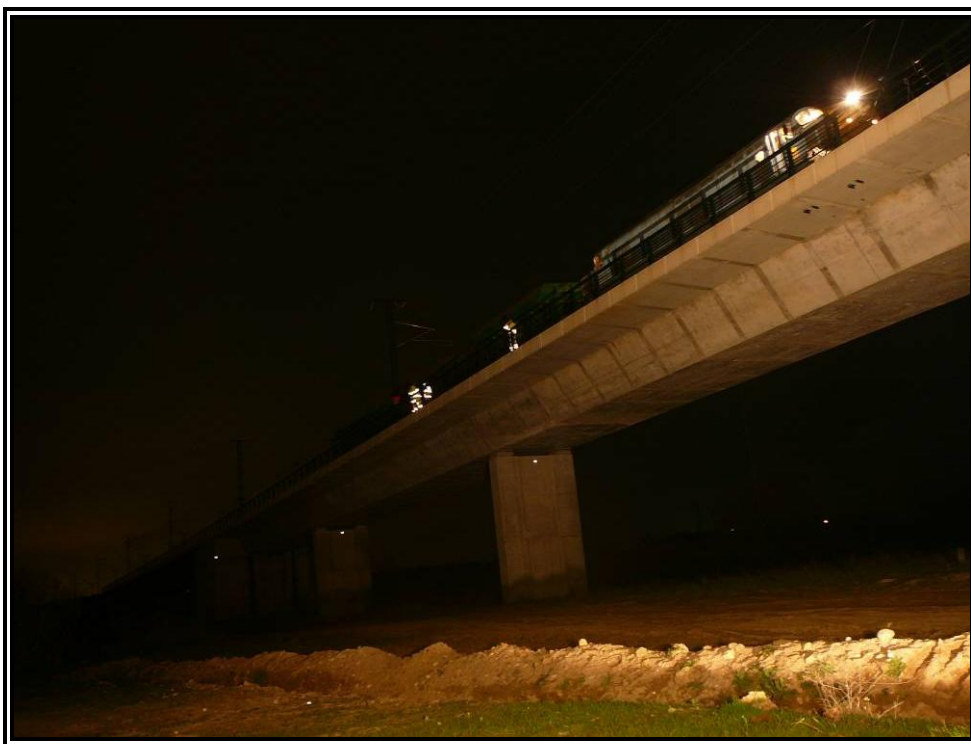
Nº 9.- Prueba estática, Estado 4 (carga en vanos 2 y 3)
