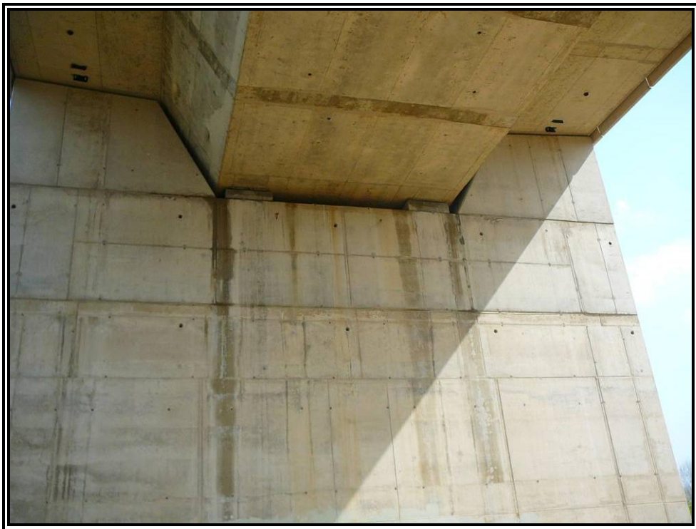
Nº 6.- Detalle de estribo.
