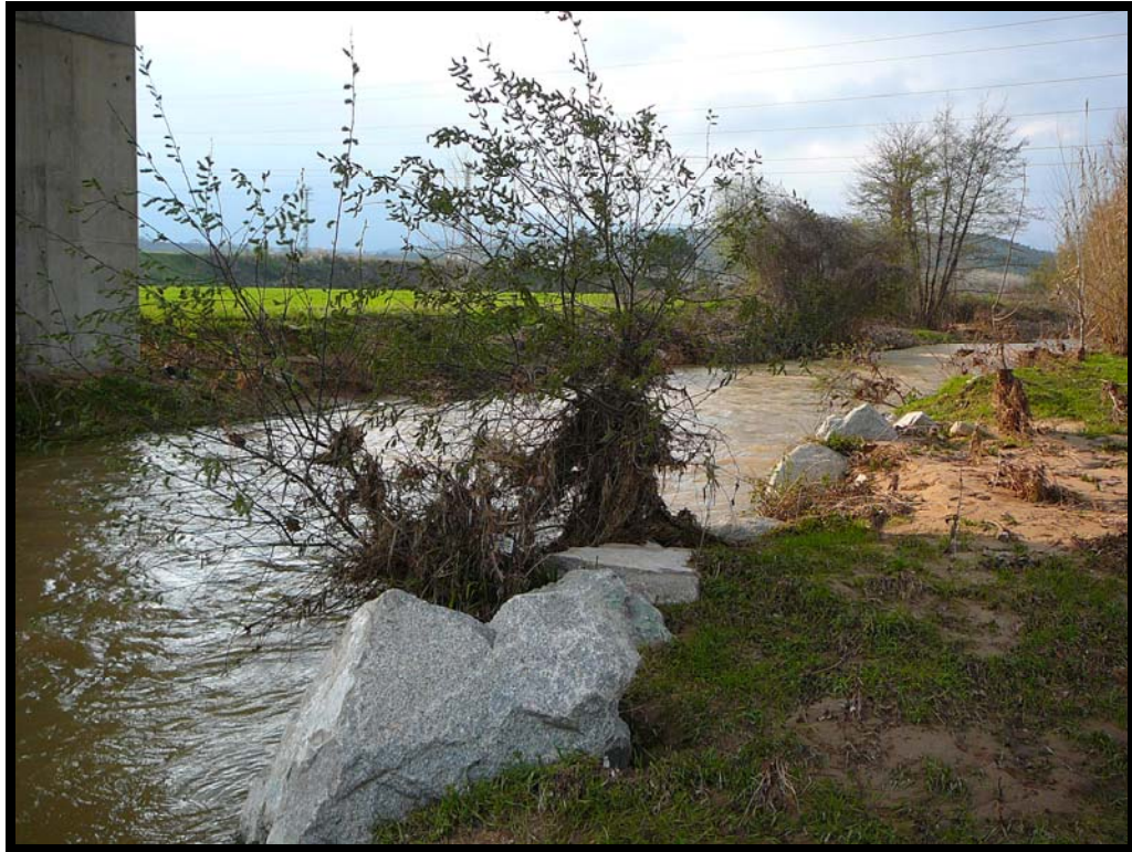
15. Escollera de protección en la margen izquierda, bajo la estructura.
