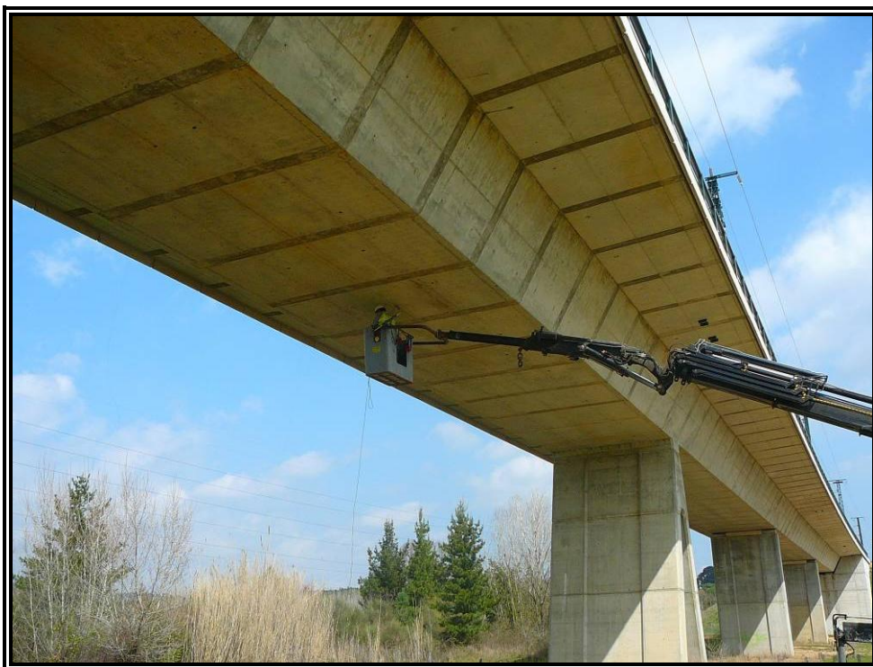
Nº 7.- Colocación de instrumentación en centro de vano.
