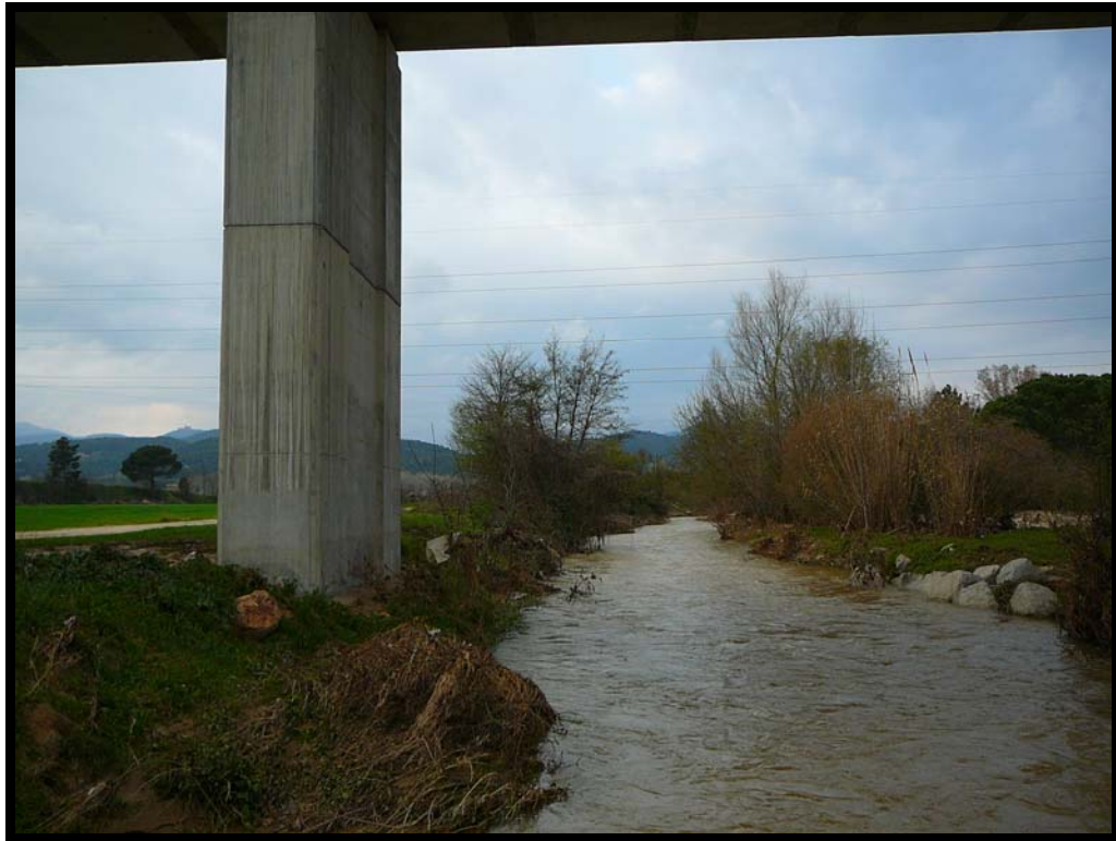
11. Cauce aguas arriba.
