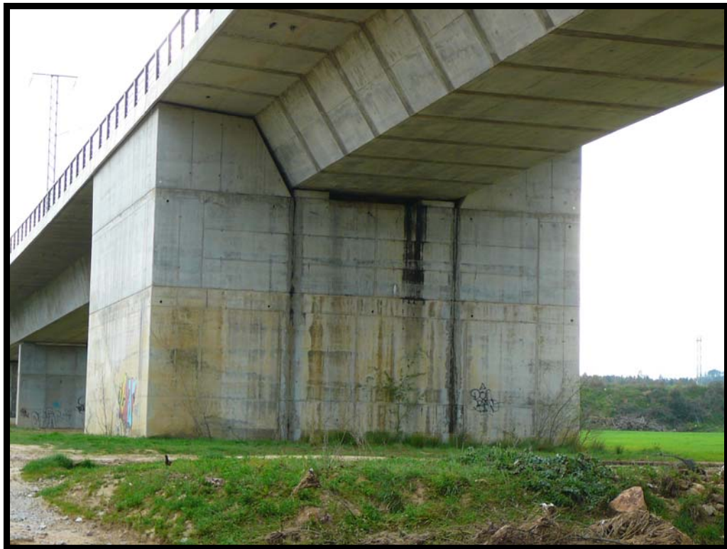
4. Estribo de entrada.
