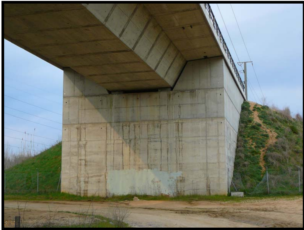
5. Estribo de salida.
