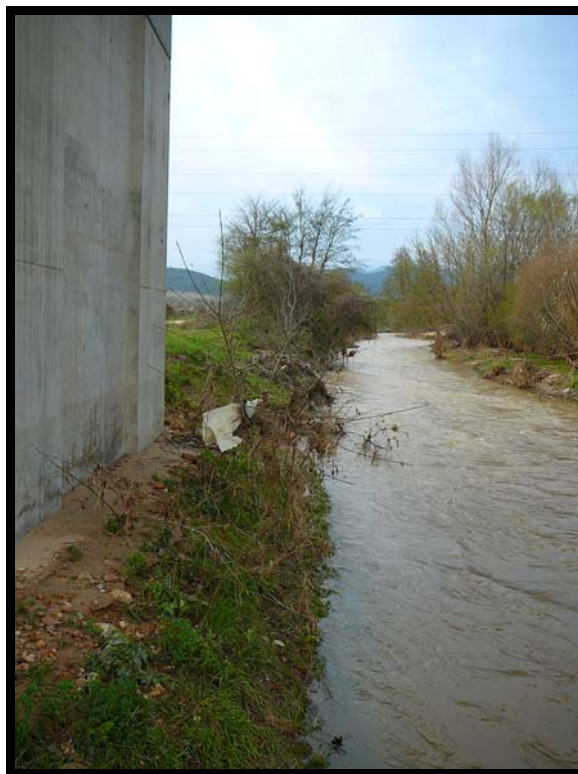
16. Proximidad del cauce a la pila 1.
