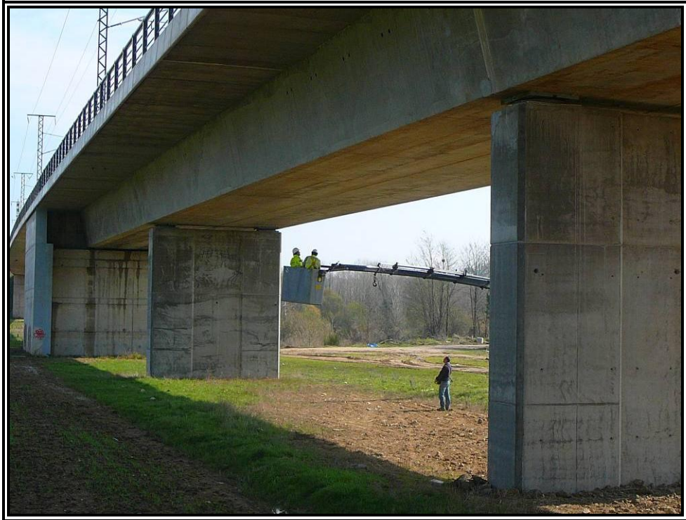
Nº 7.- Colocación de instrumentación en centro de vano.
