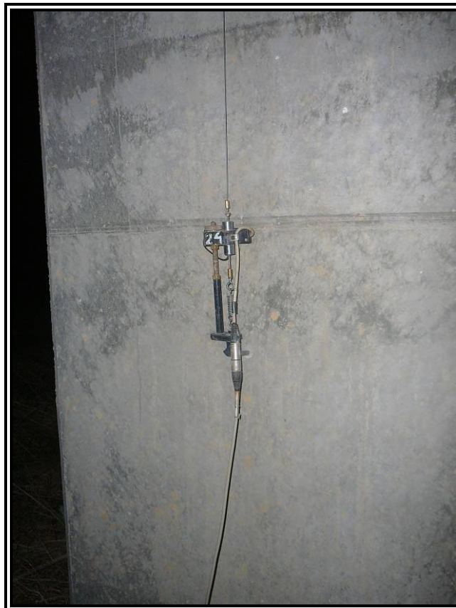
Nº 8.- Colocación de instrumentación en pila.
