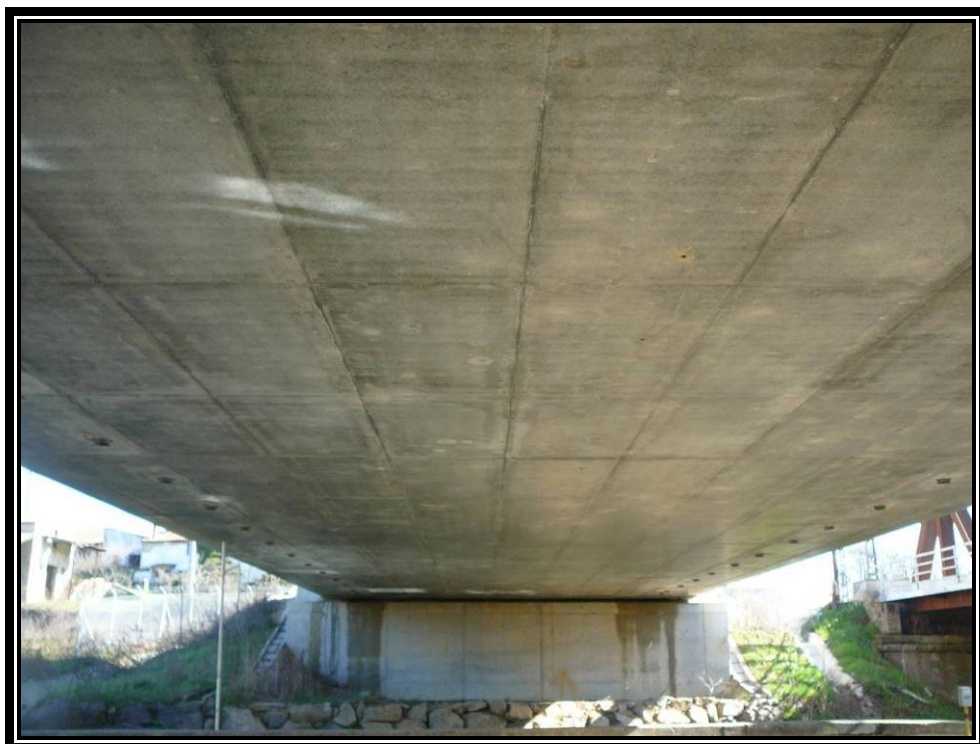
Nº 3.-Vista inferior de la estructura.
