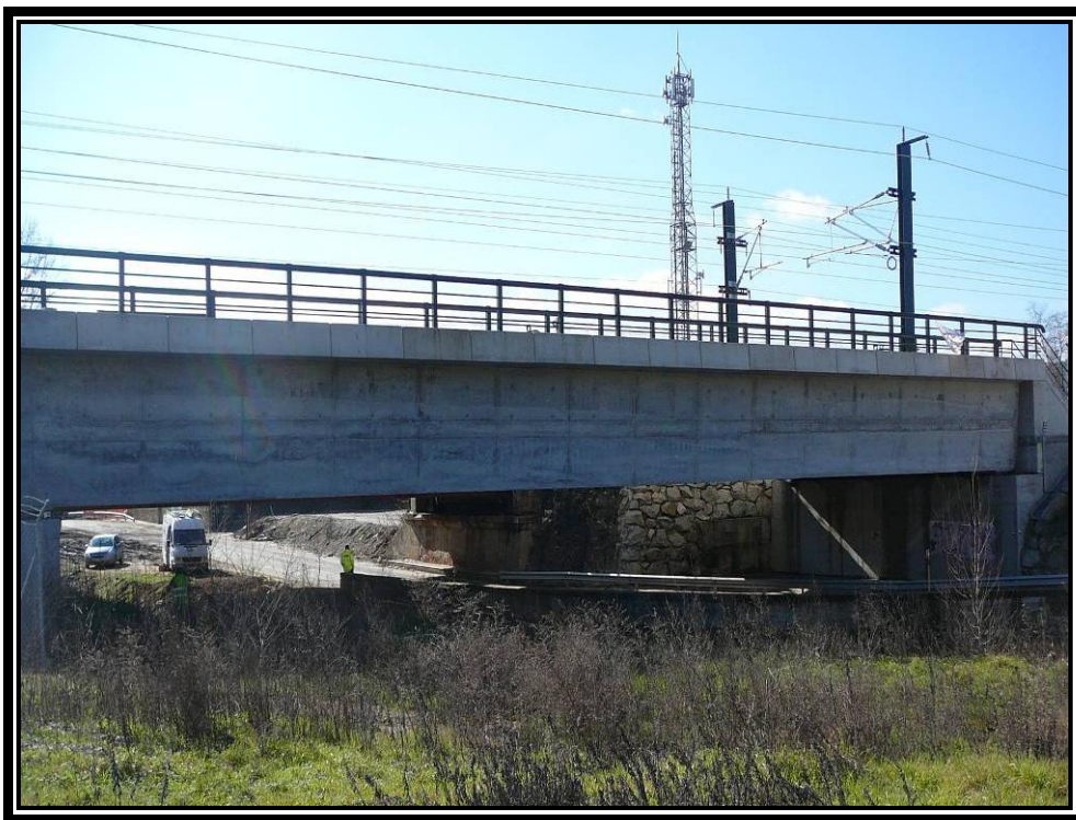
Nº 1.- Vista general de la estructura.
