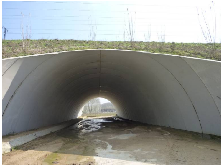
Fotografía N°2: Vista inferior de la bóveda.
