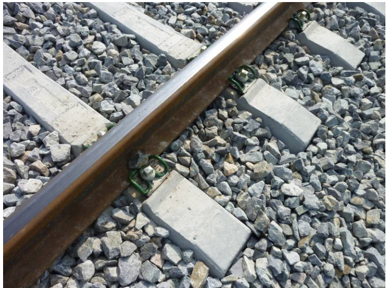
Fotografía N°5: Detalle sujeciones carril.
