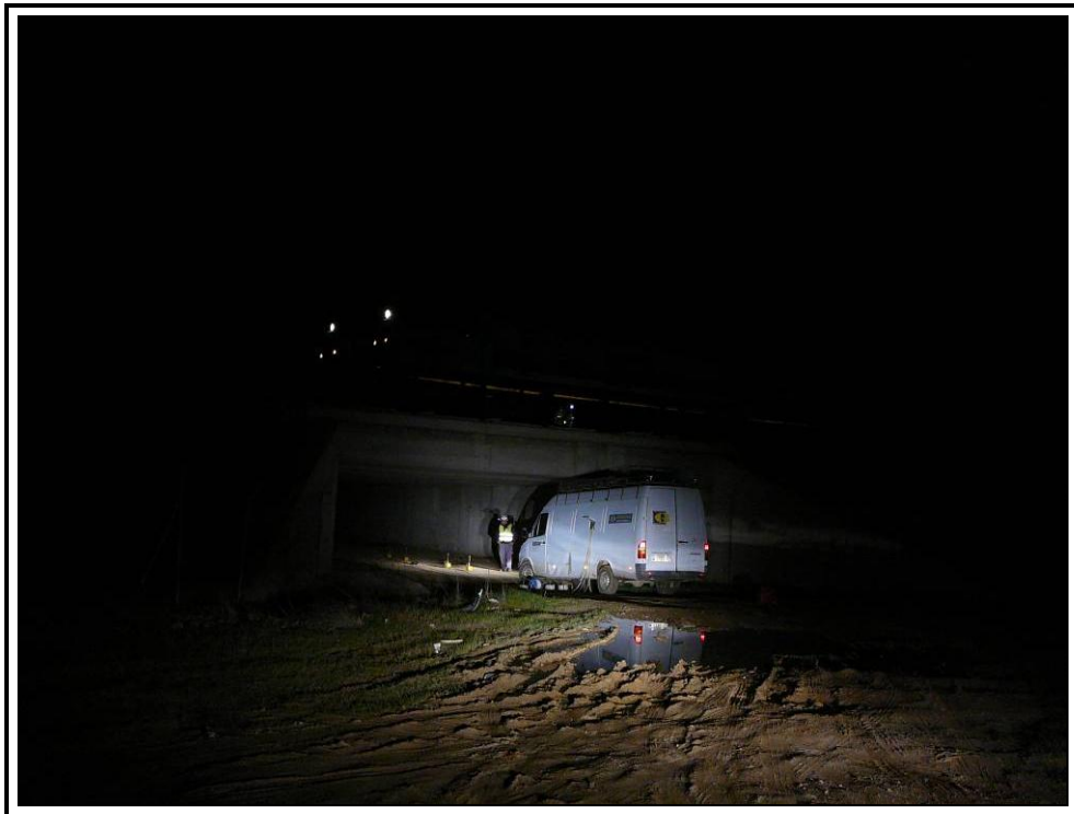
Nº 6.- Prueba estática y LVDT's en centro de vano.
