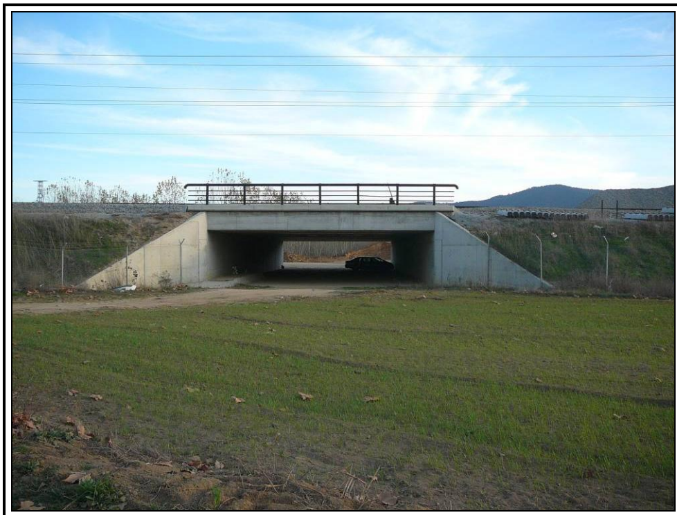
Nº 2.- Alzado izquierdo de la estructura.
