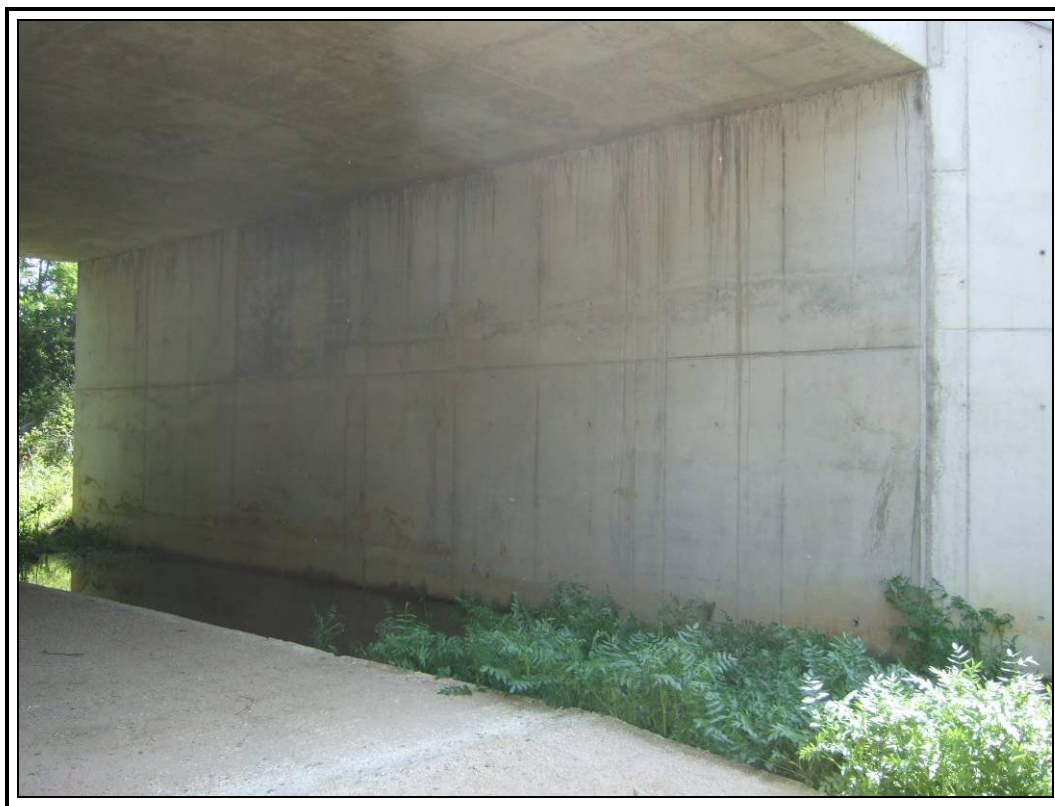
Estribo de entrada.
