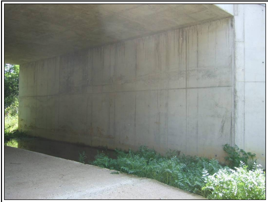
Estribo de entrada.
