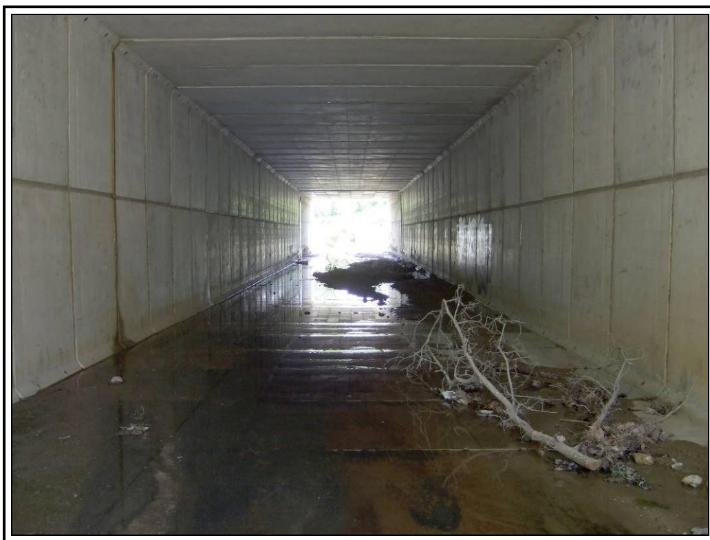
Acumulación de materiales
