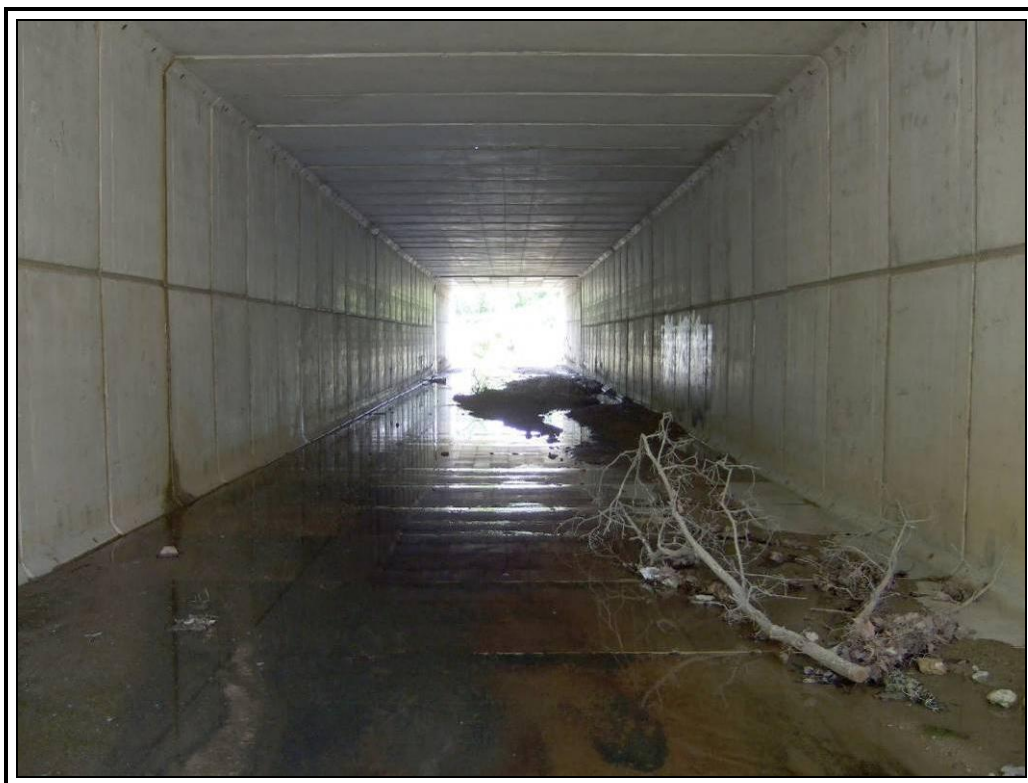
Vista inferior (cajón prefabricado e hincado)
