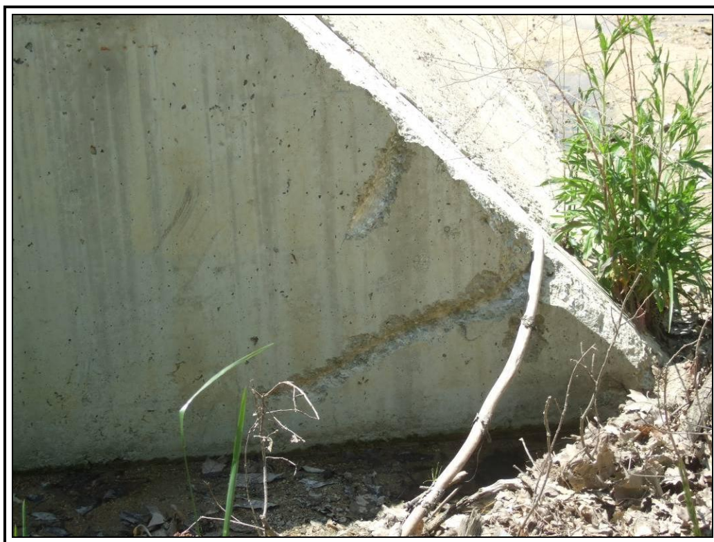
Desconchón por impacto en extremo de aleta izquierda hastial uno
