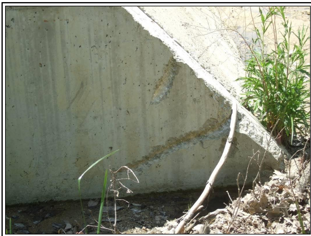
Desconchón por impacto en extremo de aleta izquierda hastial uno
