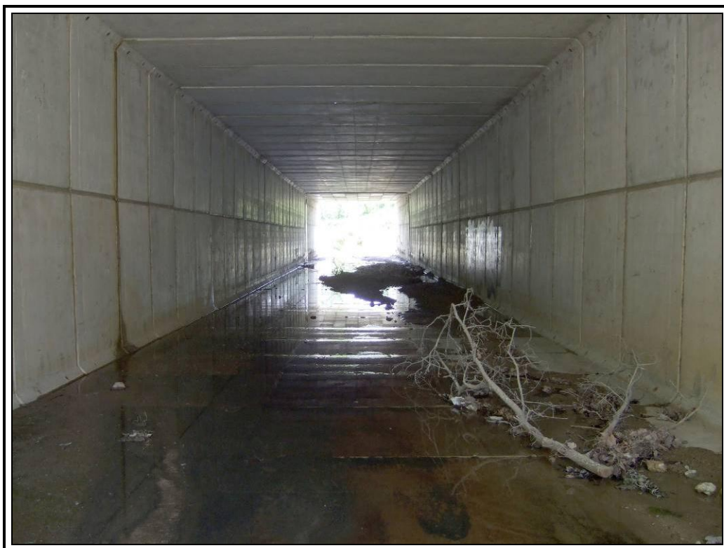
Acumulación de materiales
