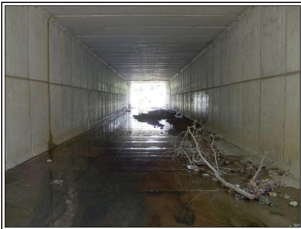
Vista inferior (cajón prefabricado e hincado)
