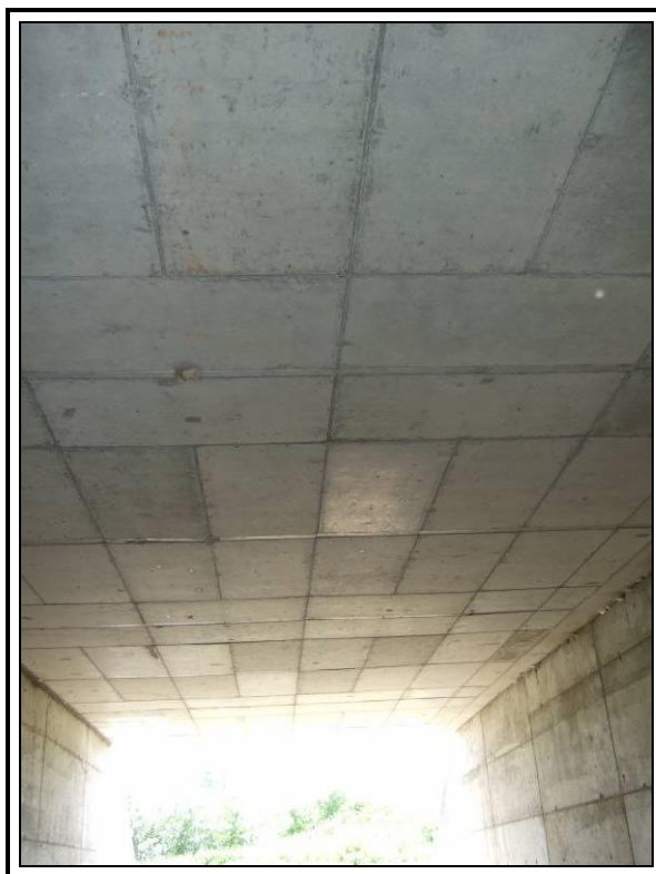
Vista inferior (cajón hincado)
