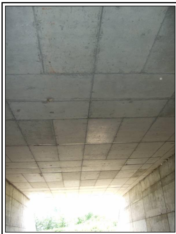
Vista inferior (cajón hincado)
