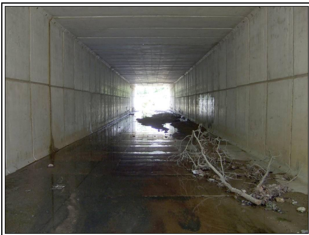
Acumulación de materiales
