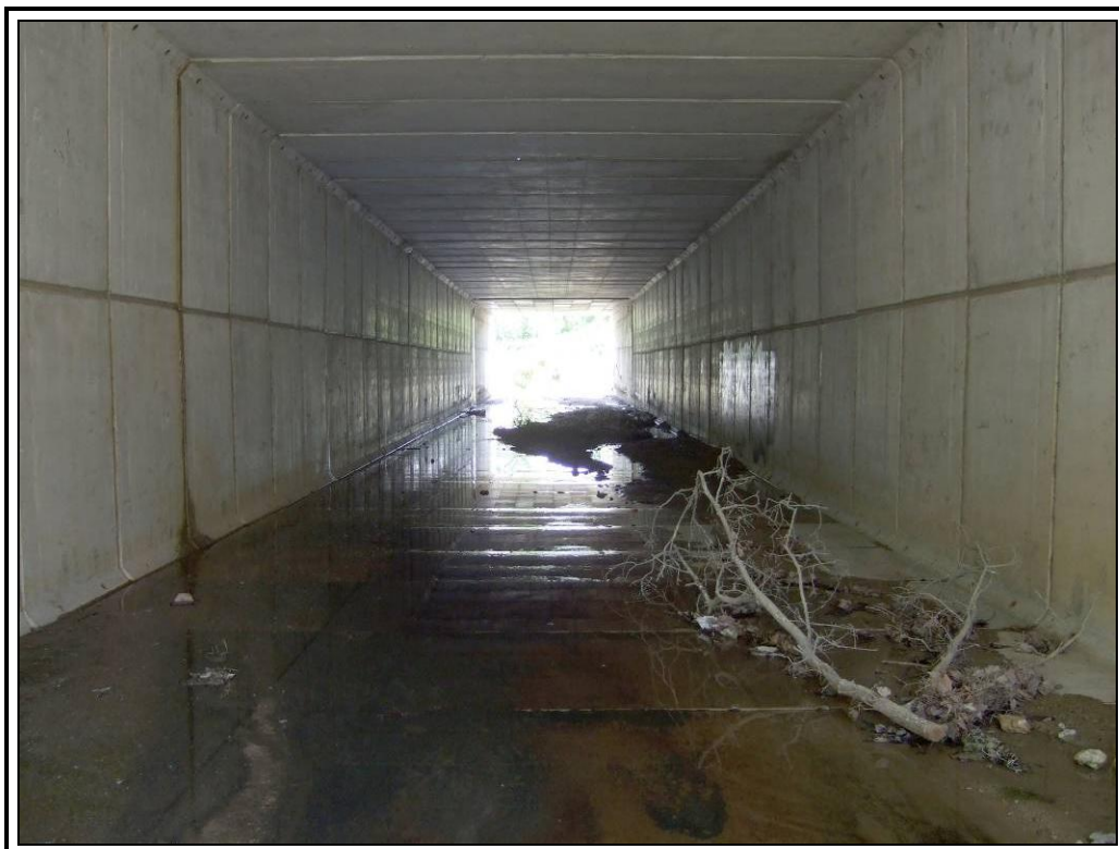
Acumulación de materiales
