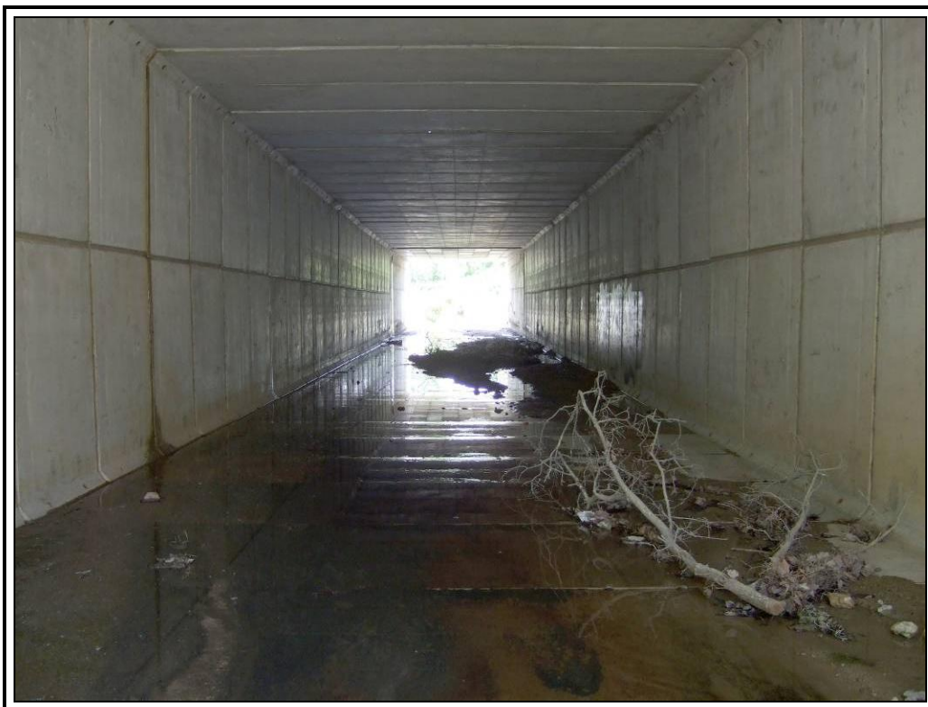
Vista inferior (cajón prefabricado e hincado)
