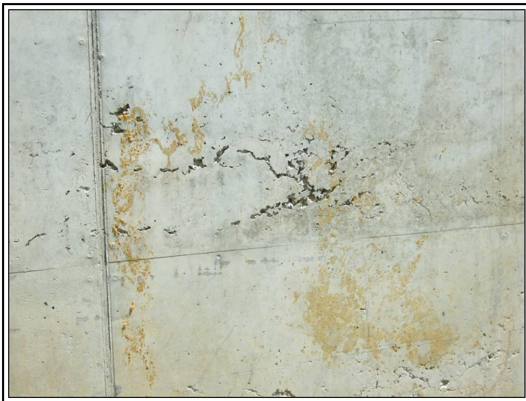
Coqueras en aleta derecha de hastial uno
