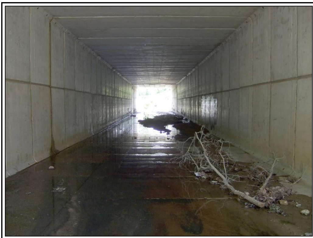
Vista inferior (cajón prefabricado e hincado)
