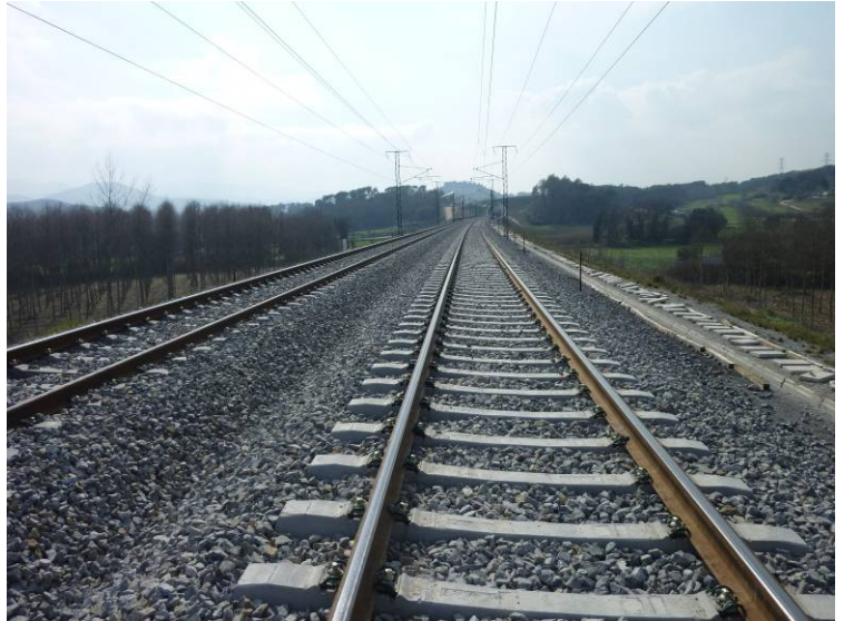
Fotografía N°4: Vista desde el estribo 2.
