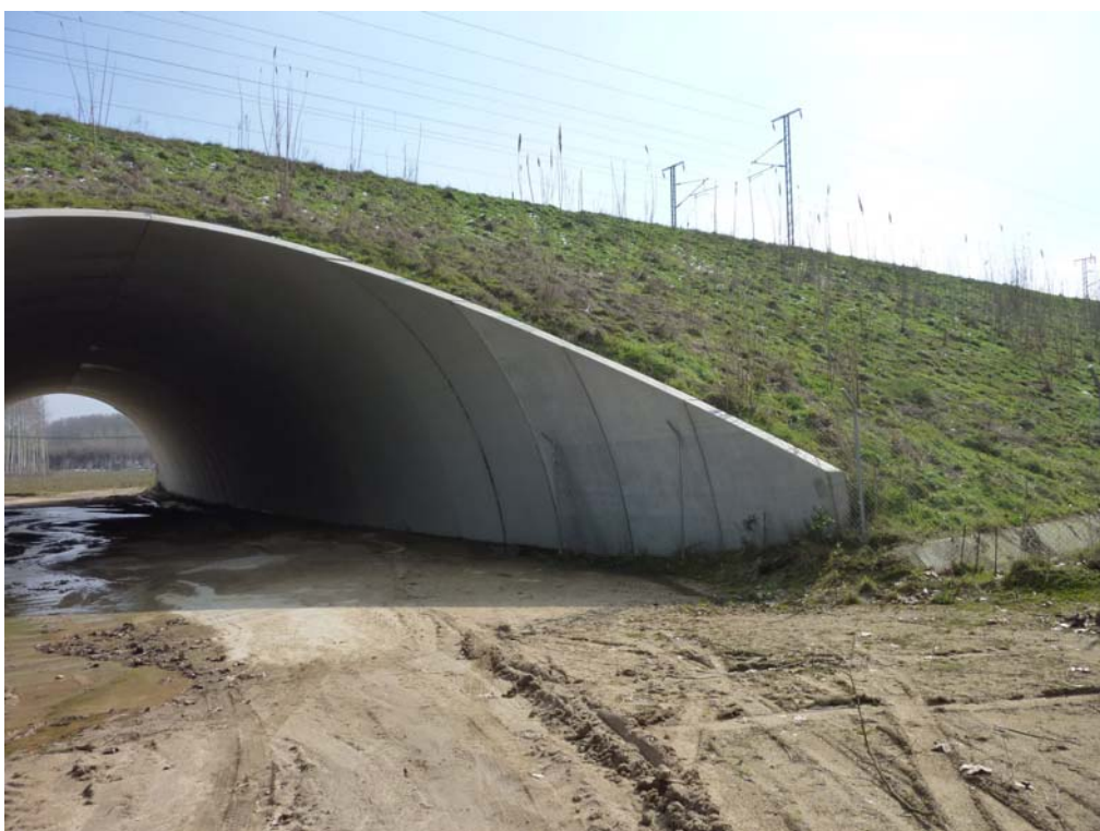
Estribo de entrada
