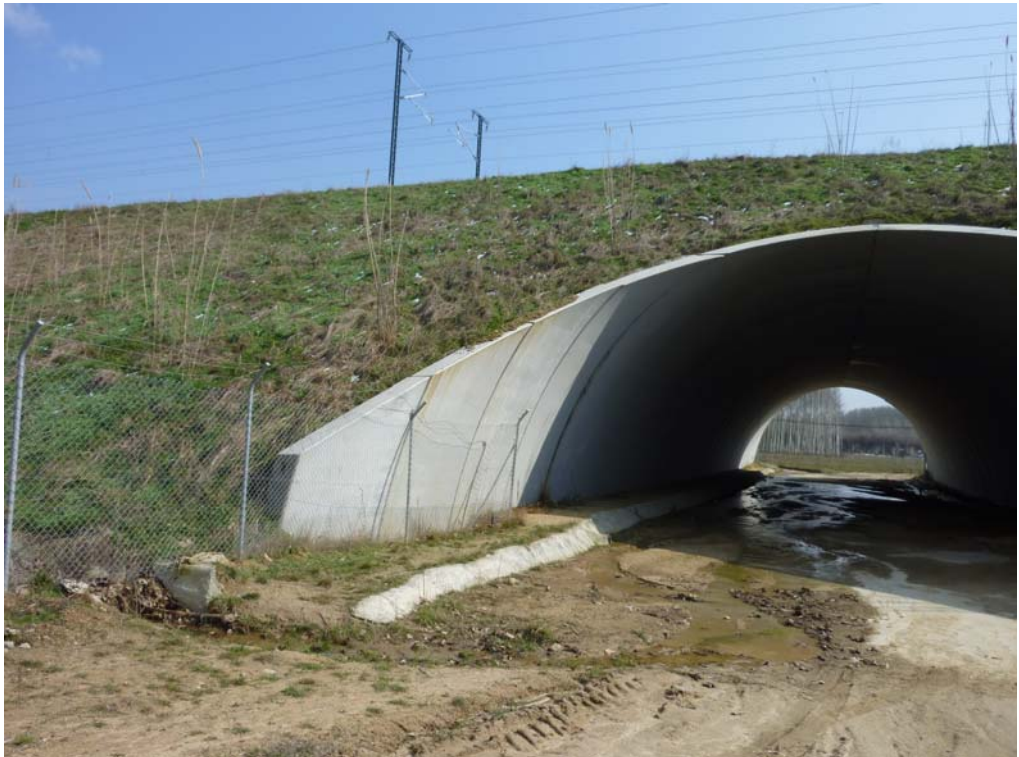
Estribo de salida
