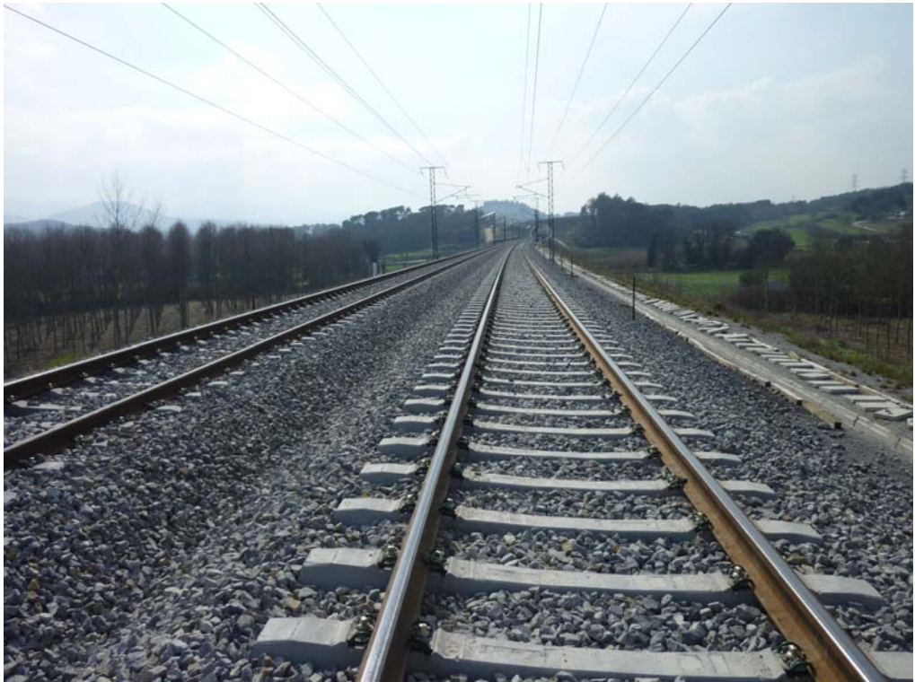
Vista superior desde el estribo de salida hacia Barcelona
