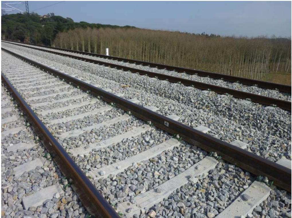
Material de vía
