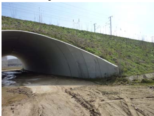
Fotografía nº 5. Estribo de entrada
