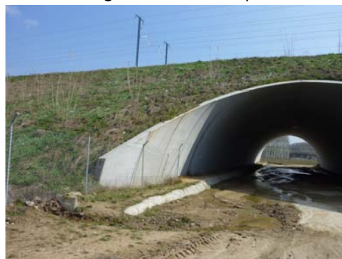
Fotografía nº 6. Estribo de salida
