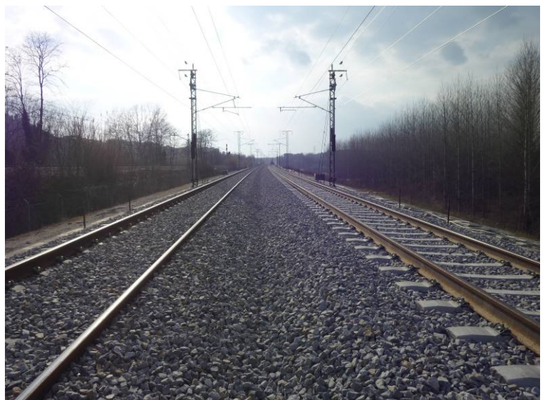
Fotografía N°9: Vista desde el Estribo 2 hacia el Estribo 1.
