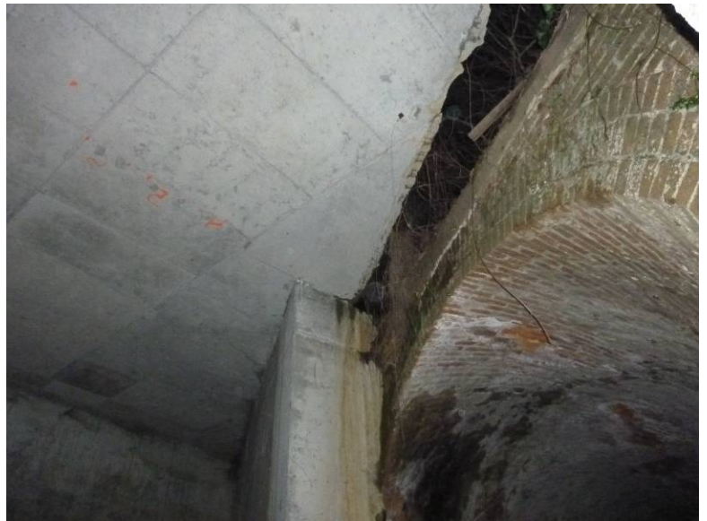
Fotografía N°4: Detalle del encuentro entre muros y losa superior.
