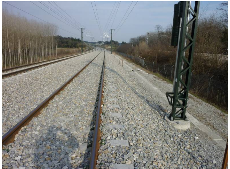
Fotografía N°10: Vista lateral derecha de la plataforma.
