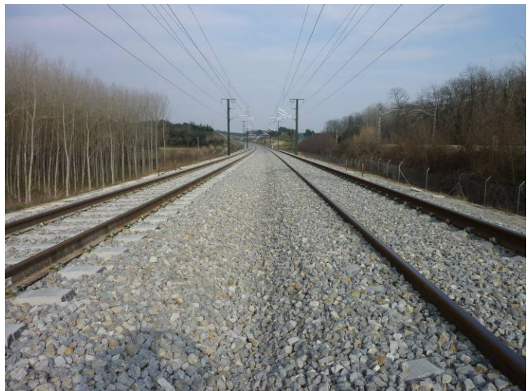
Fotografía N°8: Vista superior del Estribo de entrada.
