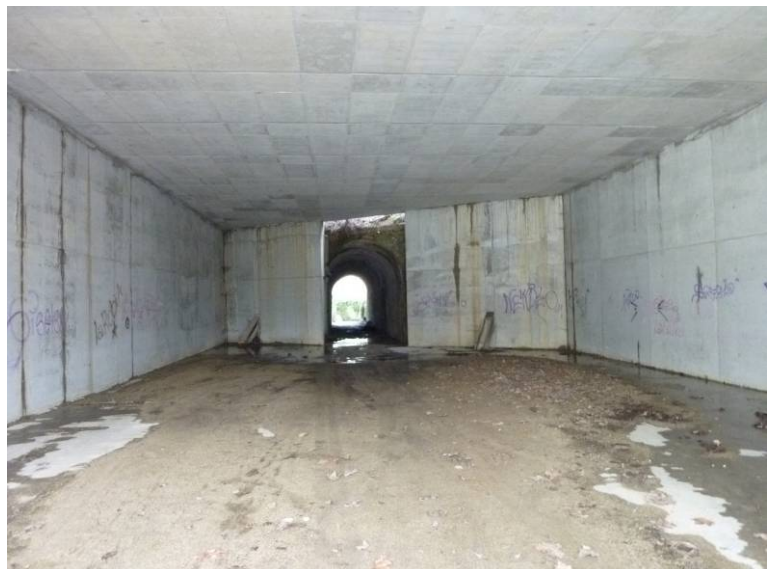
Fotografía N°3: Vista inferior de la losa superior y muros de contención.
