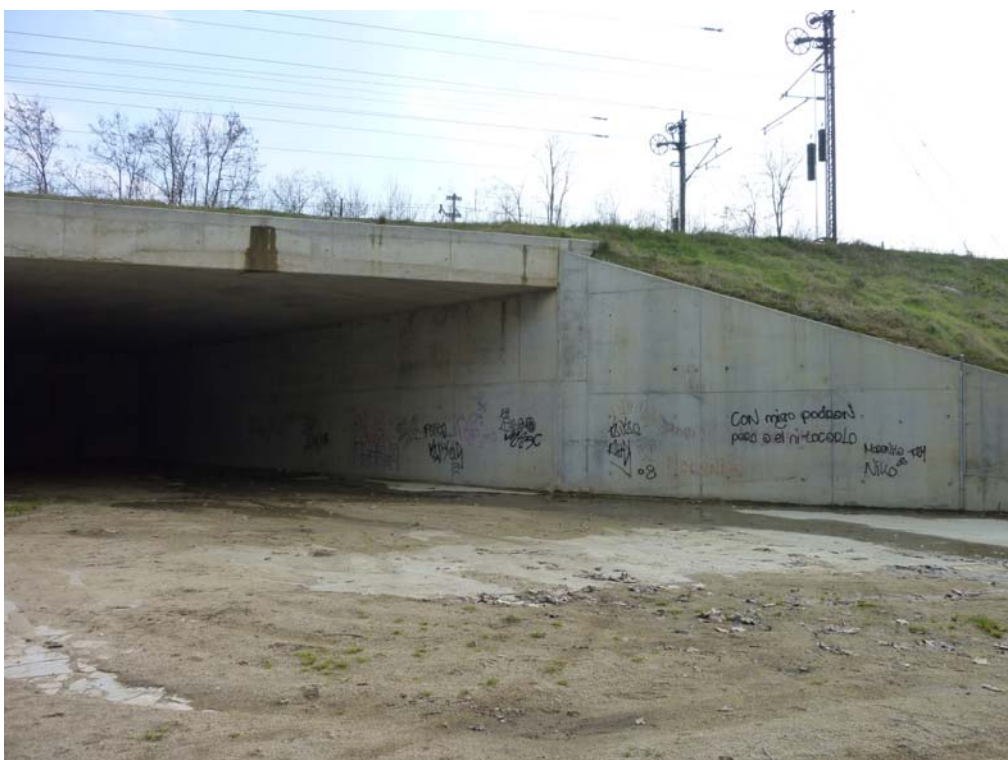
Fotografía 584: Estribo de entrada
