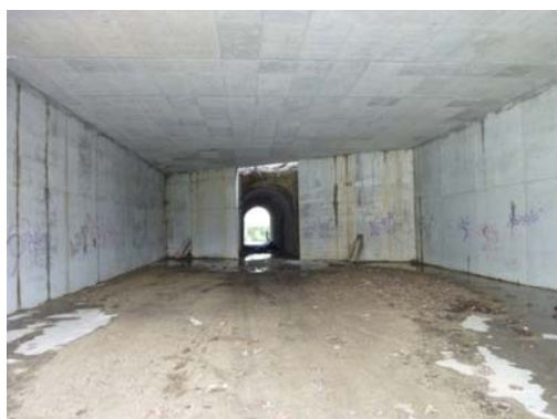
Fotografía nº 1. Vista "interior" del alzado derecho
