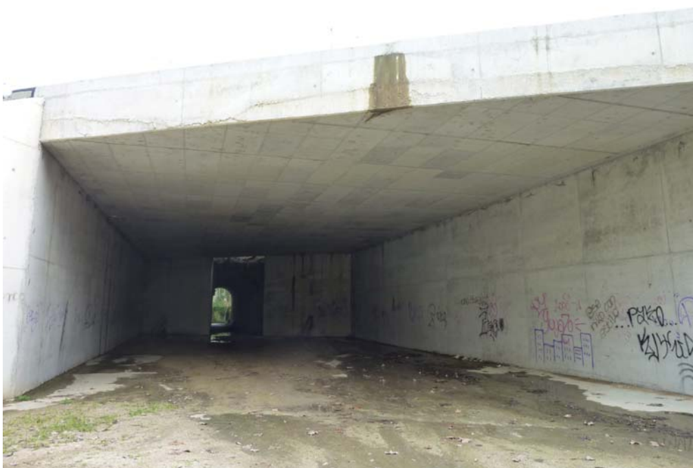
Fotografía 586: Vista inferior de la losa superior
