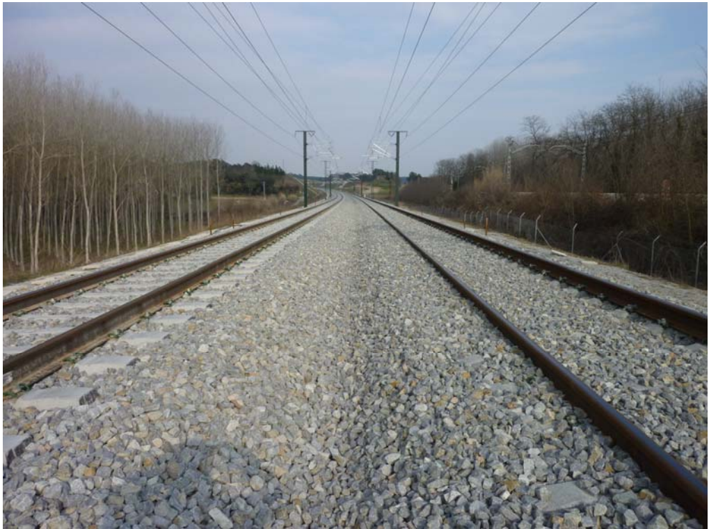
Fotografía 577: Vista superior desde el estribo de entrada
