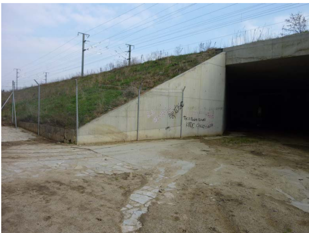
Fotografía 585: Estribo de salida
