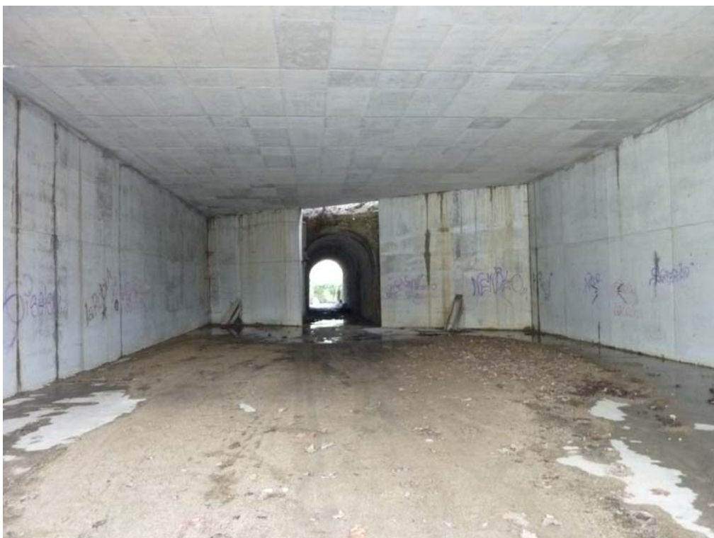
Fotografía 587: Vista inferior de la losa superior
