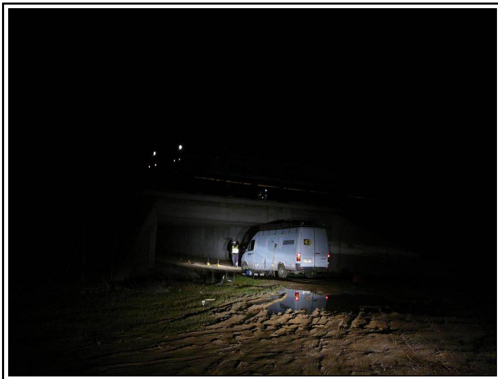
Nº 6.- Prueba estática y LVDT's en centro de vano.
