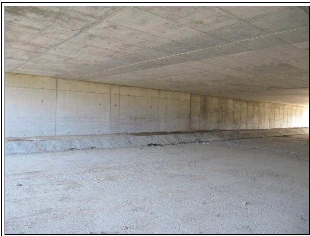
Estribo de salida
