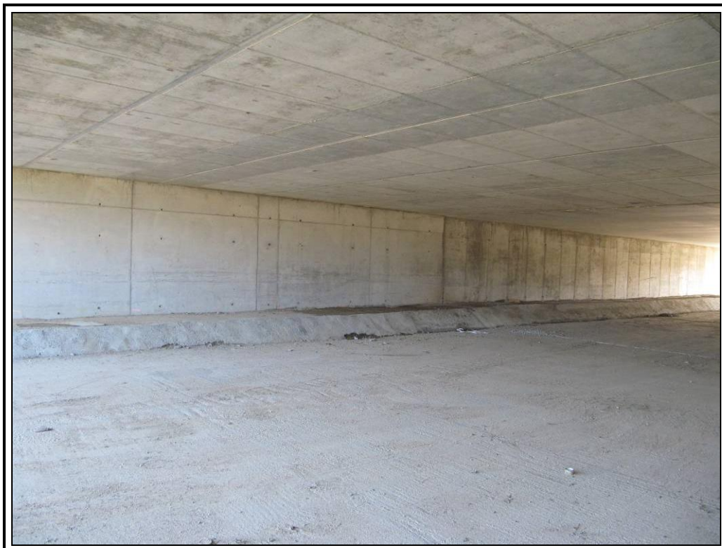
Estribo de salida
