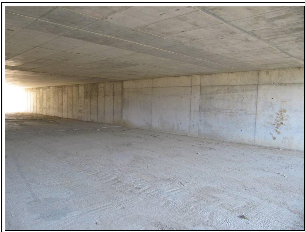
Estribo de entrada
