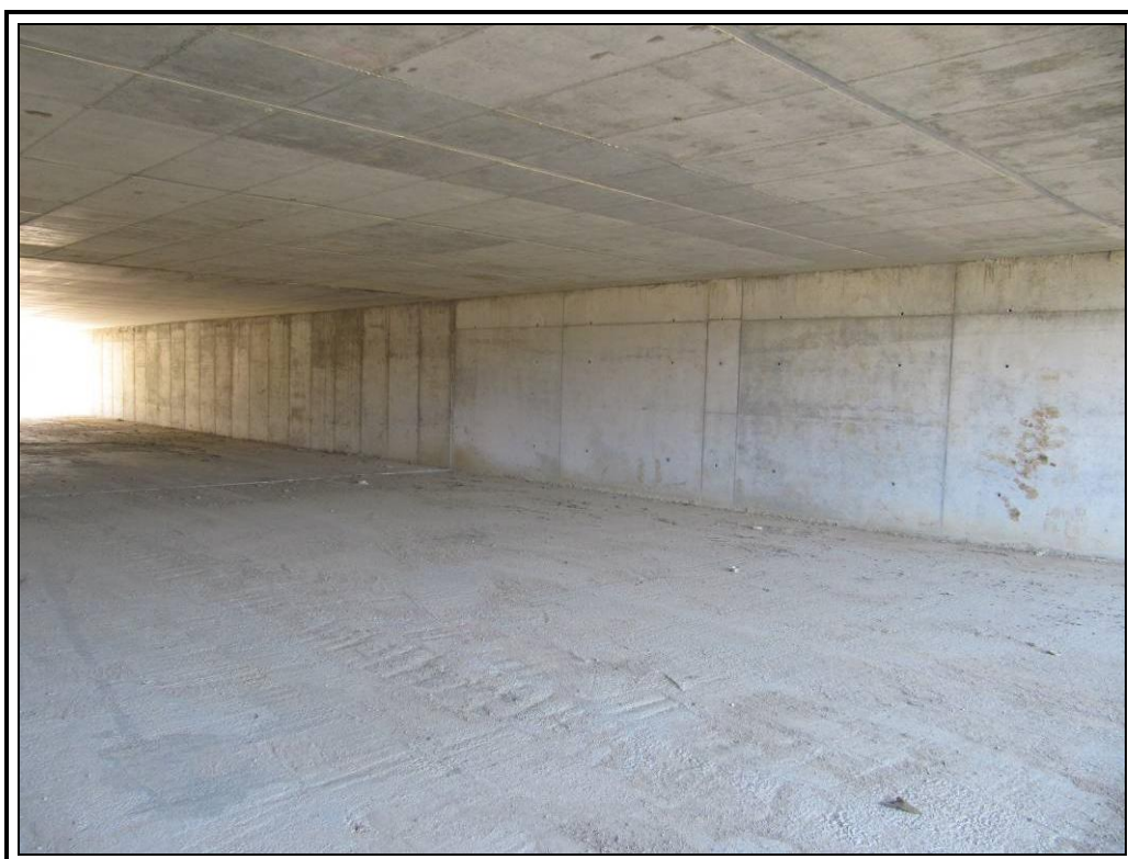
Estribo de entrada
