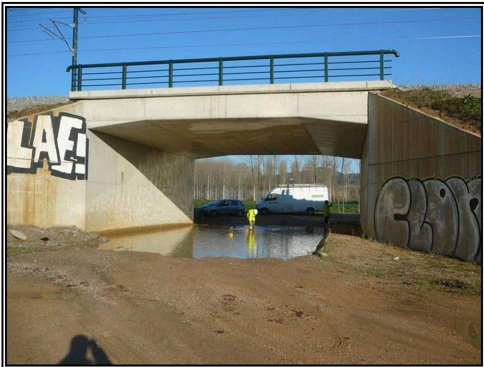
Nº 6.- Colocación de la instrumentación.
