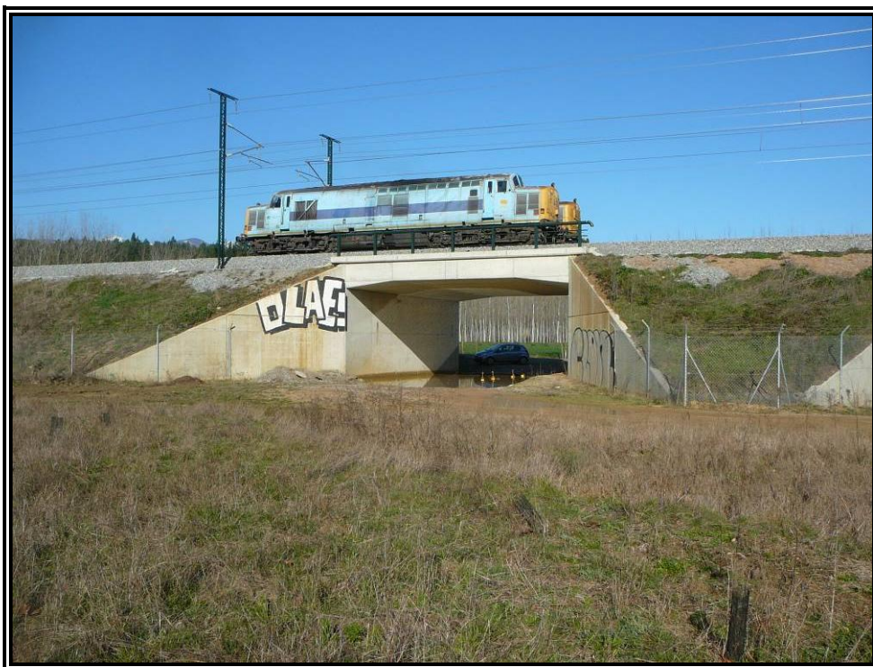
Nº 7.- Realización de prueba estática.
