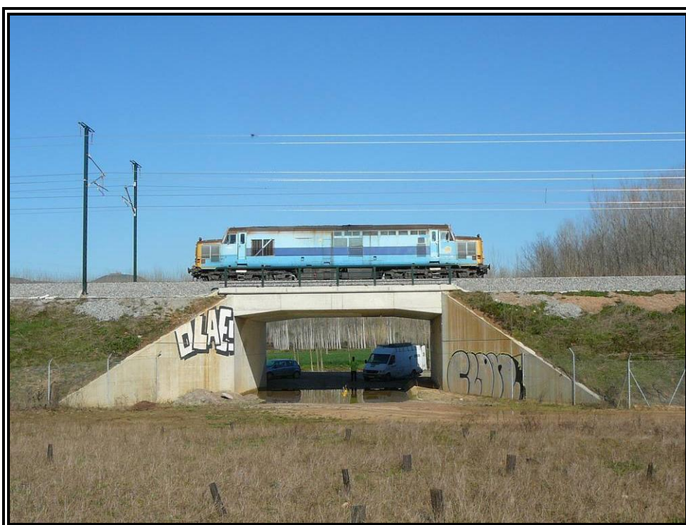
Nº 8.- Realización de prueba dinámica.
