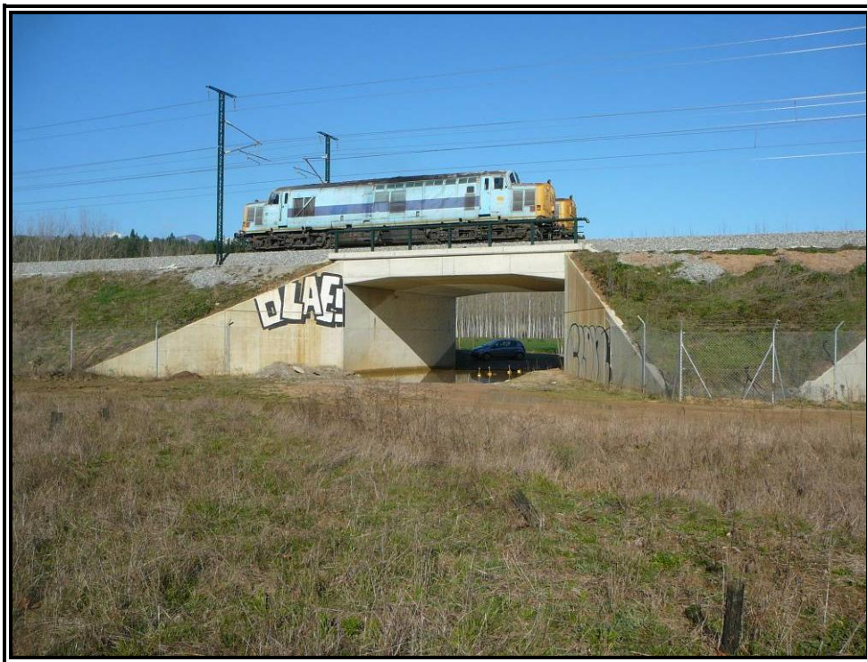
Nº 7.- Realización de prueba estática.
