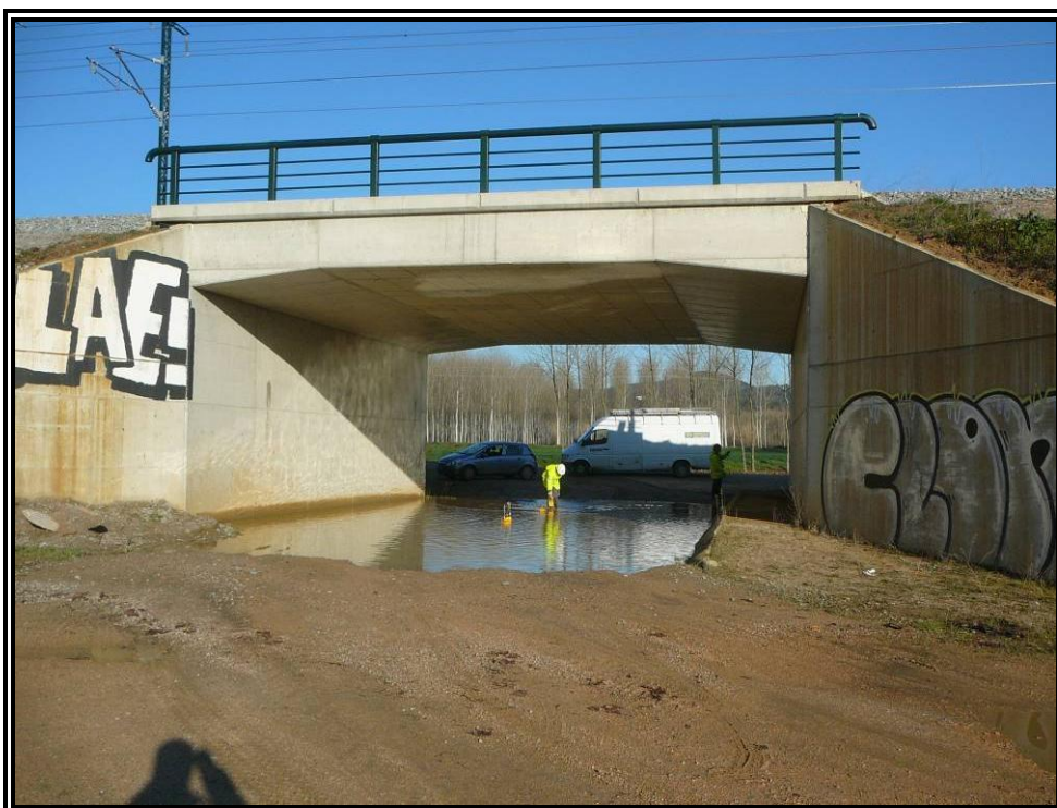
Nº 6.- Colocación de la instrumentación.
