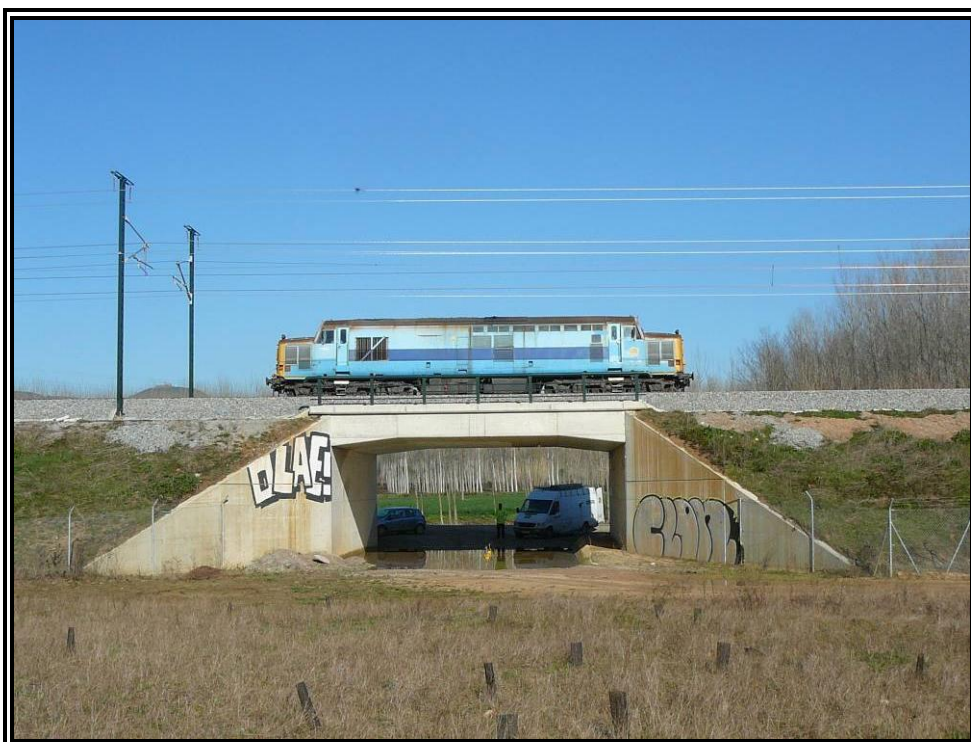
Nº 8.- Realización de prueba dinámica.
