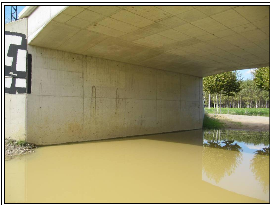
Estribo de entrada
