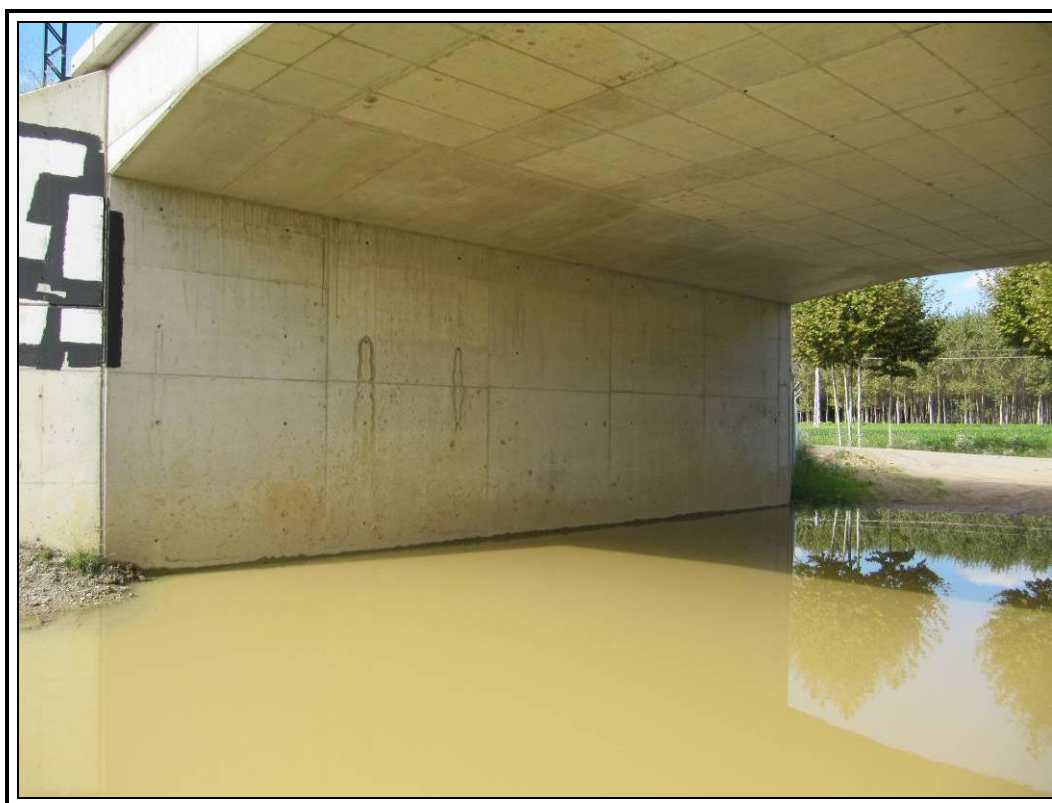
Estribo de entrada
