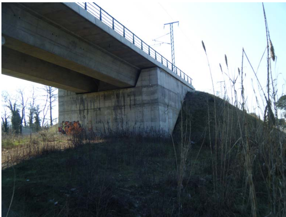
Vista estribo de entrada
