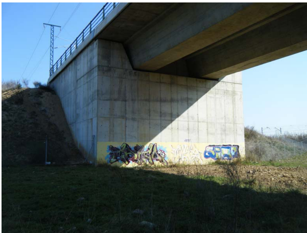
Vista estribo de salida
