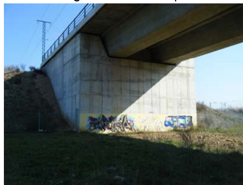
Fotografía nº 6. Estribo de salida
