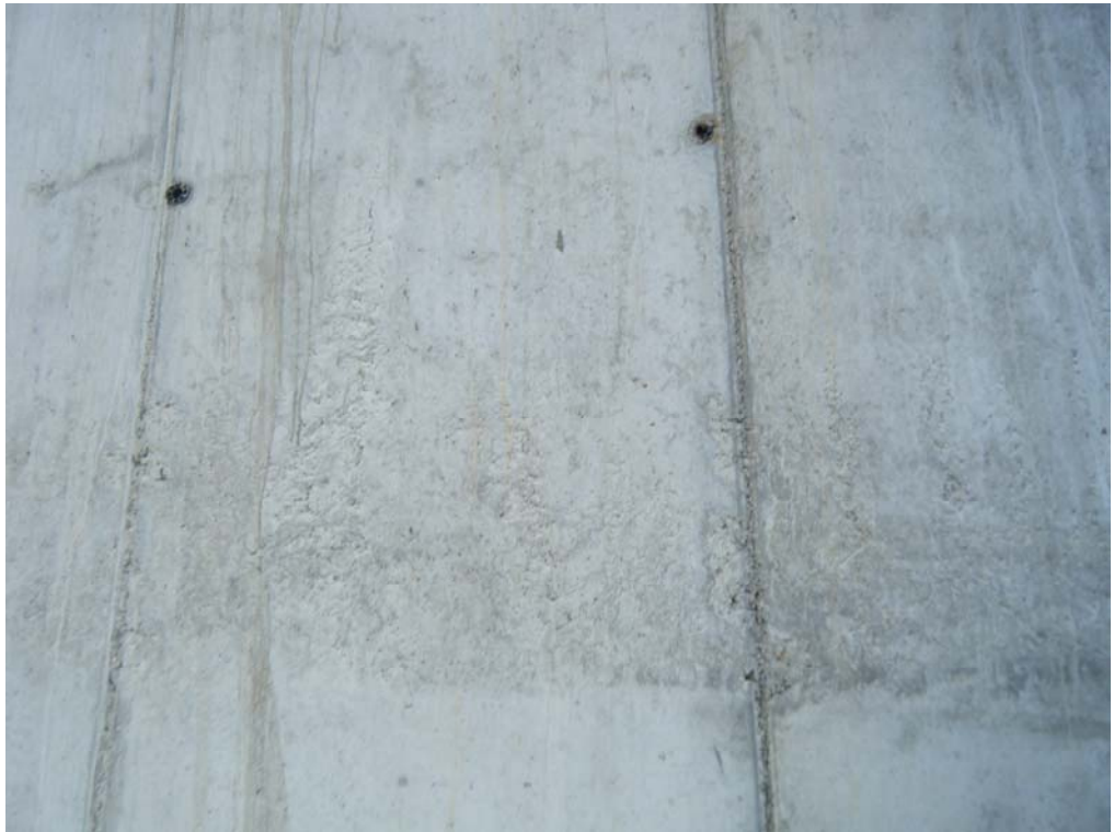
Nido de grava P-1 lado vano nº 2
