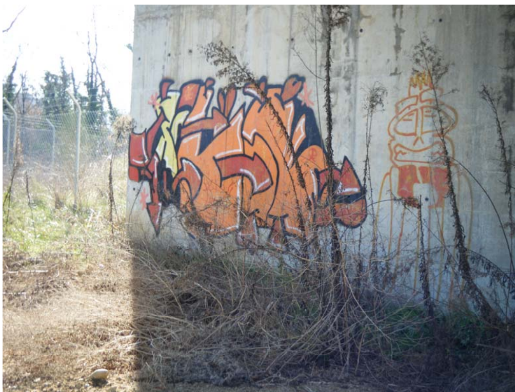
Pintadas en el estribo de entrada
