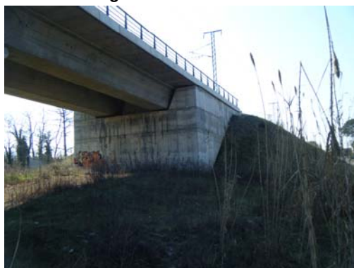
Fotografía nº 5. Estribo de entrada
