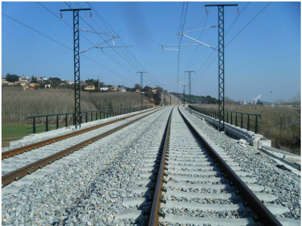
Vista desde el estribo de entrada
