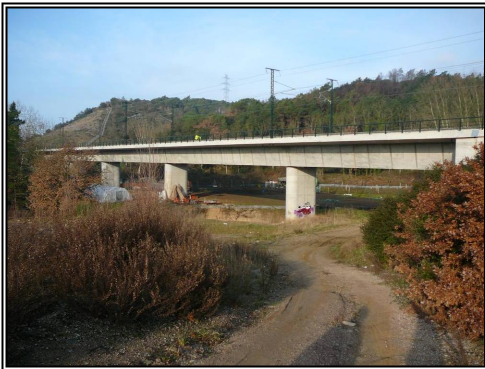
Nº 1.- Vista general de la estructura.
