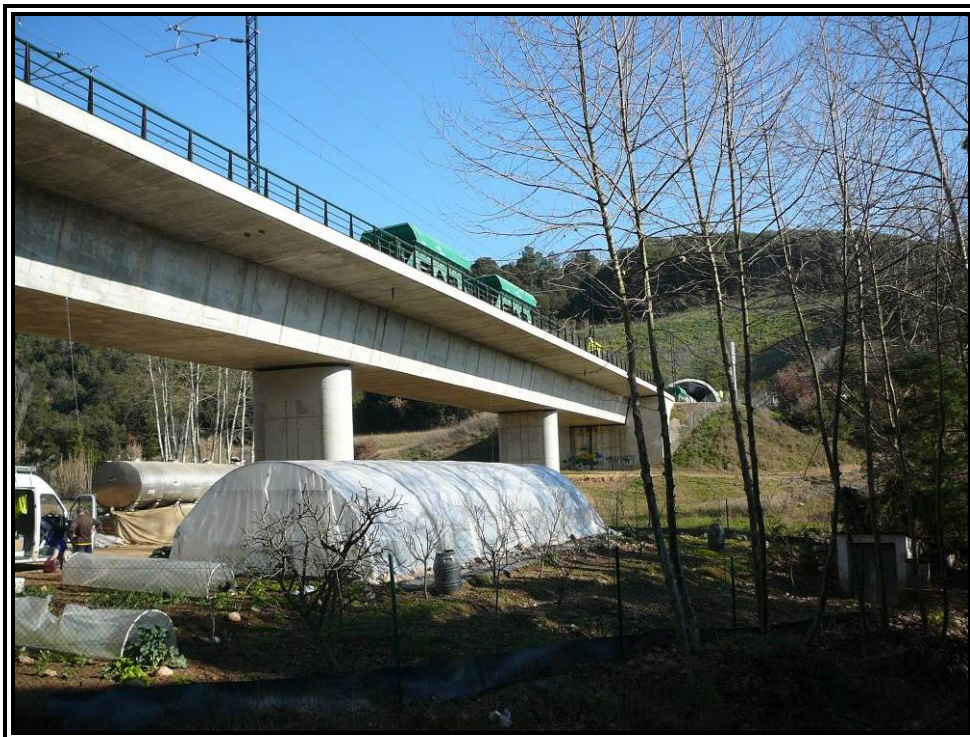
Nº 13.- Prueba estática, Estado 5 (carga en vano 4).
