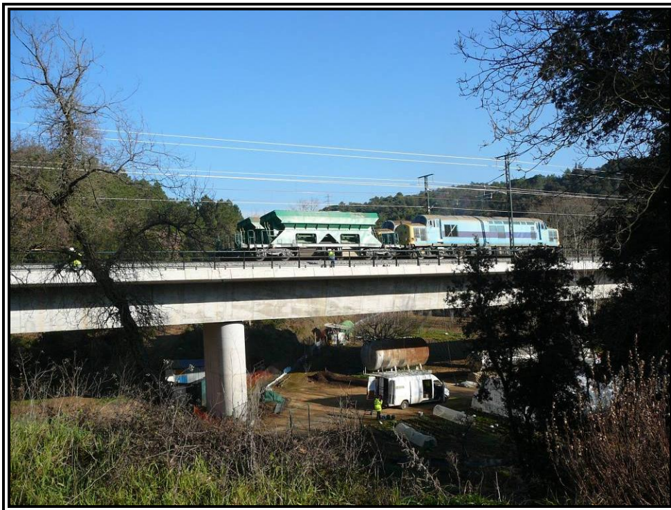
Nº 10.- Prueba estática, Estado 2 (carga en vano 2).
