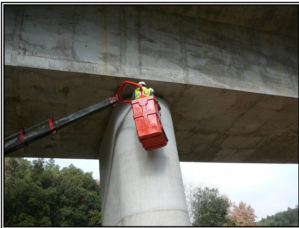
Nº 6.- Trabajos de instrumentación en pila.
