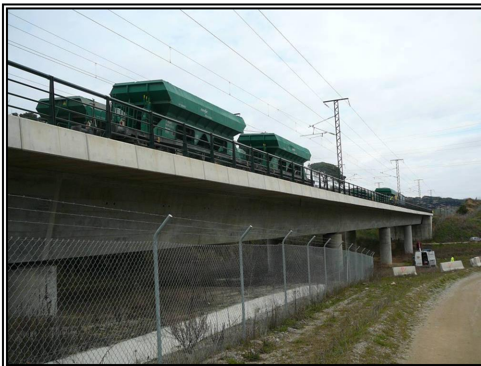
Nº 14.- Prueba estática, Estado 7 (carga en vanos 2 y 4).
