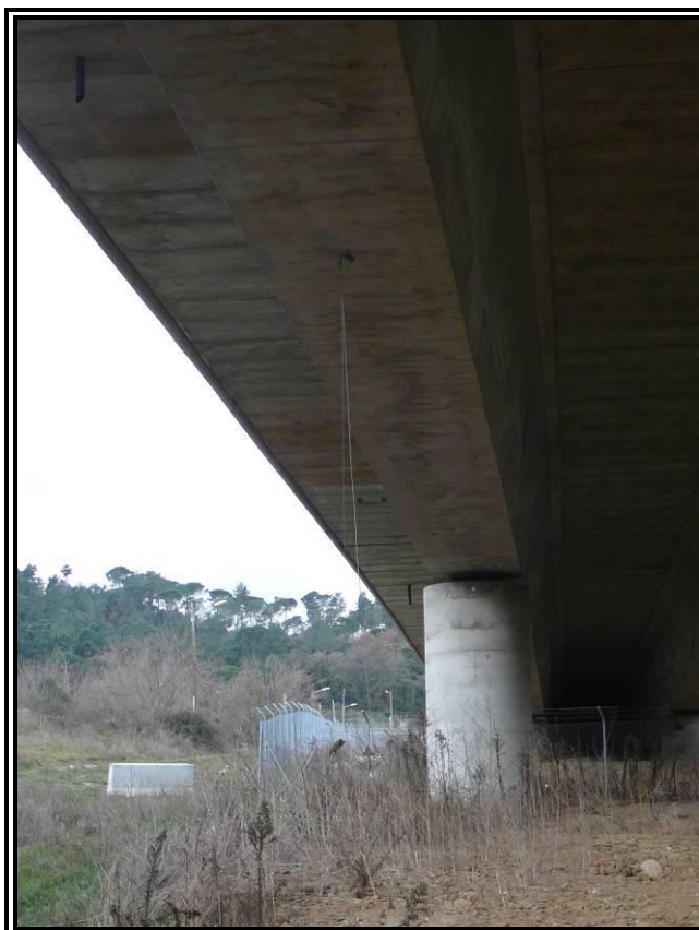
Nº 6.- Centro de vano instrumentado.
