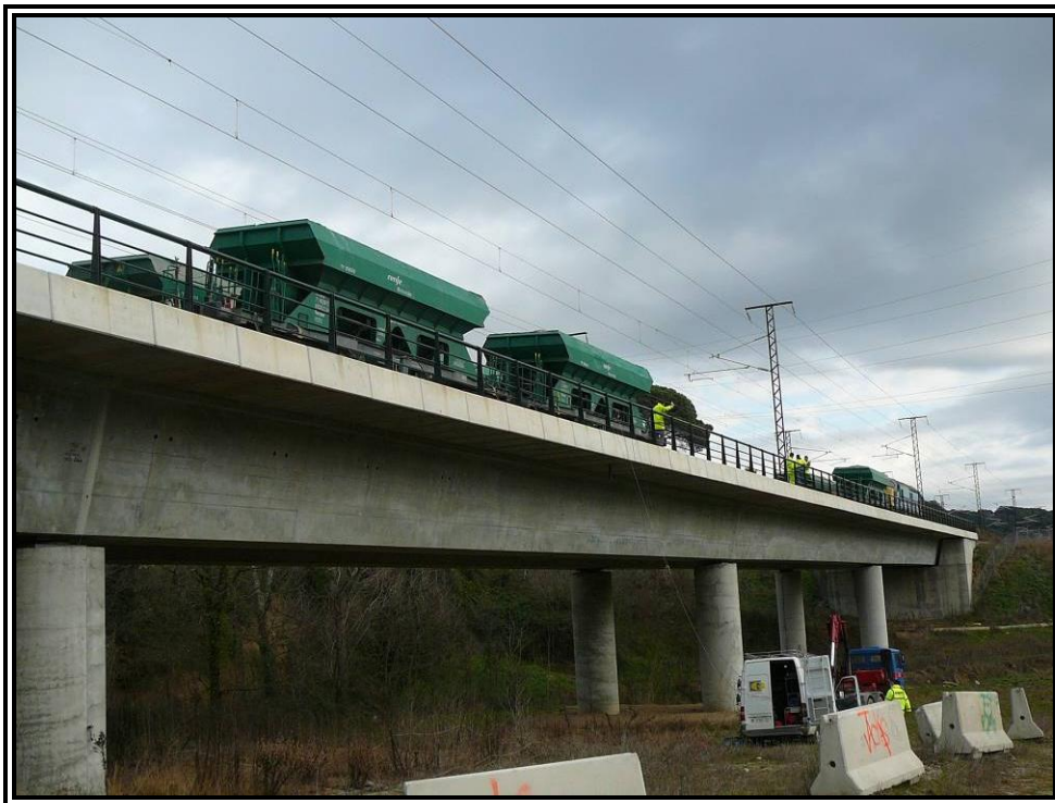
Nº 11.- Prueba estática, Estado 4 (carga en vanos 3 y 5).
