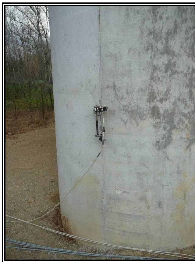
Nº 7.- Colocación de instrumentación en pila.
