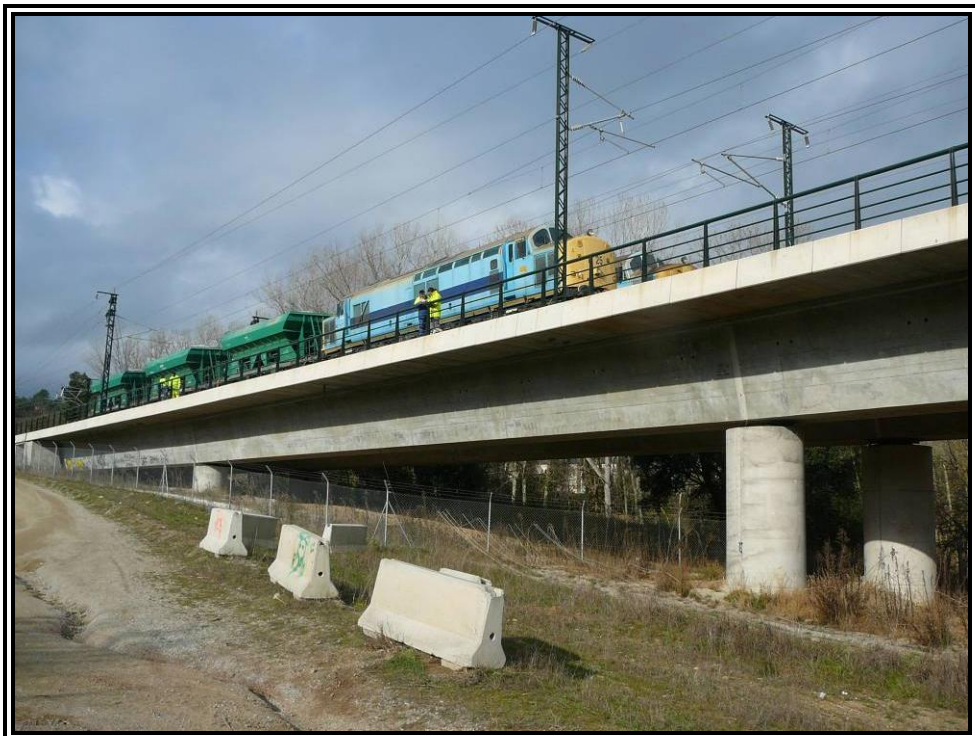
Nº 10.- Prueba estática, Estado 3 (carga en vanos 1 y 2).
