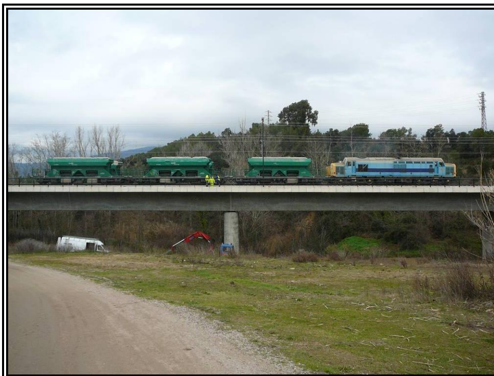
Nº 13.- Prueba estática, Estado 6 (carga en vanos 3 y 4).
