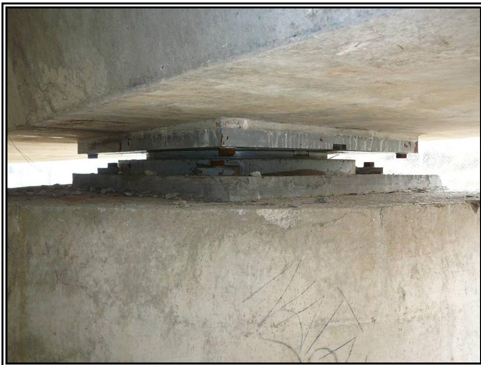
Nº 5.- Detalle apoyo tipo POT.
