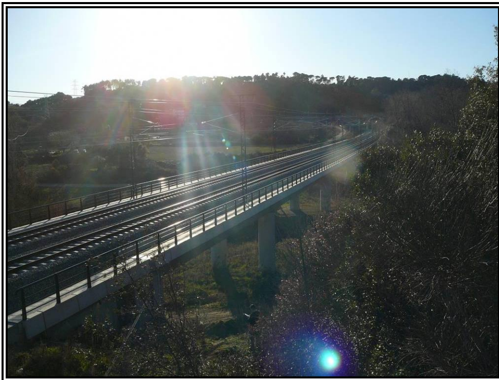
Nº 1.- Vista general de la estructura.
