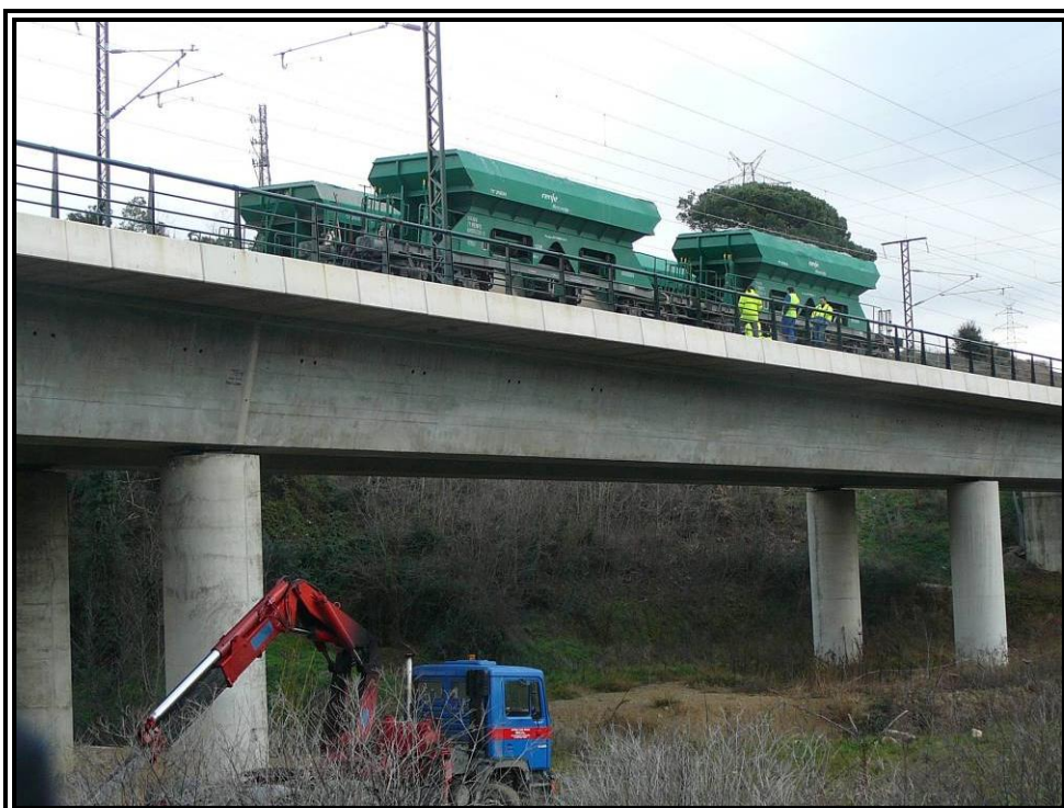
Nº 12.- Prueba estática, Estado 5 (carga en vano 4).
