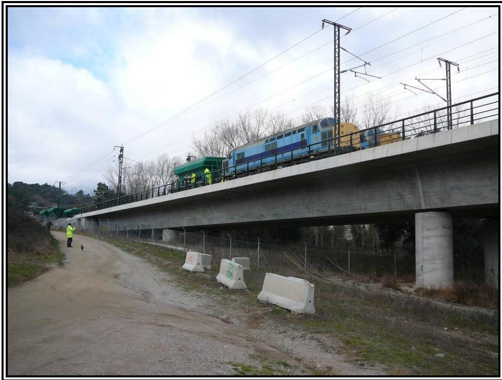
Nº 9.- Prueba estática, Estado 2 (carga en vano 2).
