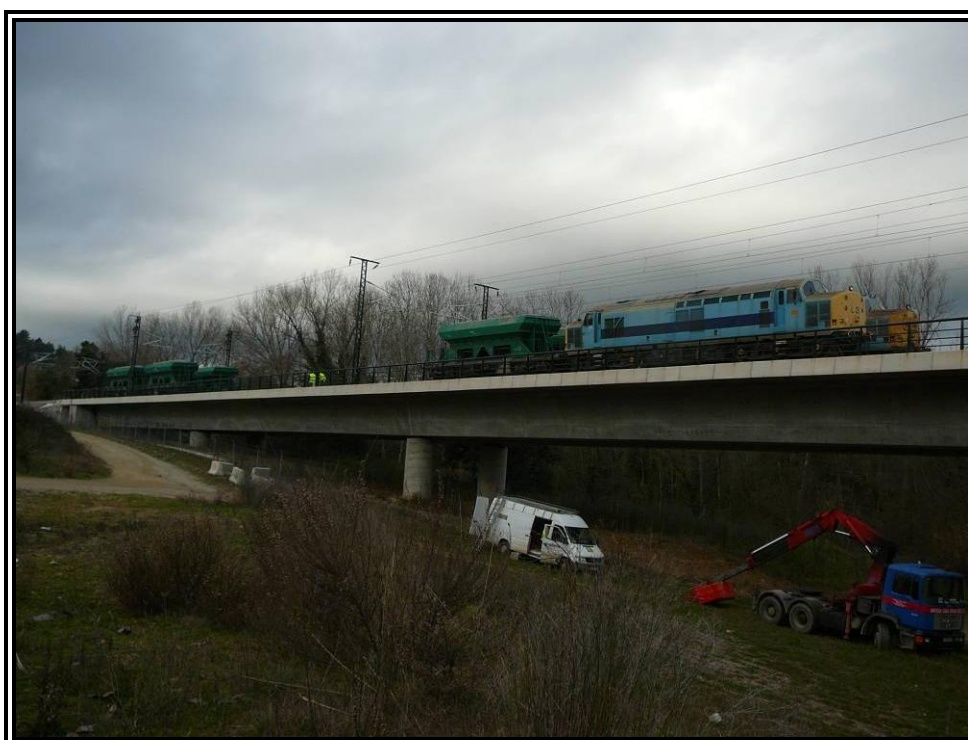
Nº 8.- Prueba estática, Estado 1 (carga en vanos 1 y 3).
