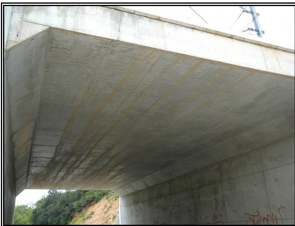
Nº 4.-Vista inferior de la estructura.
